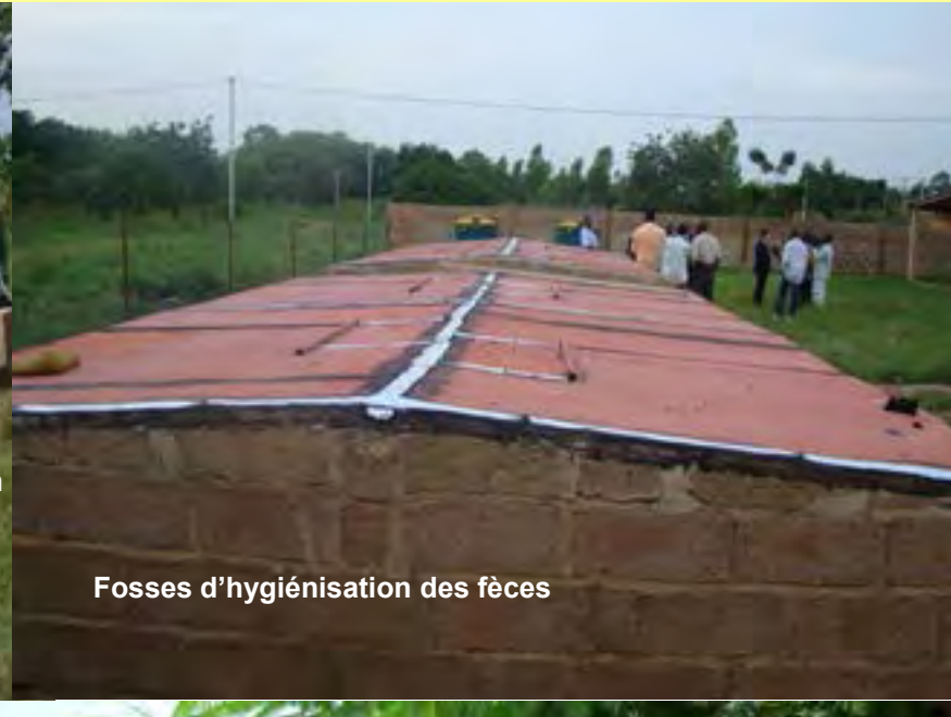
Site d'hygiénisation du secteur 27, dispositifs de stockage et d'hygiénisation des excréta
