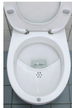
Figura 3: Baño (común) con separación de orina
