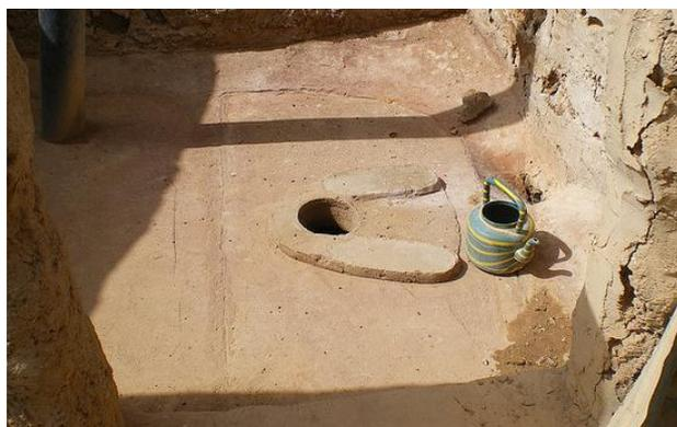
Figure 5: Cuvette simple dans une latrine traditionnelle au Burkina Faso. Sont visibles la dalle support de la cuvette et la conduite de ventilation de la fosse (source: A. Fall, 2009).
