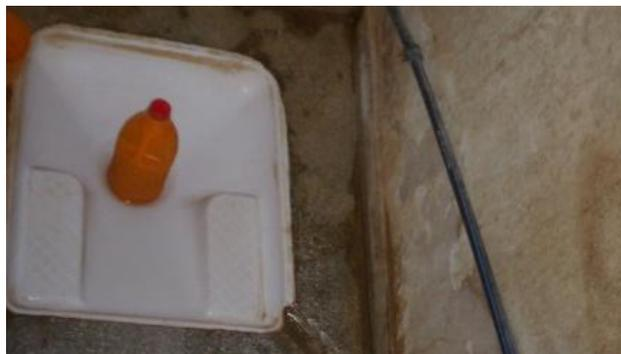
Figure 7: Cuvette simple en céramique sans siphon hydraulique placée dans une toilette rurale avec eau courante au Maroc. Noter l'utilisation d'un bidon en matières plastiques rempli d'eau pour obstruer l'orifice de la cuvette entre deux usages (source: M. Wauthélet, 2012).
