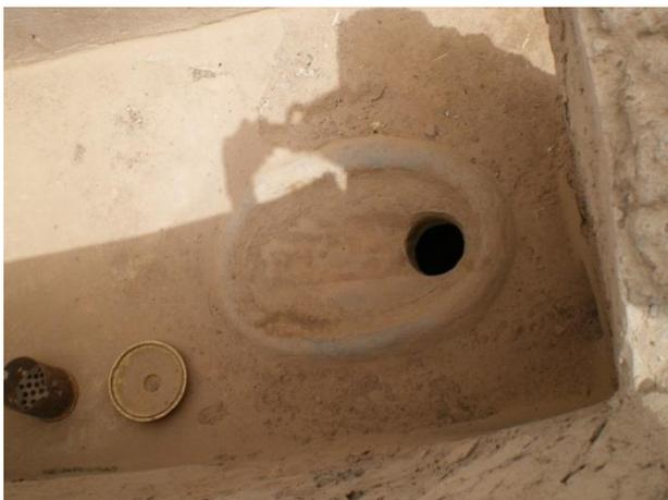
Figure 4: Cuvette simple équipant une latrine traditionnelle au Burkina Faso (source: A. Fall, 2009).
