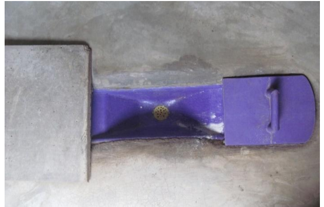
Figure 7: Cuvette à séparation d'urine pour une TDSU avec deux chambres de déshydratation sans section de lavage anal à Nairobi, Kenya; l'orifice d'évacuation de l'urine est commun aux deux orifices pour fèces dont seul celui de droite est en utilisation (source: E. von Muench, 2013).
