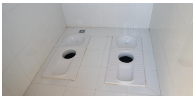
Figure 9: Deux cuvettes à séparation d'urine pour une TDSU à deux chambres à Dayet Ifrah, Maroc (en haut) (source: R. Ingle, 2012) et à Ait Idir, Maroc (source: AGIRE, 2015).
