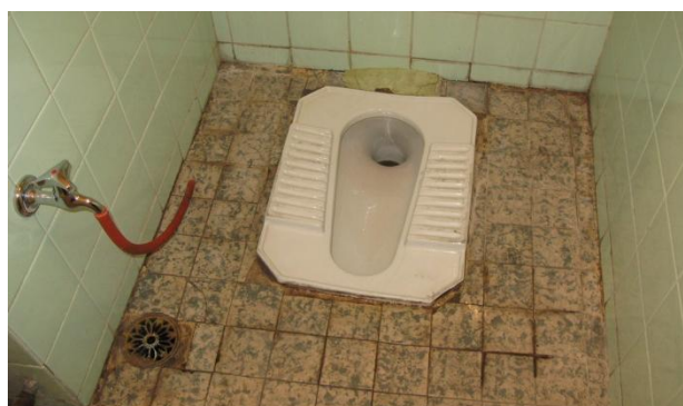
Figure 4: Cuvette à chasse mécanique dans une toilette desservant des bureaux à Damas, en Syrie. Noter le tuyau utilisé pour la lavage anal (source: E. von Muench, 2009).
