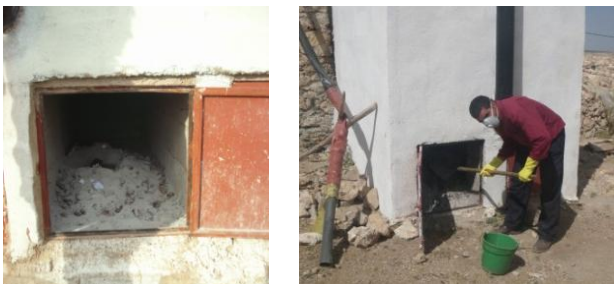
Figure 3: Chambres de déshydratation à Dayet Ifrah. A gauche: Vue des fèces en cours de déshydratation, à droite: vidange des fèces déshydratées (source: GIZ-AGIRE, 2013).
