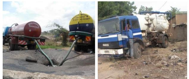
Figure 2: A gauche: Décharge de boues de vidange collecté par les camions de vidange à un point de réception dans une station d'épuration à Nairobi, Kenya (source: D. Mbalo, 2012); A droite: Vidange de la fosse septique d'un hôtel à Fada N'Gourma, Burkina Faso (source: F. Erzinger, 2007).
