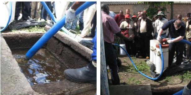
Figure 4: Démonstration du système eVac pour le pompage des boues de vidange de la fosse d'une latrine améliorée ventilées (VIP) (source: E. von Muench, 2012).
