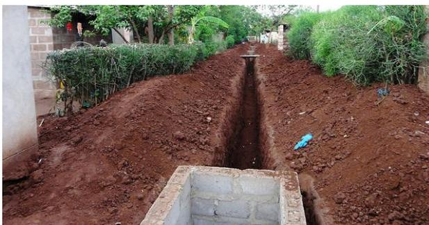
Figure 3: Travaux d'excavation pour la réalisation d'un réseau décanté à Libuyu (un quartier de Livingstone), Zambie. Le réseau comprend des regards de visites, une station de pompage, plusieurs toilettes et dix digesteurs fonctionnant comme décanteurs intermédiaires pour les matières solides (source: P. Feiereisen, 2011).
