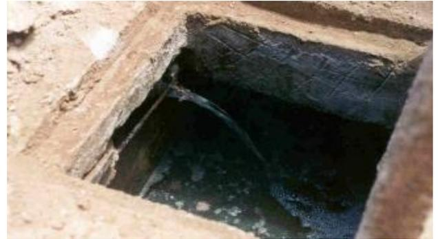
Figure 6: Regard de visite d'une fosse de décantation au niveau de ménage en aval du réseau d'égout décanté, le village Toug El Khir, Maroc (source: B. El Hamouri, 2002).
