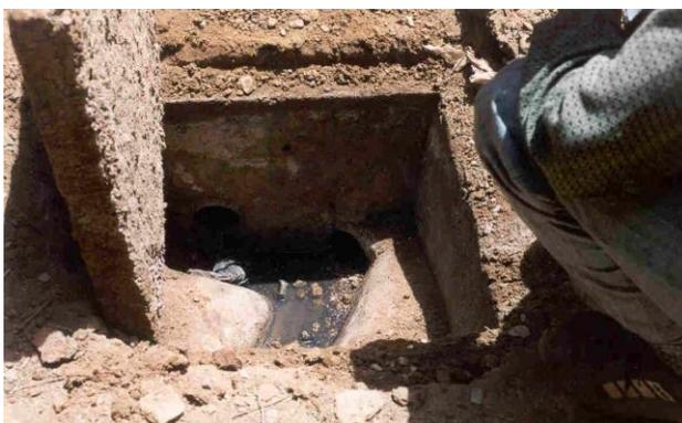
Figure 5: Réseau décanté à petit diamètre: regard de jonction de deux collecteurs village de Toug El Khir, Maroc (source: B. El Hamouri, 2002).
