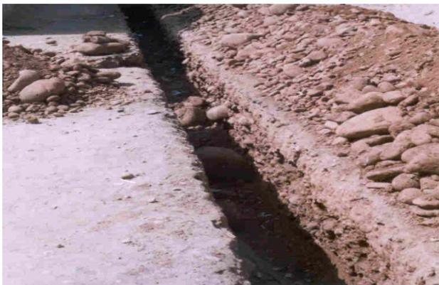
Figure 4: Travaux de réalisation du réseau décanté dans le village d'Ait Faska, Maroc (source: B. El Hamouri, 2003).
