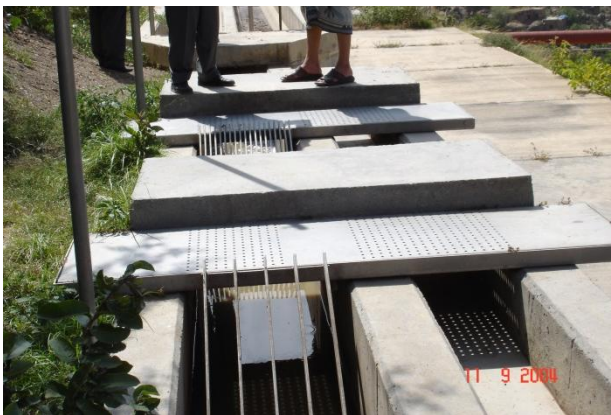
Figure 4: Dégrilleur à deux étages, d'abord à fort puis à faible écartement des barreaux à la station de la ville de Hajja, Yemen (source: El Hamouri, 2004).
