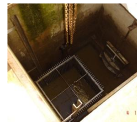
Figure 6: Panier dégrilleur amovible: à gauche: potence et palan de hissage; à droite: panier en place. Station de lagunage de M'Rirt, Maroc (source: El Hamouri 2005).
