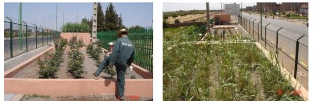
Figure 5: Filtre planté en opération pour le traitement de 30 m<sup>3</sup>/j des eaux grises du hammam de la ville d'El Attaouia sur une superficie de 200 m<sup>2</sup> avec filtre vertical à sable grossier planté de roseiers; et filtre horizontal à gravier et phragmites (source: El Hamouri, 2008).
