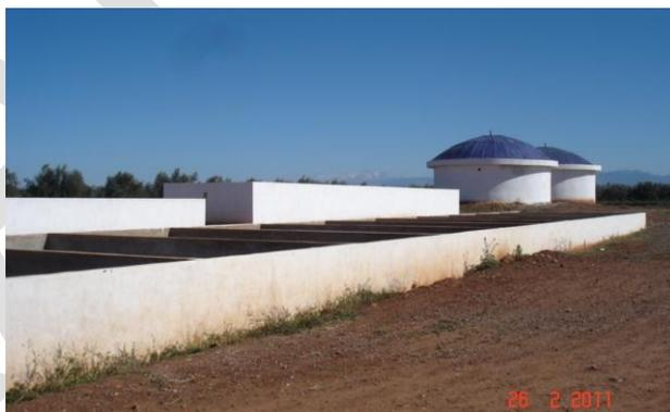
Figure 3: RAFADE d'El Attaouia extension en 2011. L'unité comporte: 2 réacteurs en série; 1 décanteur, 1 filtre à gravier et une batterie de lits de séchage (premier plan). Notez la couverture des réacteurs avec des coupoles en polyester (source: B. El Hamouri, 2011).
