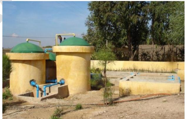
Figure 2: RAFADE en exploitation à Casablanca pour traiter les eaux usées d'une habitation privée (source: B. El Hamouri, 2004).
