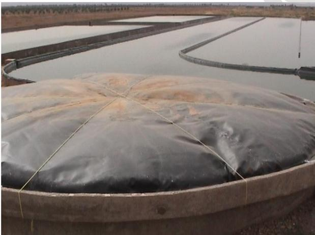
Figure 5: RAFADE d'El Attaouia début du projet Phase 1 (2003). Réacteur N°2 couvert à l'aide de PEHD: (polyéthylène à haute densité). En arrière plan: le chenal algal et les deux bassins de maturation en série (source: B. El Hamouri, 2003).
