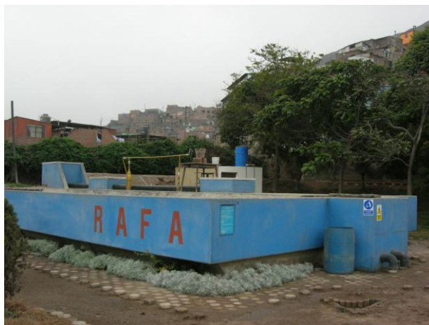
Figure 4: UASB traitant 860 m 3 /j des eaux usées à l'Université UNITRAR à Lima, Pérou (source: LeAF, 2010).
