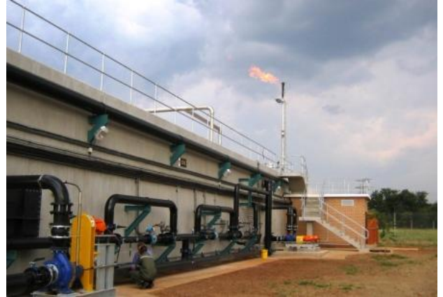
Figure 3: UASB avec torchage de l'excès de biogaz en Afrique du Sud (source: Talbot & Talbot).
