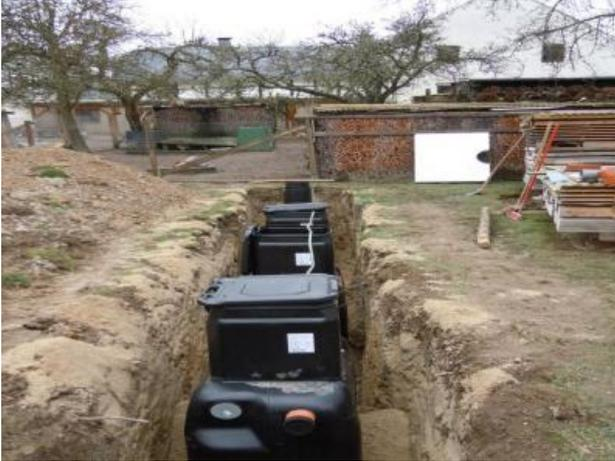
Figure 5: Mise en place des éléments préfabriqués en plastique de petite taille d'un RAC à Thüringen, Allemagne (source: AquaVerde, 2012).
