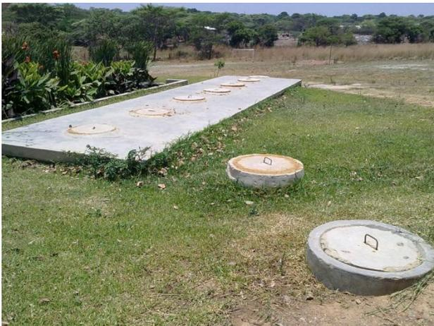
Figure 4: Système RAC connecté aux toilettes d'une école péri-urbaine en Lusaka, Zambie. Le RAC (en avant plan) est précédé d'un digesteur et est suivi d'un filtre planté (à gauche) (source: R. Ingle, 2010).
