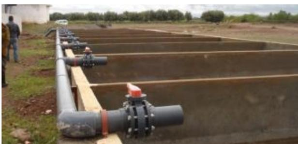
Figure 7: Batterie de 11 lits de séchage en construction pour l'extension de la station d'El Attaouia en 2012 (source: B. El-Hamouri, 2006 et 2012).
