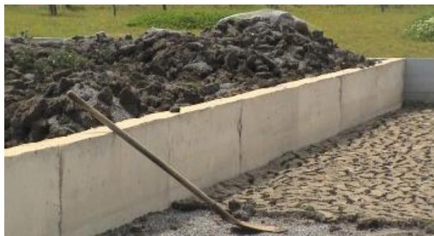
Figure 8: Lits de séchage pour les boues de deux digesteurs anaérobies à la station d'épuration de Skhirat située à 30 km au sud de Rabat (source: B. El-Hamouri, 2006 et 2008).
