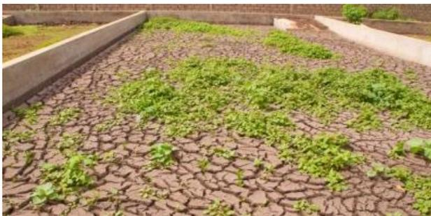
Figure 5: Lit de séchage pour des boues fécales dans une station d'épuration à Camberene, Sénégal (source: L. Strande, 2010).
