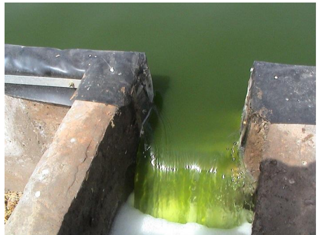
Figure 2: Réutilisation des eaux usées traitées à Attaouia après traitement: RAFADE suivi d'un chenal algal et de deux bassins de maturation en série (source: B. El Hamouri, 2007).
