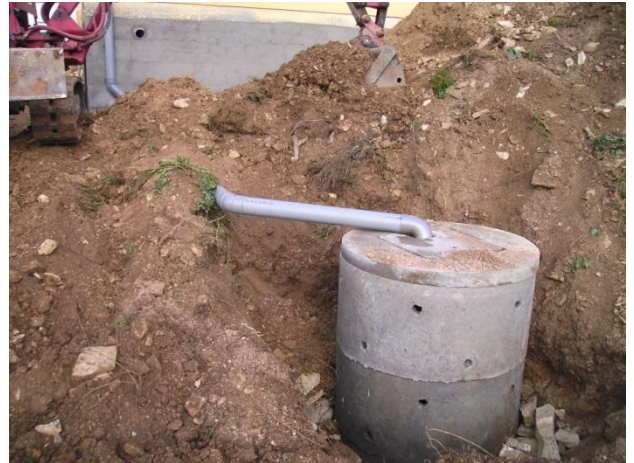
Figure 4: Puits construit dans une maison traditionnelle en France (source: Maisons Traditionnelles MIKIT, 2009).
