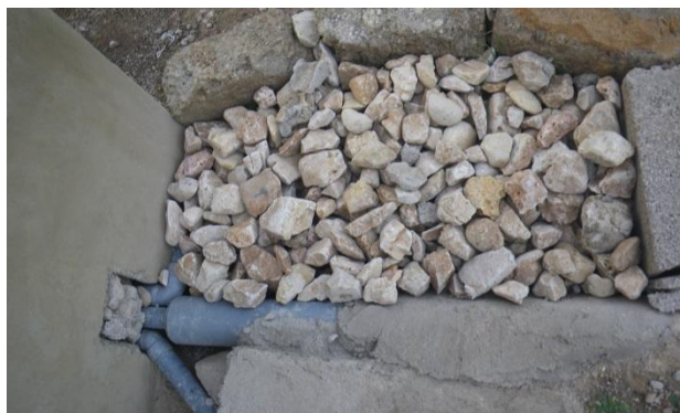
Figure 5: Puits d'infiltration pour l'eau de lavage anal d'une toilette TDSU à Dayet Ifrah, Maroc (source: M. E. Khiyati, 2009).
