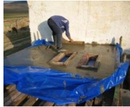
3 - Coulage de la dalle intermédiaire
