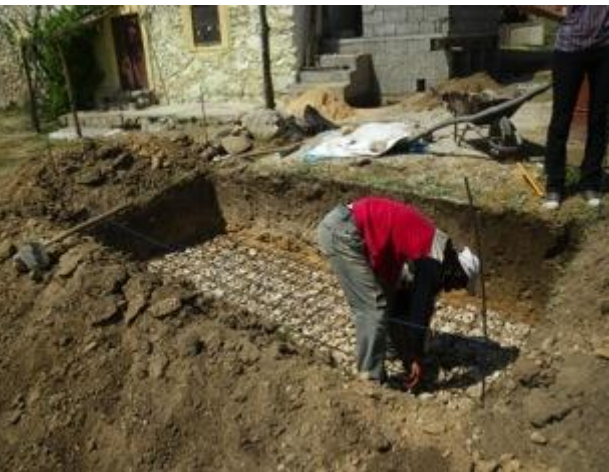
7 – Construction du filtre planté
