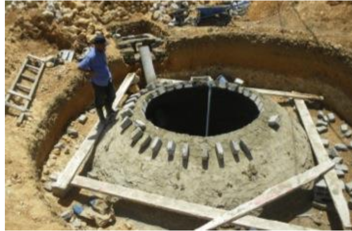
6 – fermeture du dôme du digesteur
