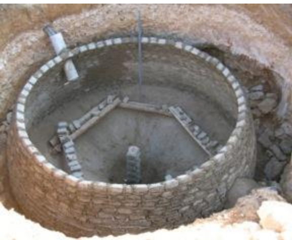
5– Construction du dôme du digesteur avec raccord d'entrée
