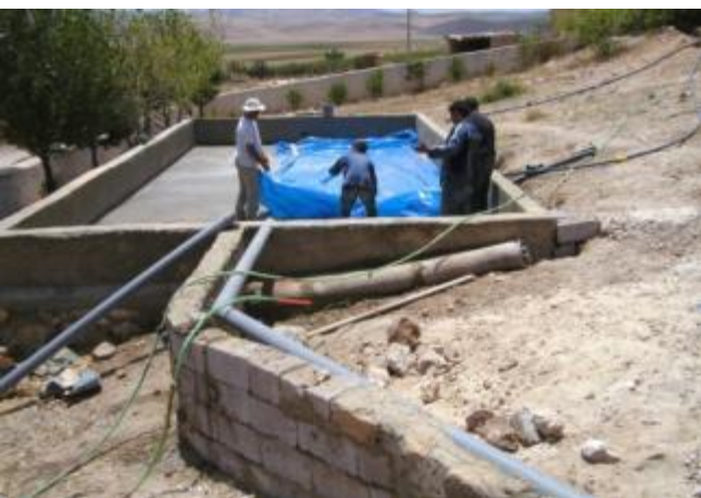
4 – installation des tuyaux et du massif filtrant
