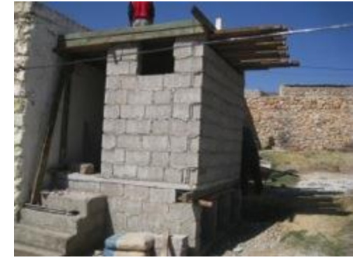
4 - Construction de la superstructure
