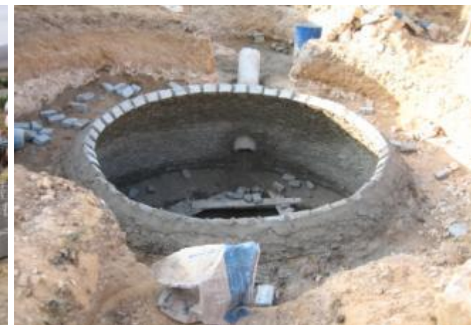
3 – construction du digesteur anaérobie pour le prétraitement
