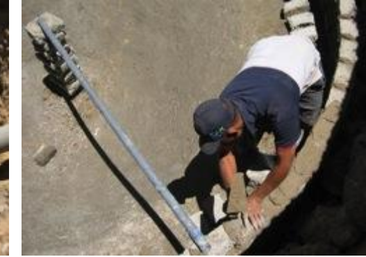
4 – pose des briques sous forme de dôme hémisphérique
