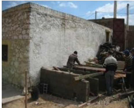
2 - Construction des chambres et coffrage
