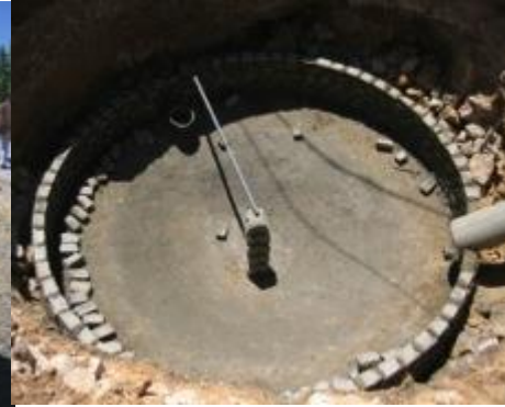
3 – pose de la première ligne de briques
