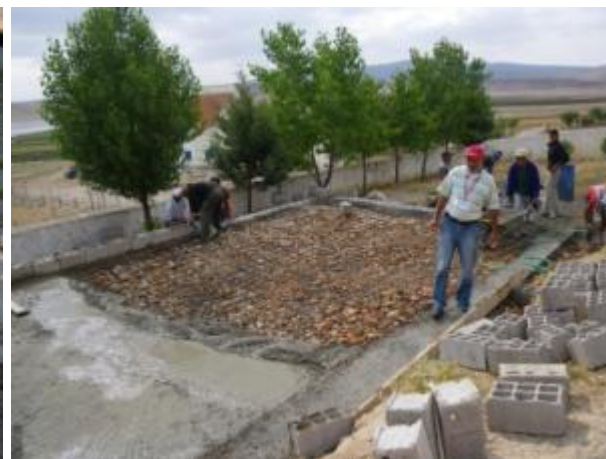
2 – construction de la dalle et du parois du filtre
