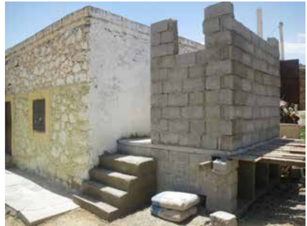
Image 155 : Escalier et superstructure sont finalisés. A droite la dernière ligne de briques est encore omise pour pouvoir placer des madriers comme support pour le toit.
