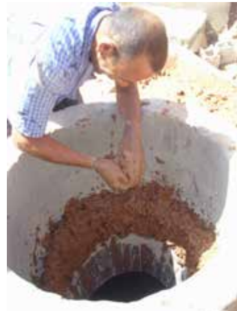
Image 472 : Application d'un lit d'argile (avec un peu de chaux, ciment et eau) sur le cône du couvercle.
