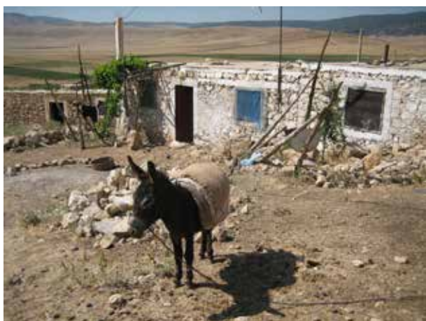
Image 8 : Bâtiment typique avec toit plat en béton armé.
