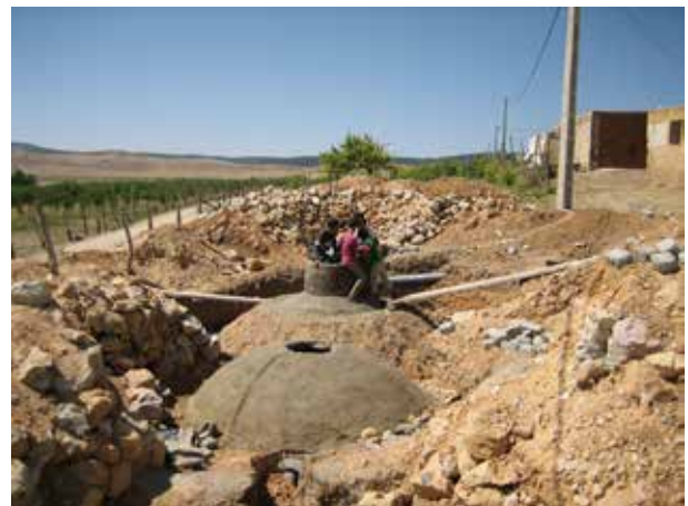
Image 447 : Le dôme du bassin d'expansion est finalisé et remblayé par couches successives de terre. Le tuyau de sortie est placé.
