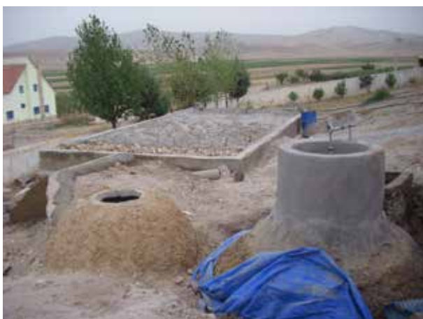
Image 584 : Vue de la station d'épuration avant d'ajouter des remblais.
