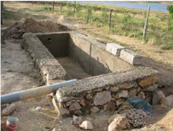
Image 214 : Le tuyau d'entrée avant son placement.
