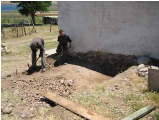
Image 128 : Travaux d'excavation pour la fondation.
