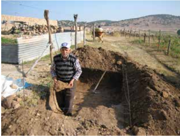
Image 200 : Travaux d'excavation pour le filtre planté.
