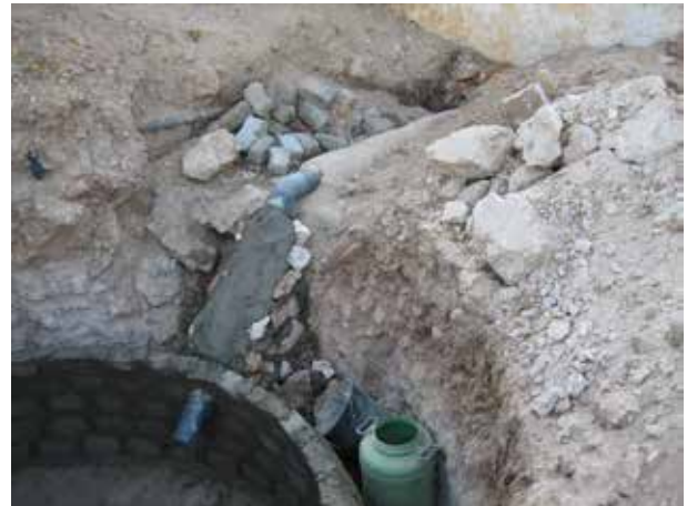
Image 506 : La buse d'alimentation venant de la mosquée est aussi posée.
