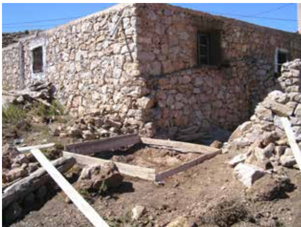
Image 234 : La nouvelle toilette sera emplaced derrière la maison de la famille bénéficiaire.
