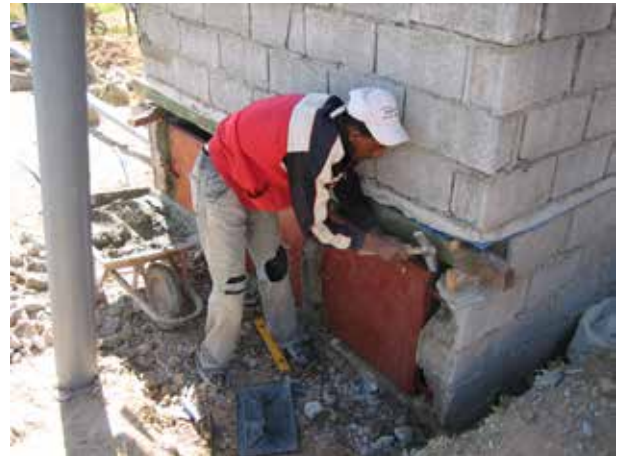
Image 167 : Installation des trois portes des fosses.
