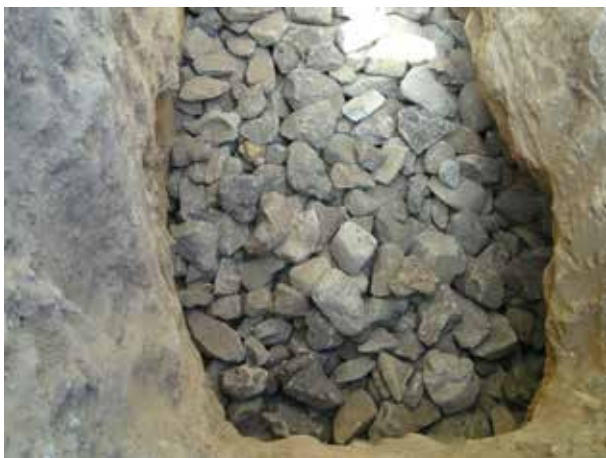
Image 185 : La première couche de moellons dans le puisard.
