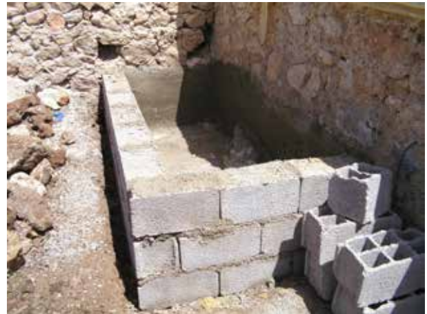
Image 363 : Les murs du filtre sont construits et une première couche d'enduits est appliquée.
