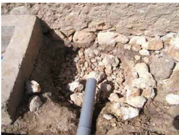
Image 350 : Une couche de moellons est placée à la superficie du puisard.
