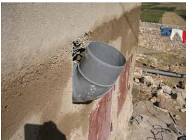
Image 78 : Placement provisoire du coude 45° du tuyau de ventilation entre les 2 fosses de collecte de matière fécale.
