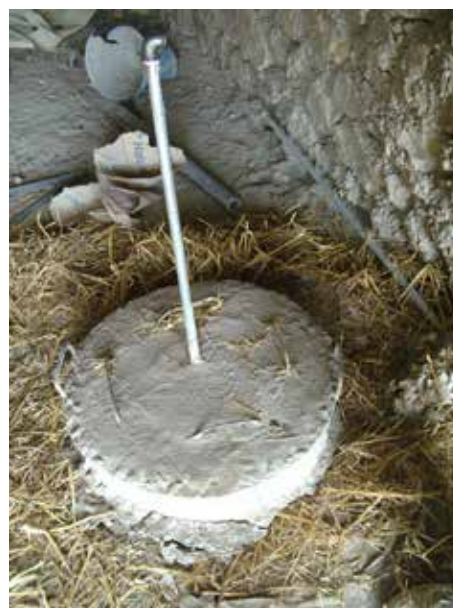
Image 470 : Couvercle du digesteur avec quatre poignées et tuyau galvanisé.
