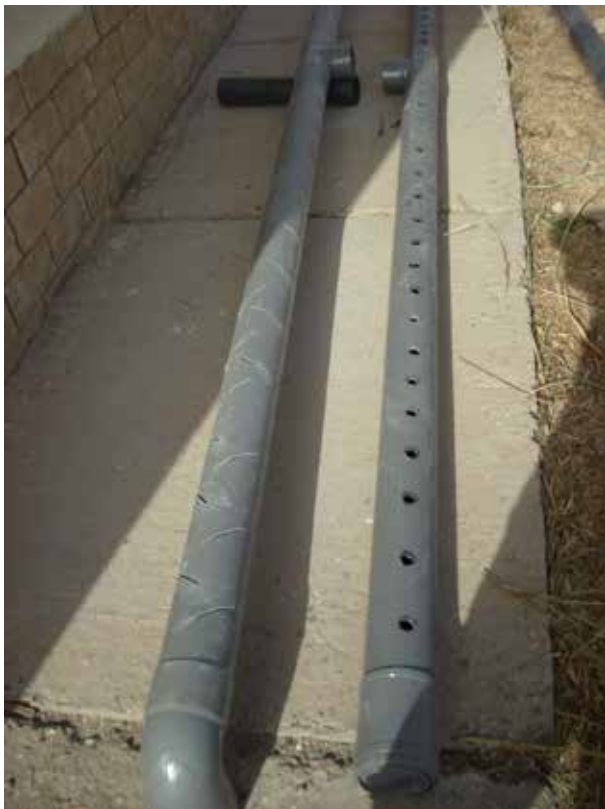
Image 572 : Préparation des tuyaux d'alimentation et de sortie.
