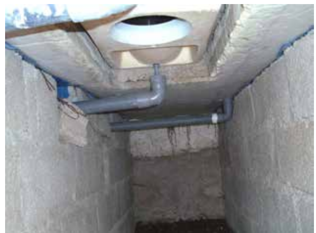
Image 180 : Vue de la tuyauterie dans l'autre fosse (placement provisoire).
