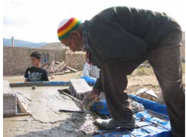
Image 257 : Distribution du béton.
