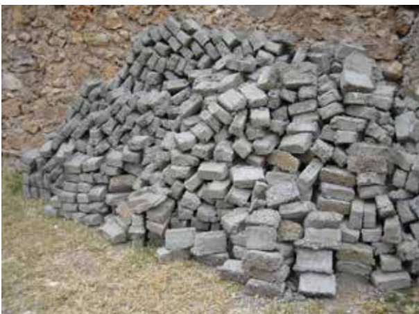
Image 387 : Blocs de béton prêts.
