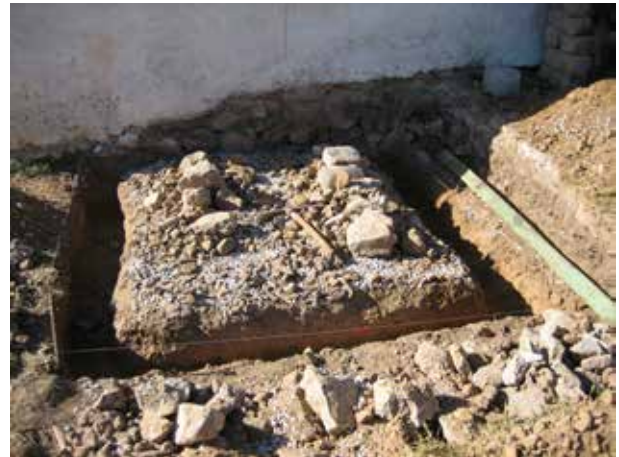
Image 129 : Excavation terminée avec corde de délimitation.
