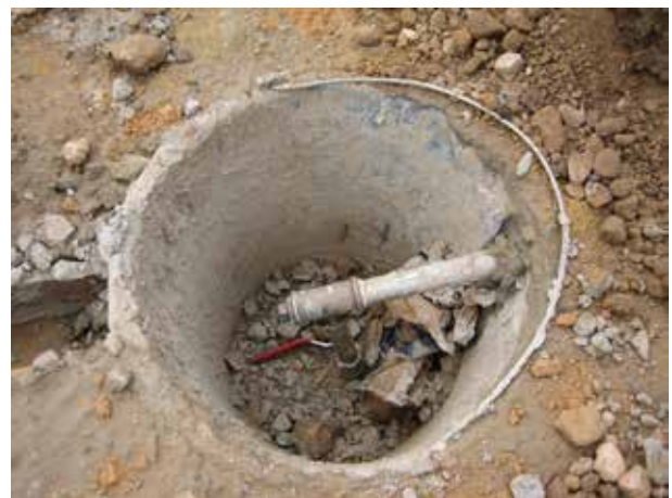
Image 443 : Construction d'un regard à l'aide d'un seau.
