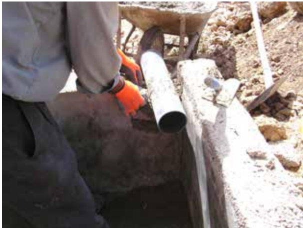
Image 291 : Mise en place du tuyau de sortie.
