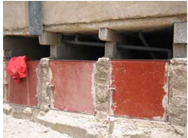
Image 75 : Les portes des fosses sont fixées.
