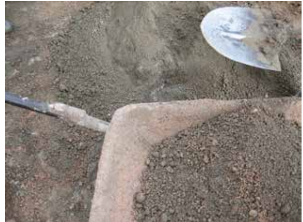
Image 39 : Préparation du béton pour la dalle.
