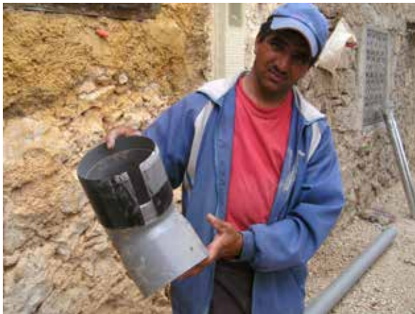
Image 336 : Coude 45° prolongé avant l'installation.
