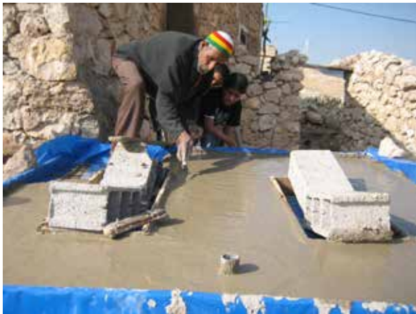
Image 258 : Le maçon lisse la superficie à l'aide d'une truelle. Le tube au milieu montre l'emplacement de l'urinoir.
