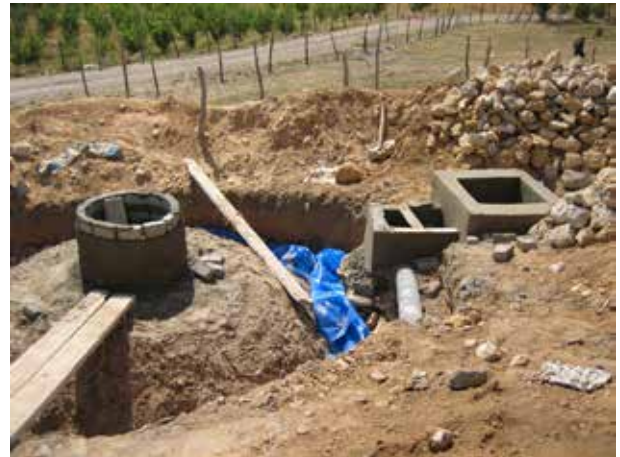
Image 455 : Vue de la couronne et du bac d'alimentation.
