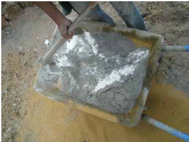
Image 562 : Préparation d'un mortier d'étanchéité (avec du SikaLite) pour les enduits.
