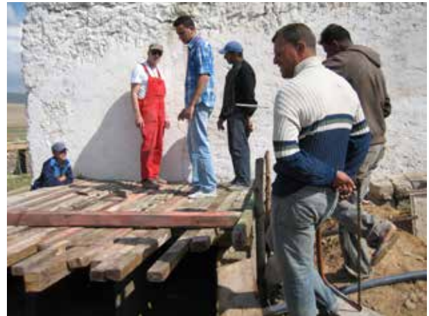
Image 140 : Installation d'un coffrage pour la dalle.
