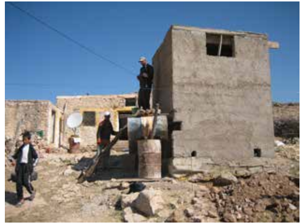
Image 69 : Echafaudage improvisé pour l'application des enduits. Le trou gauche dans le mur est la sortie des eaux grises et de nettoyage anal, le trou droite la sortie de l'urine.
