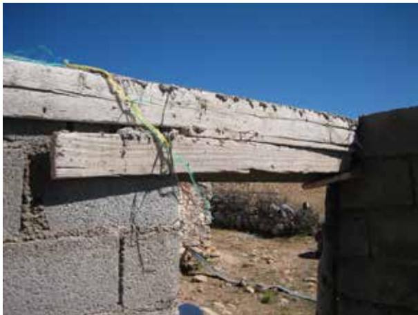
Image 54 : Coffrage du linteau pour la porte.
