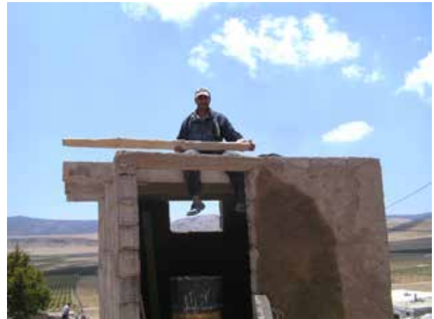
Image 59 : Préparation du support pour le toit. Le linteau au-dessus de la porte est déjà sec.
