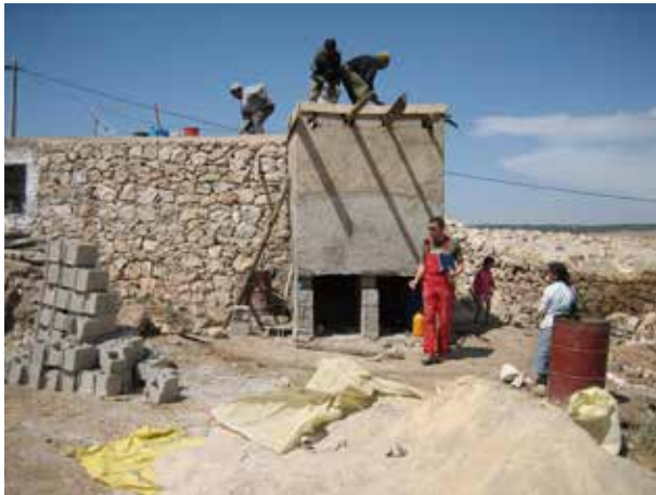
Image 272 : Le support et le coffrage pour le toit sont prêts.
