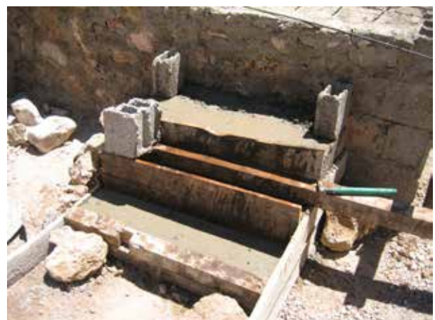
Image 314 : Construction de la 3 ème marche de l'escalier.
