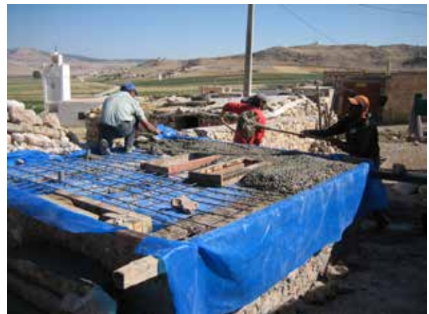
Image 308 : Distribution du béton.
