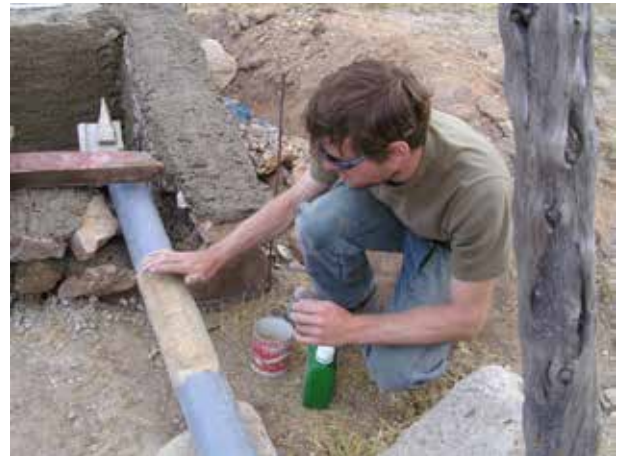
Image 213 : Application de colle PVC et sable sur la partie qui traversera le mur.
