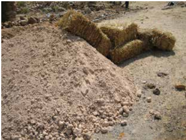
Image 693 : Argile (sèche) et paille pour isoler le digesteur.
