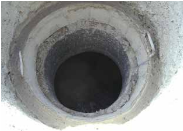
Image 529 : Le moule du couvercle est utilisé pour former le cône destiné à recevoir le couvercle.
