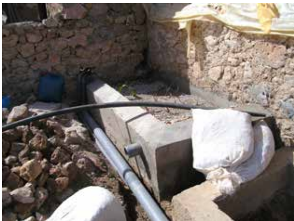
Image 372 : Le filtre est finalisé. Quelques roseaux sont déjà plantés.
