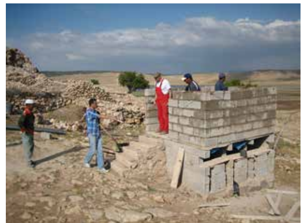
Image 51 : Construction des murs, vue 2.
