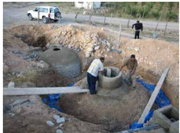
Image 459 : Les deux dômes hémisphériques sont construits.
