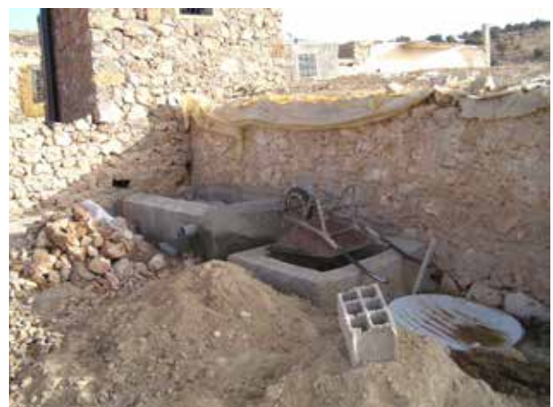
Image 351 : Vue du filtre planté, du réservoir d'urine et du puisard (couvert par la planche ronde).
