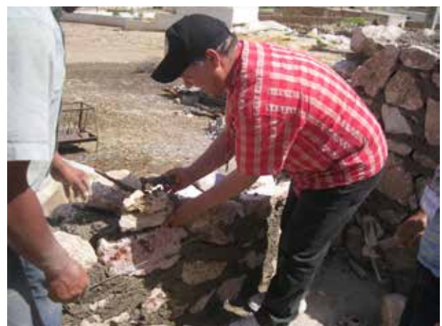
Image 636 : Les participants de l'atelier gagnent de l'expérience pratique sur les chantiers (TDSU Khaled).
