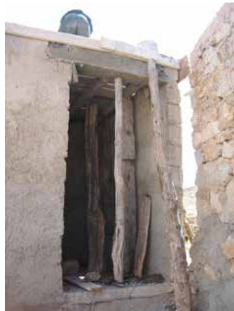
Image 271 : Support pour le toit de la TDSU. Le linteau est fait.
