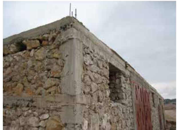
Image 704 : Pilier angulaire dans un bâtiment traditionnel à Dayet Ifrah.
