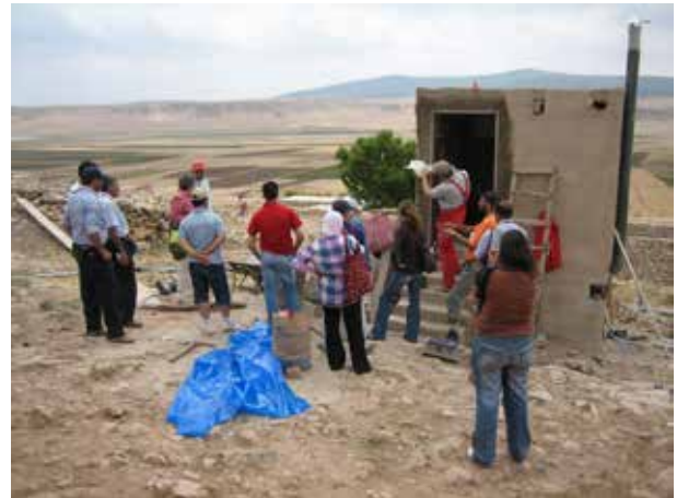
Image 626 : Les participants de l'atelier gagnent de l'expérience pratique sur les chantiers (TDSU Ferhaoui).
