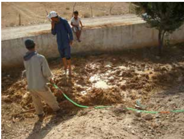
Image 525 : Arrosage du mélange d'argile et de paille.
