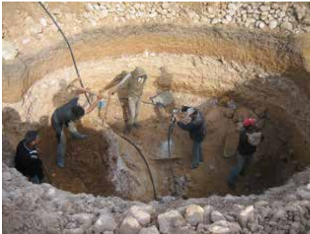
Image 379 : Utilisation du marteau pneumatique pour l'élimination du rocher.
