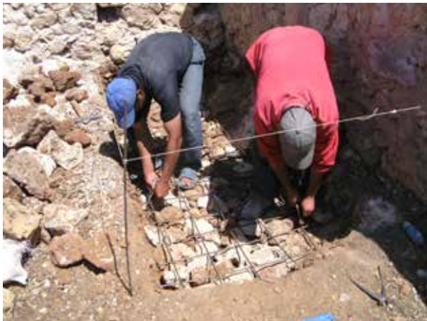
Image 358 : Préparation du ferrailage pour la dalle du filtre planté.
