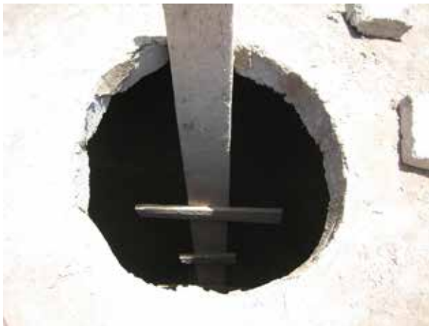
Image 423 : Echelle pour entrer le digesteur.
