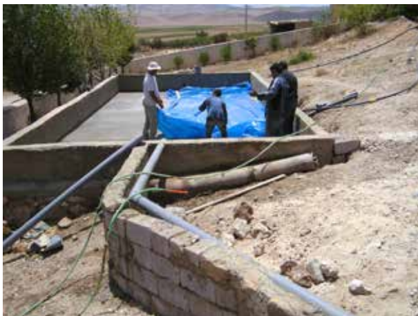
Image 566 : Placement d'un plastique au fond du bassin.
