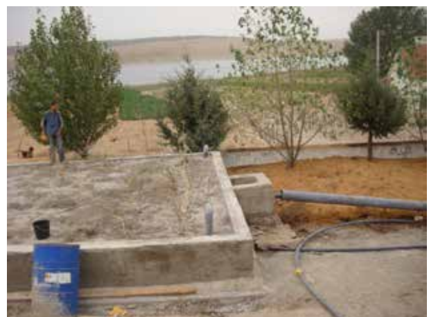
Image 585 : Vue finale du côté sortie du filtre planté.
