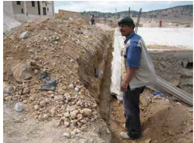
Image 484 : Tranchée pour le tuyau des eaux usées.
