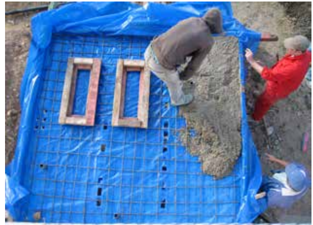
Image 146 : L'épaisseur de la dalle est de 8 cm. On voit les trois garde-places pour les conduites de l'urinoir, du lavabo et de la douche.
