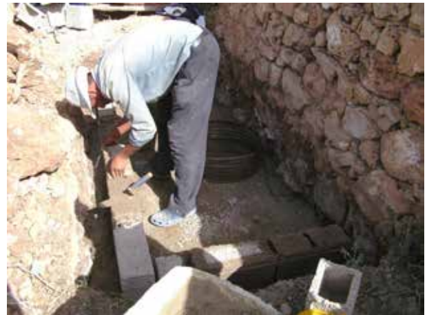
Image 288 : Maçonnerie sur la dalle du filtre.
