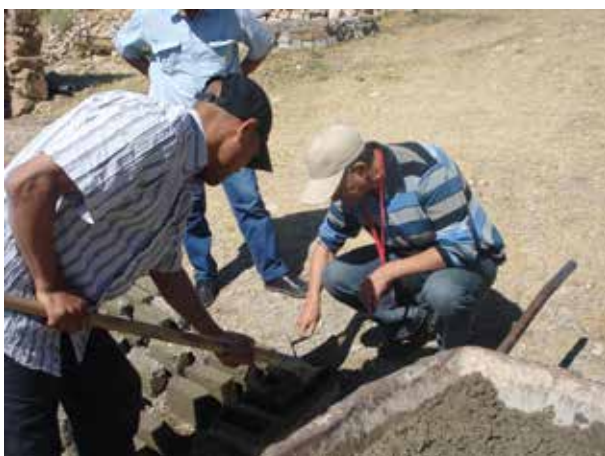
Image 653 : Les participants de l'atelier gagnent de l'expérience pratique sur les chantiers (digesteur).
