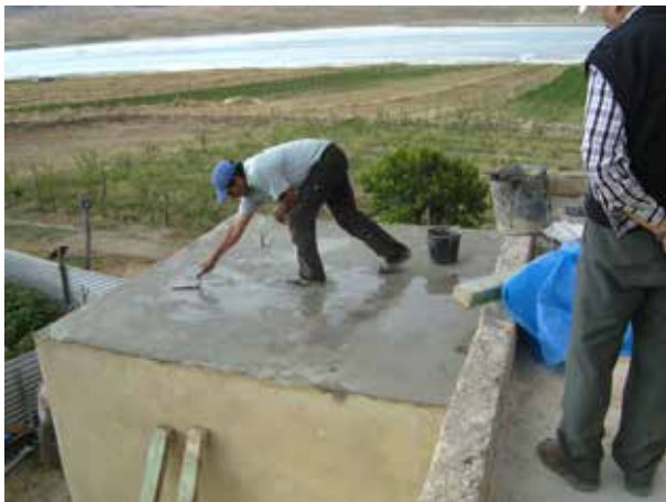
Image 174 : Application d'une nouvelle couche d'enduits étanches sur le toit pour colmater les fissures.
