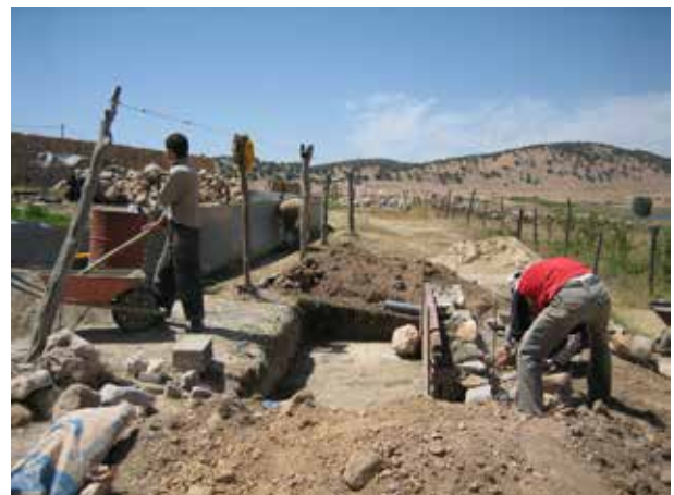
Image 205 : Maçonnerie avec pierres naturelles.
