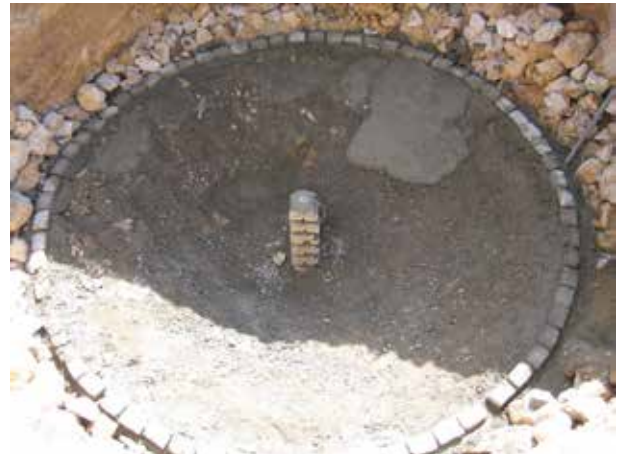
Image 391 : La première rangée de blocs est posée autour de la cuve à l'aide de la baguette de mesure.
