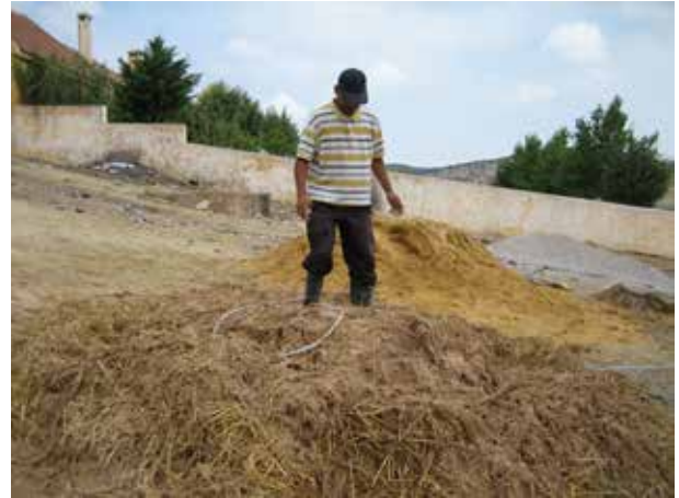
Image 449 : Argile et paille sont soigneusement mélangées.
