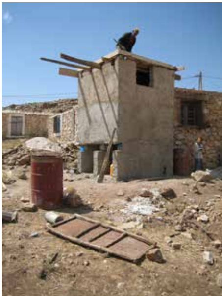
Image 270 : Installation du coffrage pour le toit.
