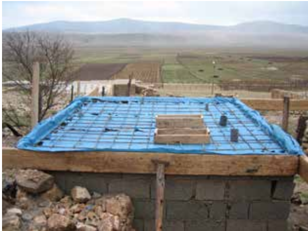
Image 38 : Coffrage et ferrailage avec cadres finalisés.
