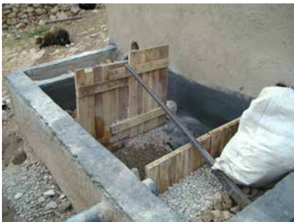
Image 127 : Le filtre planté en train d'être rempli.
