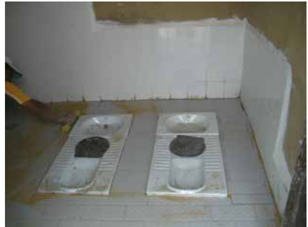
Image 343 : Vue des sièges après la pose du carrelage.
