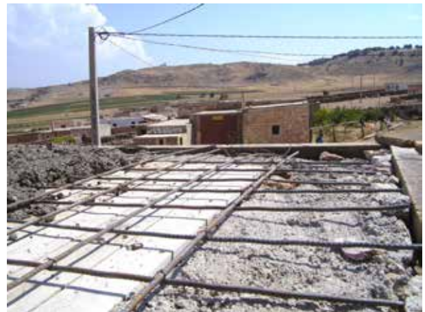
Image 330 : Vue du support et ferrailage de la toiture.
