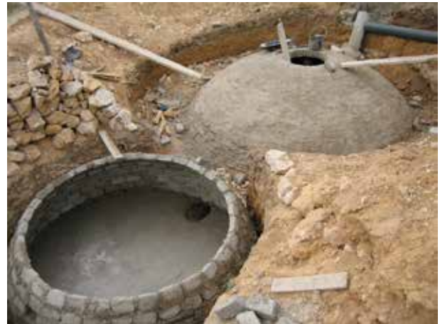
Image 445 : Le bassin d'expansion est construit comme le digesteur à l'aide d'un clou au centre et une baguette de mesure.
