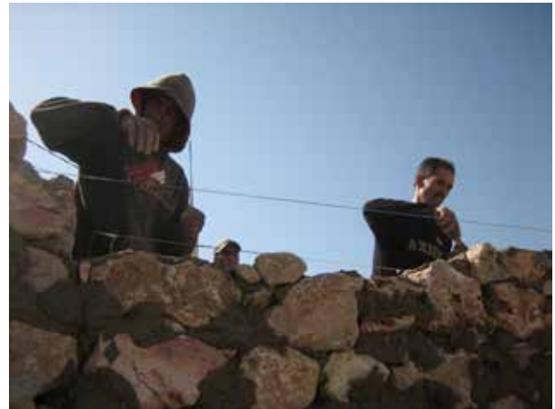
Image 320 : Construction à l'aide de cordes de délimitation.
