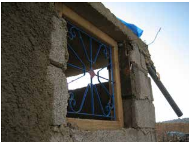
Image 170 : La fenêtre est installée.
