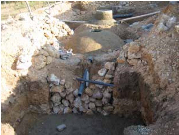
Image 460 : Le radier de la fosse de stockage des effluents est posé.
