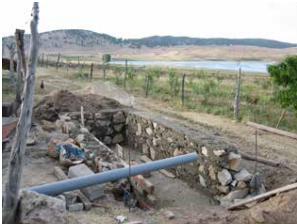
Image 208 : Il faut prévoir des réservations pour les tubes d'entrée et de sortie.
