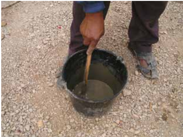
Image 368 : Préparation du lait de ciment avec un peu de SikaLite.
