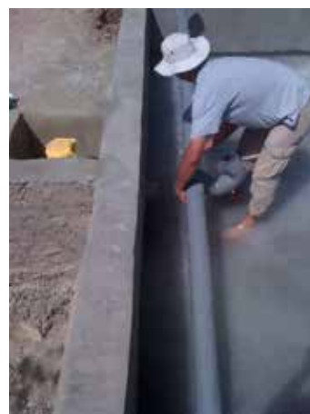
Image 569 : Installation du drain à la sortie du filtre.
