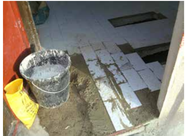
Image 103 : Pose du carrelage.
