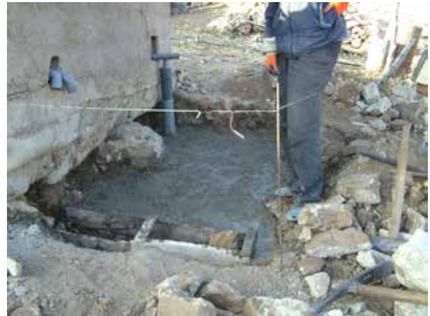
Image 114 : La fondation (dalle) du filtre à planté est bétonnée. La niche coffrée en avant-plan est prévue pour l'infiltration directe des eaux de nettoyage anal.
