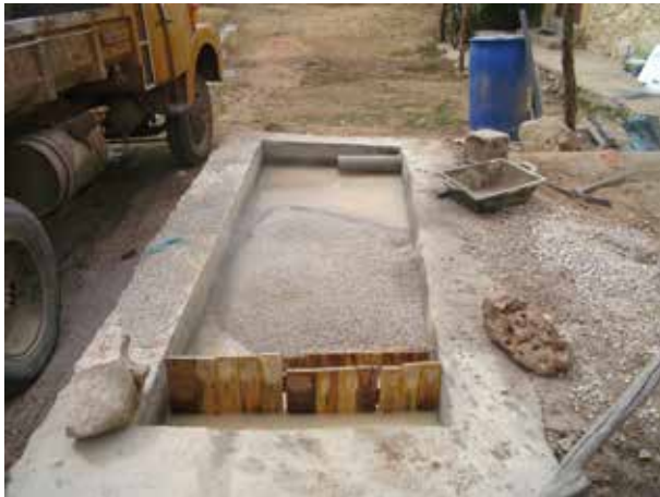
Image 228 : Mise en place du matériau de filtre.
