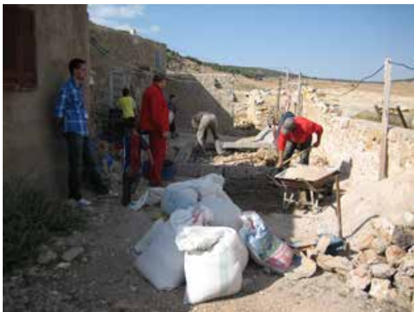
Image 297 : Les ouvriers en train de bétonner la fondation.
