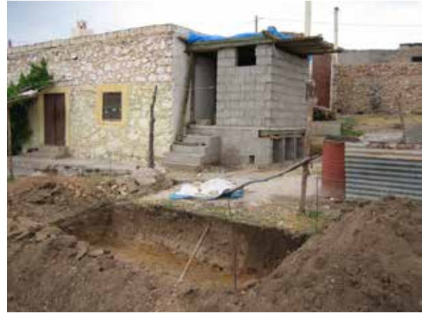
Image 201 : Aperçu du chantier, avec excavation finalisée.
