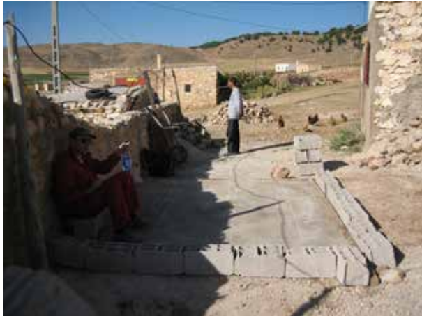
Image 299 : Les murs sont dessinés dans la fondation sèche.
