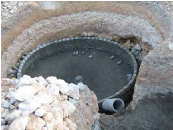
Image 408 : La cuve du digesteur en construction.
