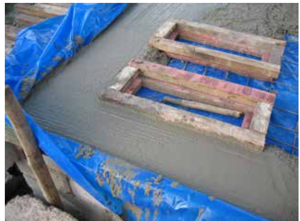
Image 150 : Deux cadres forment des refouillements pour les sièges de toilette.
