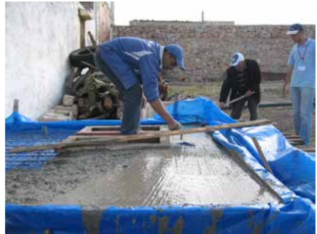
Image 148 : Le maçon lisse la superficie à l'aide d'une truelle.
