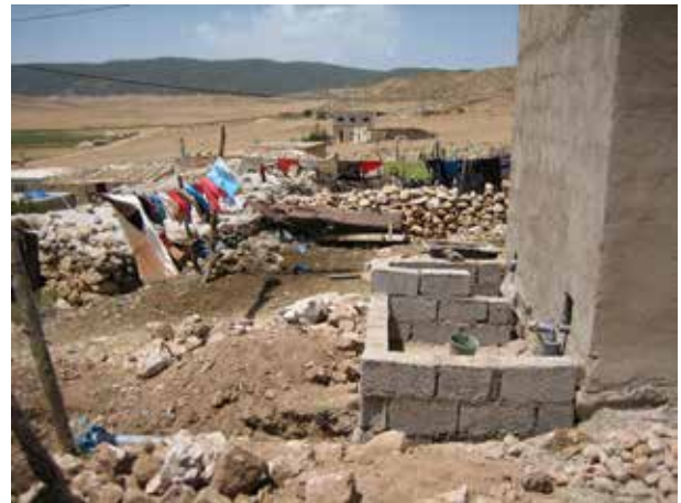
Image 116 : Vue latérale du chantier du filtre planté.
