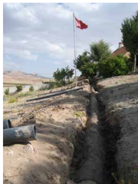
Image 500 : Le tuyau PVC est enrobé d'une couche de sable stabilisé au ciment.
