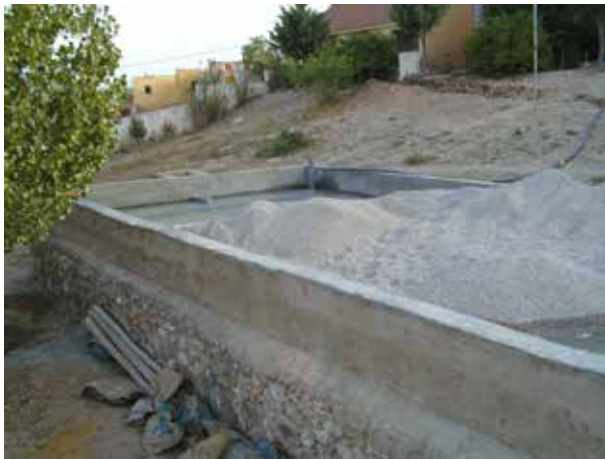
Image 570 : Placement des graviers dans le bassin.
