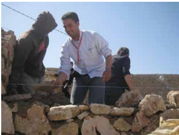
Image 639 : Les participants de l'atelier gagnent de l'expérience pratique sur les chantiers (TDSU Khaled).
