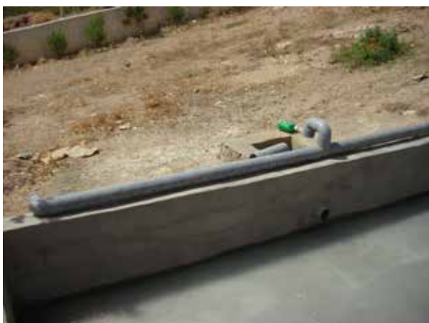
Image 568 : Tuyau de sortie (drain) des eaux avant son placement dans le bassin.
