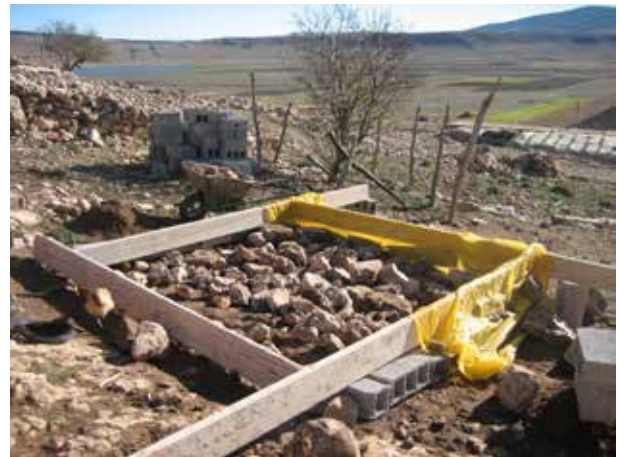
Image 17 : Pour épargner du béton le volume de la fondation est partiellement rempli de pierres.
