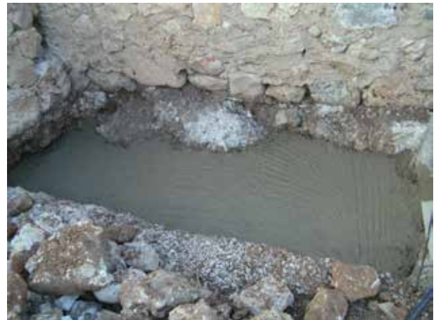
Image 359 : La dalle est bétonnée.
