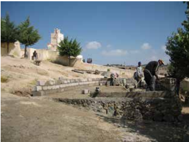
Image 556 : Construction des parois du filtre planté.
