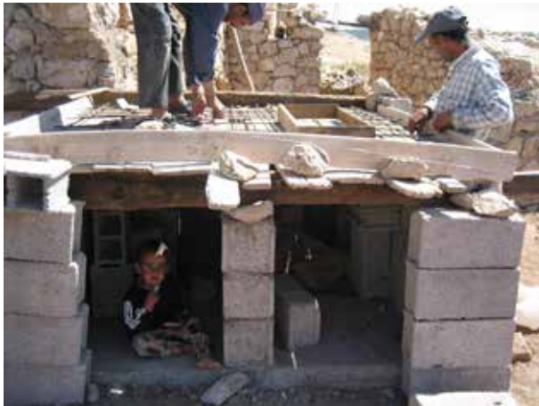
Image 250 : Vue du support et du coffrage pour la dalle.
