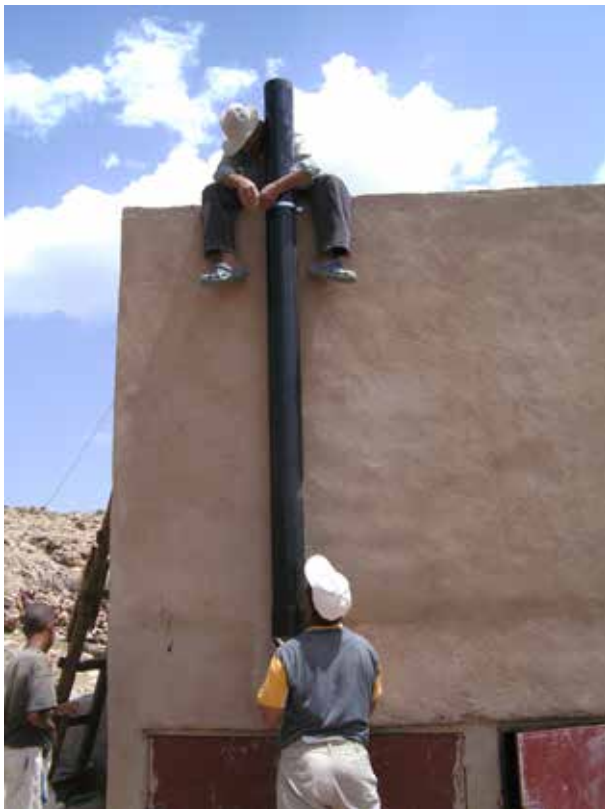
Image 92 : Fixation du tuyau de ventilation par un collier.
