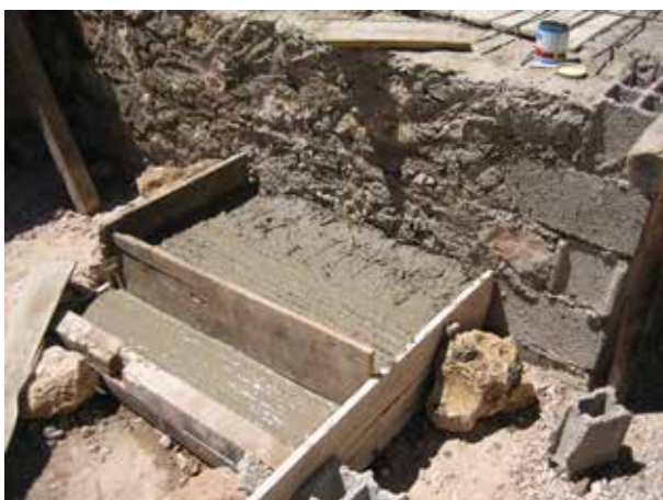
Image 313 : Construction de la 2 ème marche de l'escalier.
