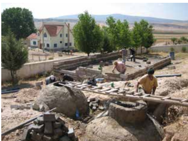
Image 521 : Vue du chantier pendant la construction de la couronne de couvercle.
