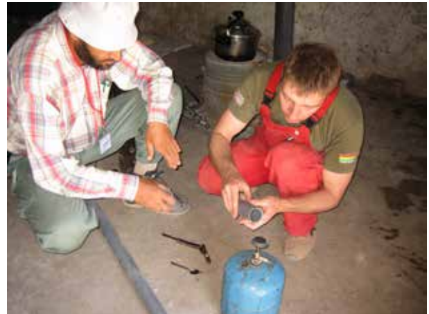
Image 85 : Chauffage d'un tuyau PVC pour faire un manchon.
