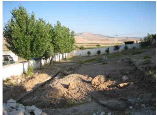
Image 535 : Site préparé pour le bassin du filtre.
