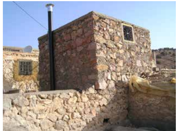
Image 339 : Le tuyau de ventilation est installé.
