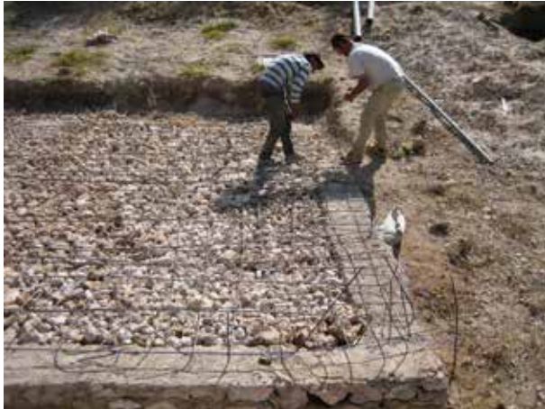
Image 544 : Placement des fers ronds pour la dalle horizontale en béton armé.
