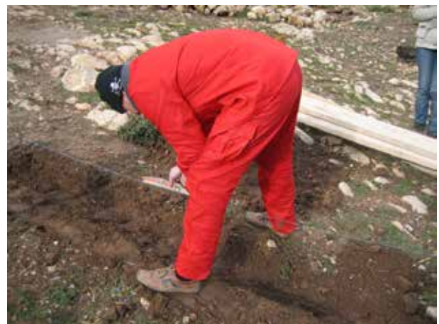
Image 15 : Préparation d'un coffrage horizontal à l'aide d'une corde de délimitation.
