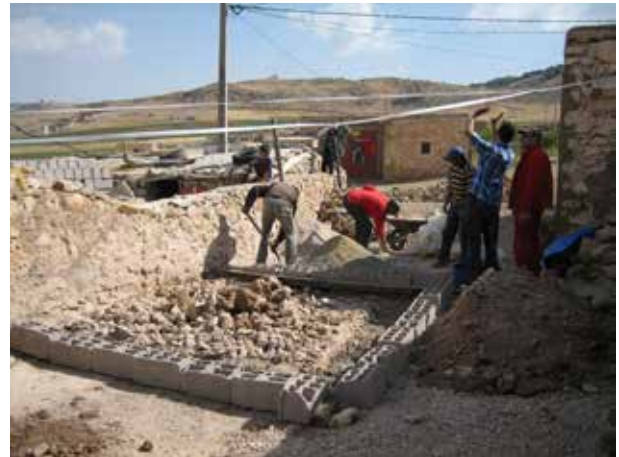
Image 296 : La TDSU sera attaché au mur existant. Le coffrage pour la fondation est préparé.
