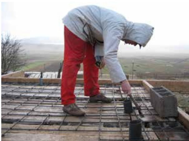
Image 36 : Finalisation du ferrailage et placement des garde-places pour les trous.
