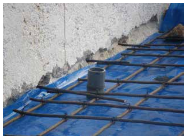
Image 144 : Le ferrailage entre dans le mur pour garantir une bonne liaison entre TDSU et maison. Des pièces de tube forment des trous dans la dalle pour la tuyauterie.
