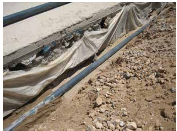
Image 488 : Le tuyau PVC 110 mm est placé dans la tranchée.
