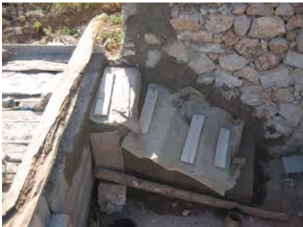
Image 248 : L'escalier finalisé est couvert pendant le séchage.
