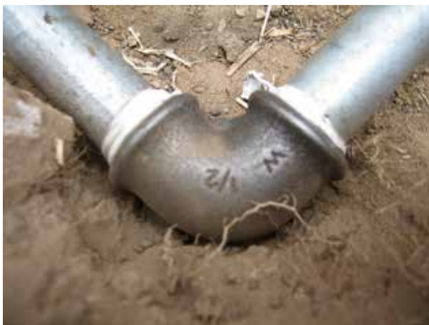
Image 442 : Tout les raccords sont munis de Teflon pour garantir l'étanchéité parfaite.
