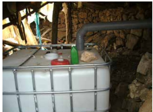
Image 99 : Le réservoir d'urine est placé dans l'étable et le tuyau plongeur est branché.
