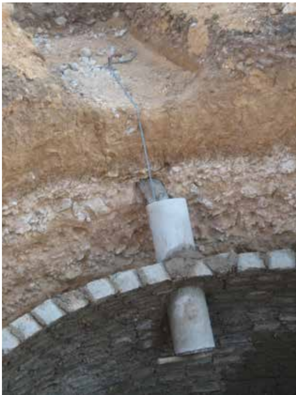
Image 410 : La buse d'alimentation est posée et arrimée à l'aide d'un piquet et une corde.
