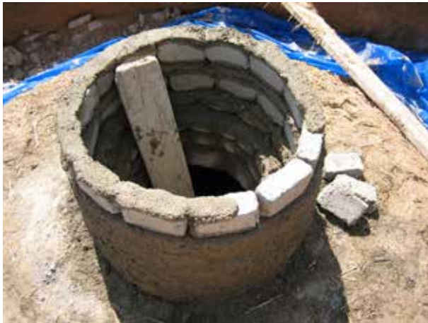
Image 454 : La couronne de couvercle est construite de plusieurs rangées de briques.
