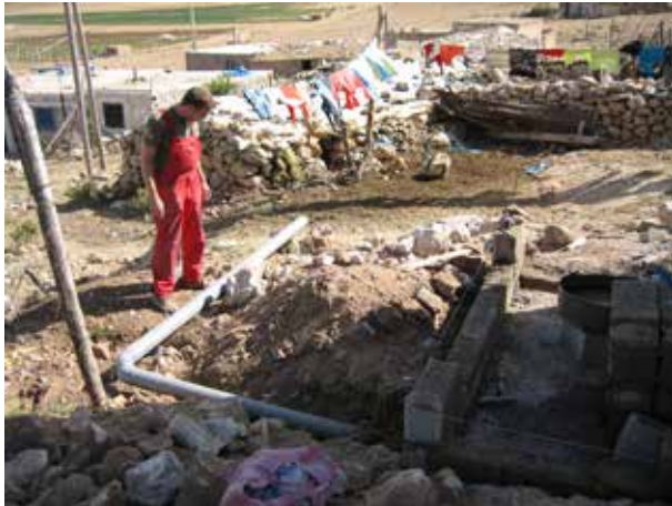
Image 94 : Installation de la conduite d'urine en direction de l'étable.
