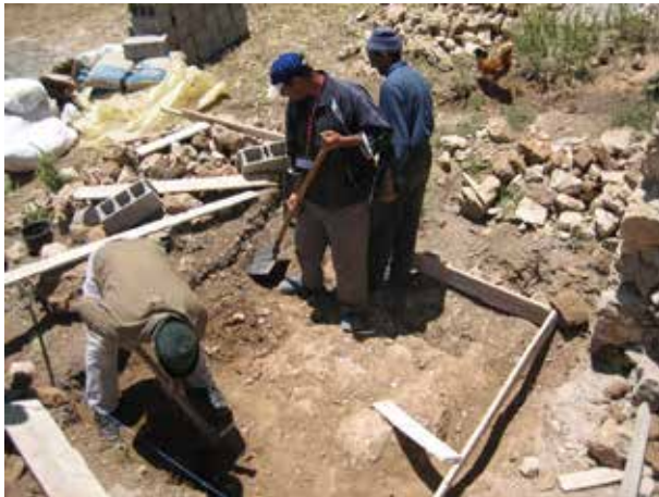
Image 232 : Travaux d'excavation pour la fondation de la TDSU.
