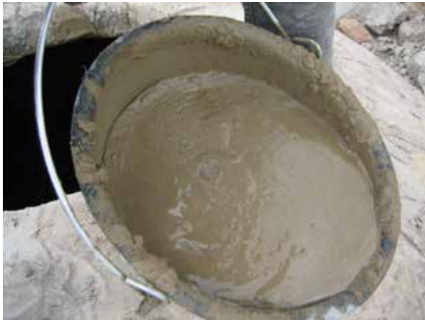
Image 517 : Lait de ciment pour l'enduit à l'intérieur du digesteur et du bassin d'expansion.
