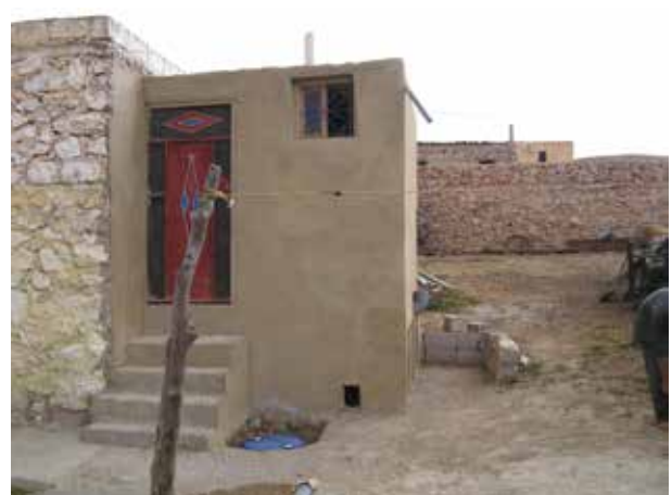
Image 171 : La TDSU après l'application des enduits. Le réservoir d'urine est déjà en place (en bas).
