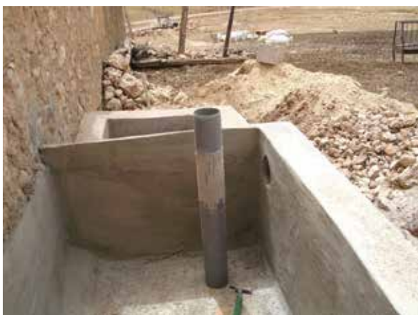
Image 366 : le tube de sortie avant son placement.
