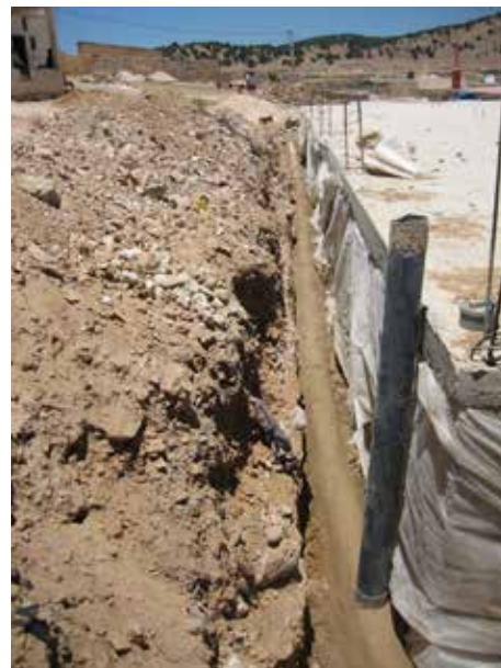
Image 492 : Le tuyau des eaux usées est enrobé d'une couche de sable stabilisé au ciment. Le tuyau vertical est prévu pour un futur branchement de la maison à droite.
