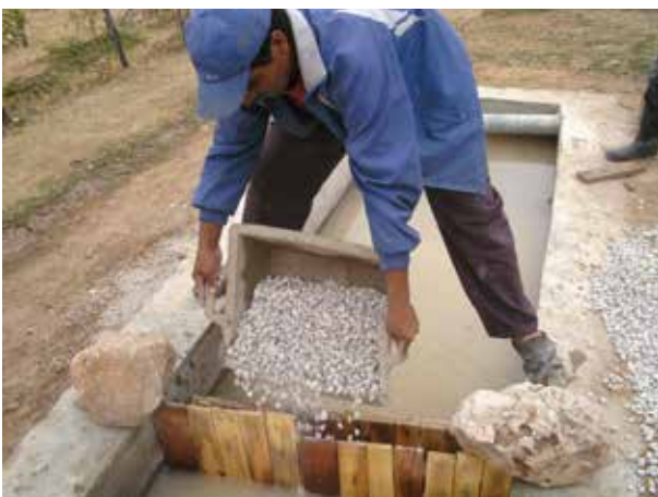
Image 226 : Une bande de 20 cm est remplie de gravier concassé aussi à la zone de drainage autour de la sortie.
