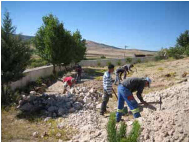
Image 534 : Travaux d'excavation pour la fondation du bassin du filtre végétalisé.
