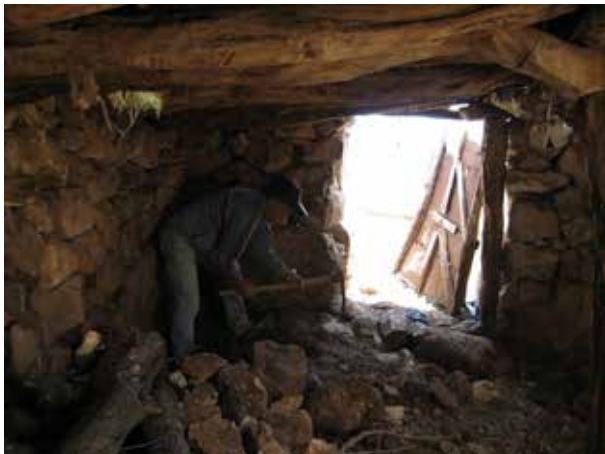
Image 96 : Excavation dans l'étable pour l'emplacement du réservoir d'urine.
