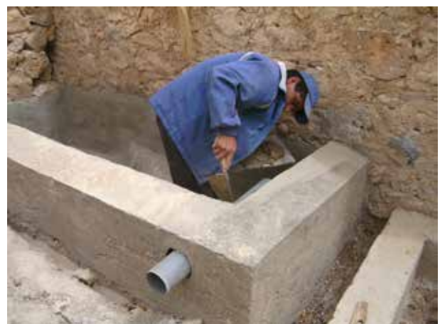
Image 367 : Du mortier est appliqué autour du tube.
