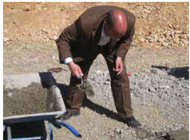
Image 658 : Les participants de l'atelier gagnent de l'expérience pratique sur les chantiers (digesteur).
