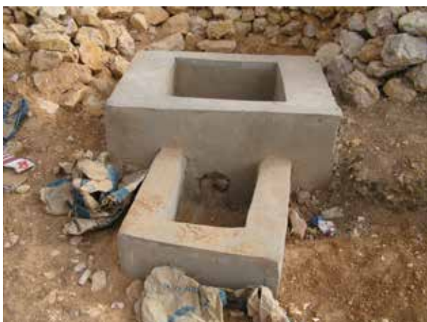
Image 439 : Du lait de ciment est posé comme finition.
