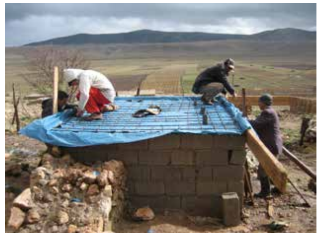
Image 37 : Une bâche en plastique est utilisée pour étancher le coffrage.
