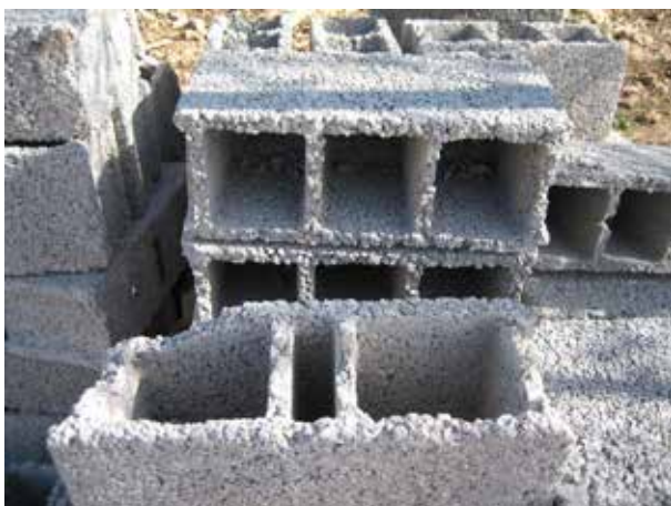
Image 701 : Mauvaise qualité des briques (béton trop faible).
