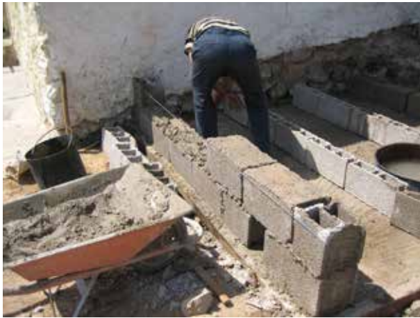
Image 135 : Construction des murs des fosses attachés à la maison.
