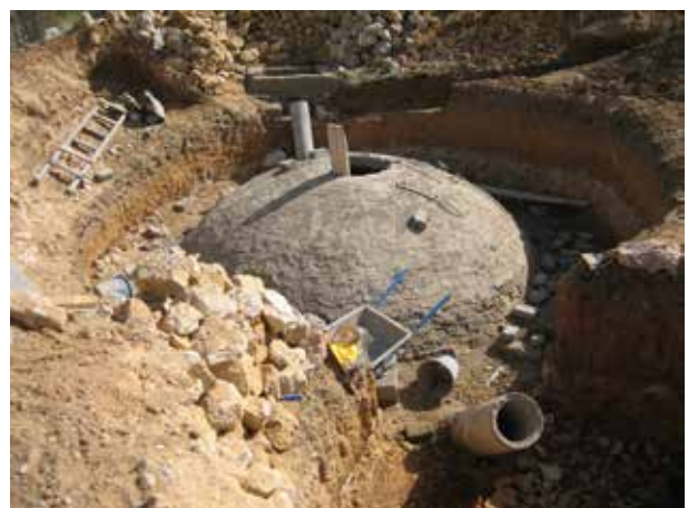
Image 434 : Vue du digesteur et de la tranchée pour la conduite.
