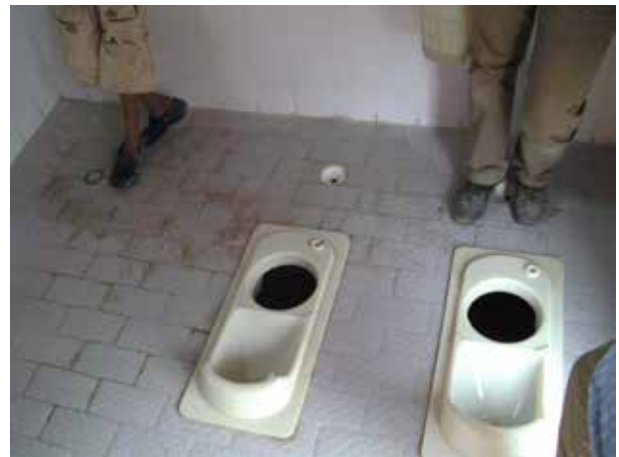
Image 105 : Les deux sièges de toilette sont installés.
