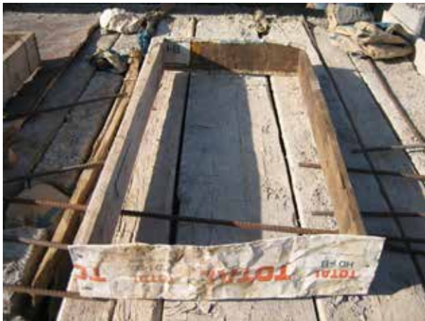
Image 246 : Ce cadre servira comme forme pour l'un des deux sièges de toilette.
