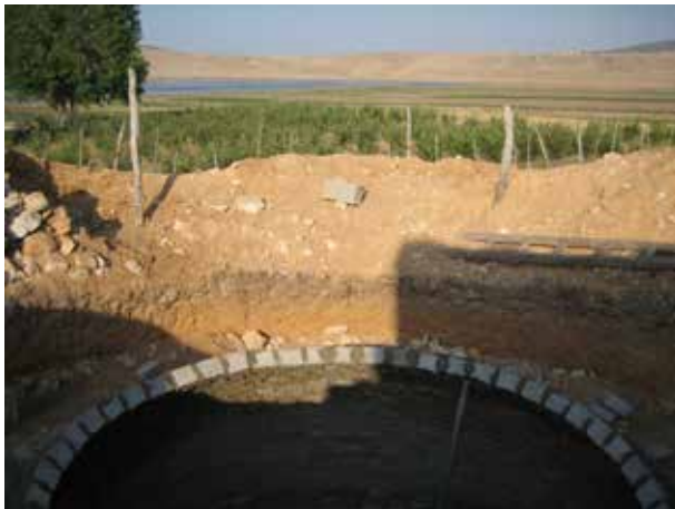
Image 414 : Vue du dôme en construction.
