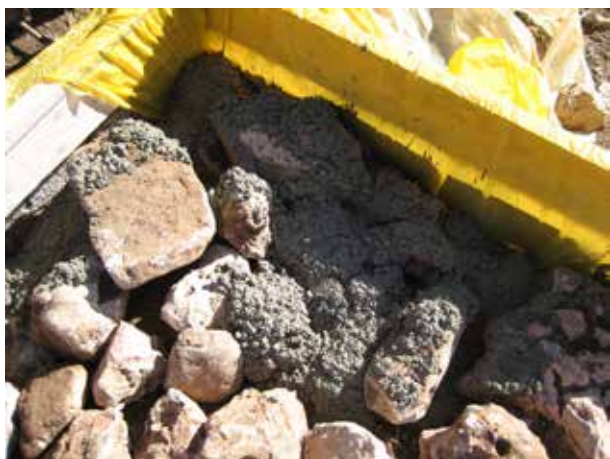
Image 20 : Le béton est coulé entre les pierres.
