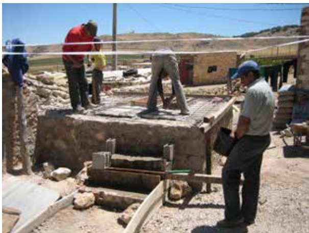
Image 305 : Construction de l'escalier et préparation du ferrailage.
