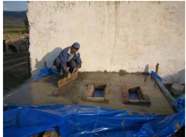
Image 152 : Le béton est lissé et compacté à l'aide d'une planche.
