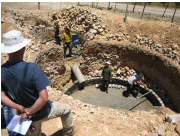
Image 404 : Le chantier pendant la construction de la cuve centrale.
