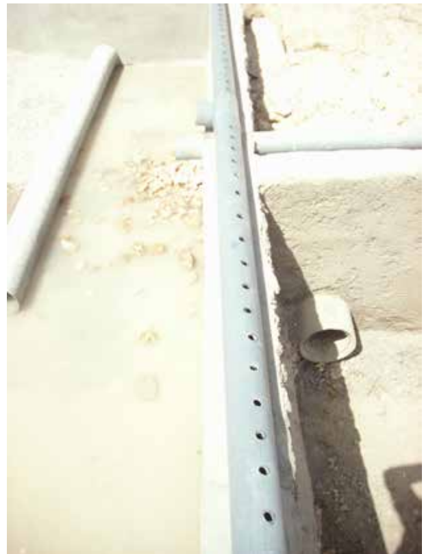
Image 573 : Tuyau d'alimentation avant son placement.
