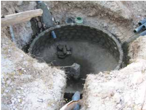
Image 507 : Vue du dôme du digesteur en construction.
