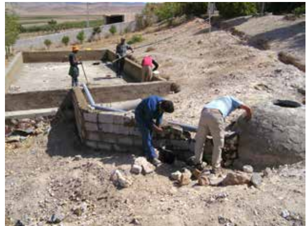
Image 563 : Pose d'un enduit d'étanchéité sur les parois internes et sommets des murets. Construction de la protection de la conduite du digesteur au filtre.
