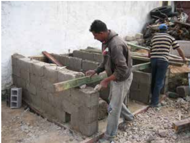
Image 139 : Préparation du support pour le coffrage. On voit les niches pour la tuyauterie et le linteau.
