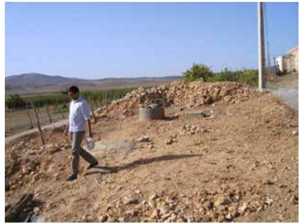
Image 480 : Les couvercles du bassin d'expansion et du regard de la conduite de gaz sont posés.
