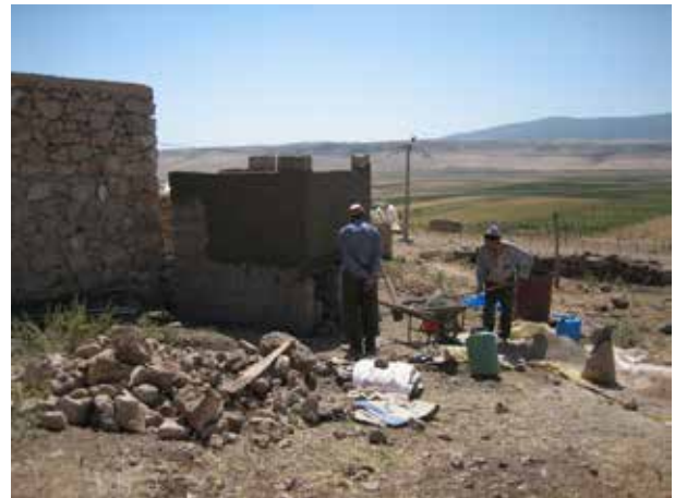
Image 263 : En attendant une autre charge de briques la première couche d'enduits est déjà appliquée.
