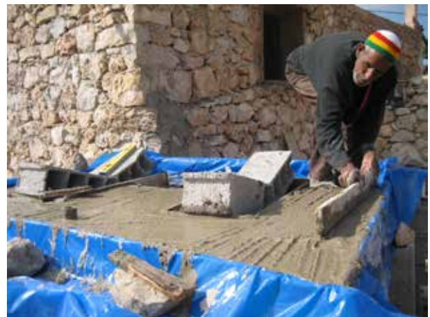
Image 255 : Utilisation d'une planche pour lisser et compacter le béton.
