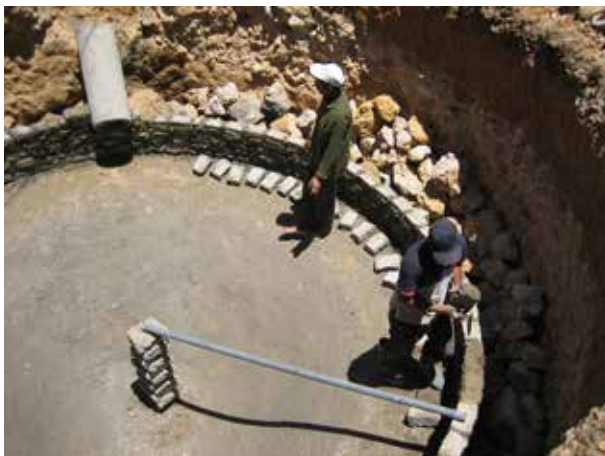
Image 400 : Avant la pose de la brique du mortier est appliqué sur son côté épaisseur x largeur pour bien remplir les joints.
