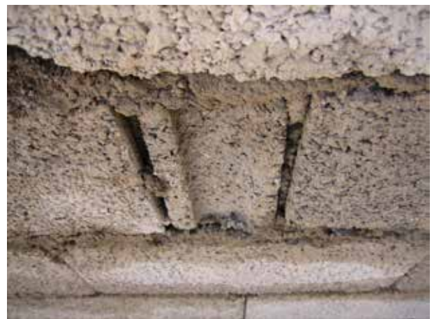
Image 239 : Intégration du mur intérieur dans le mur extérieur.
