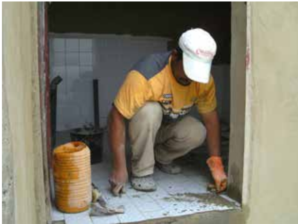
Image 191 : Pose du carrelage.
