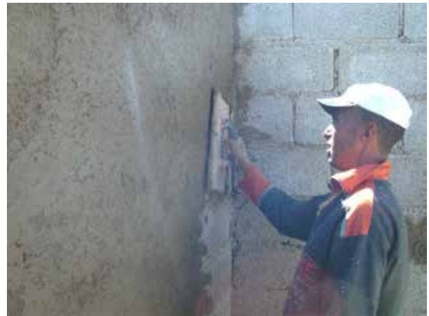
Image 55 : Application de la 1 ère couche d'enduits aux parois intérieures de la toilette.
