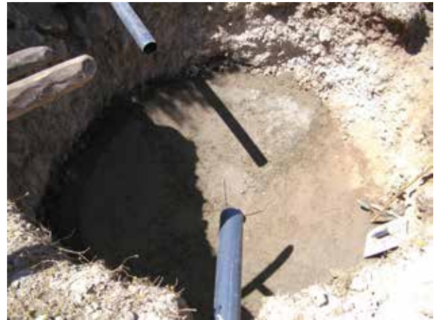
Image 502 : Dalle de fond (radier) du digesteur.
