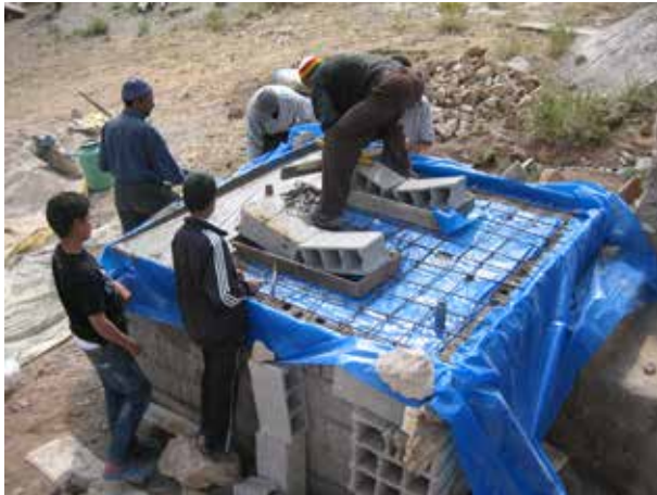
Image 252 : Coulée de la dalle.
