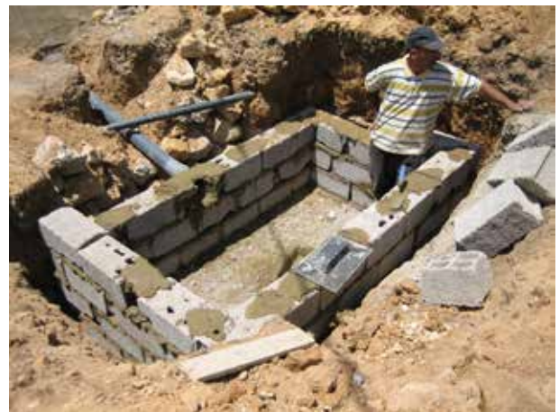
Image 463 : La fosse de stockage en construction.
