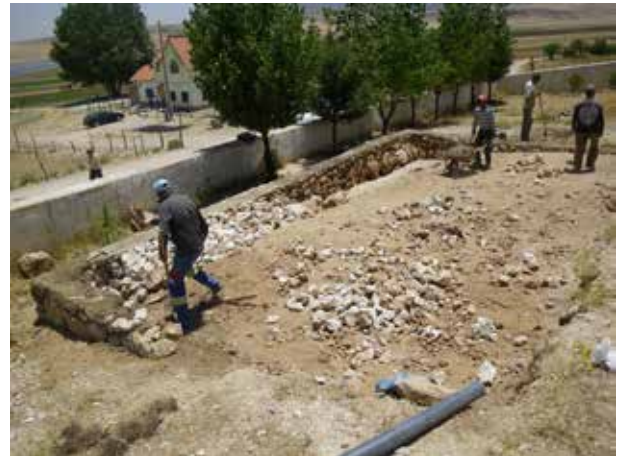
Image 539 : Terrassement du site.
