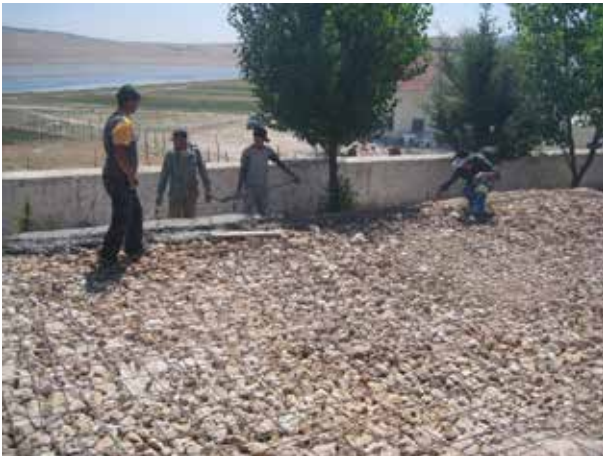
Image 548 : Pose de béton au bord du filtre.
