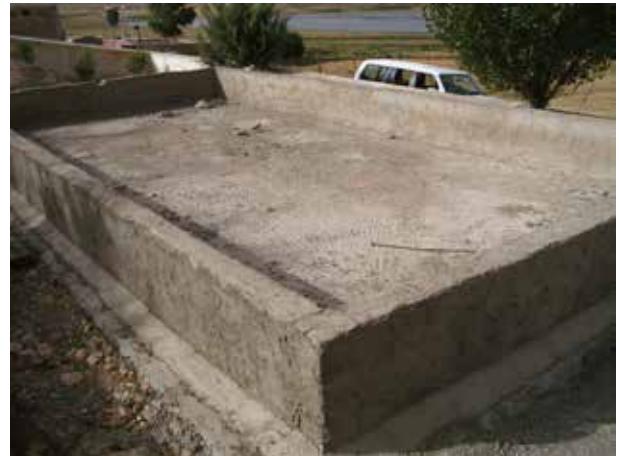
Image 561 : Une première couche d'enduits a été appliquée sur les parois internes et externes du bassin (juillet 2010).
