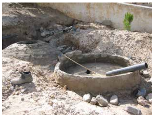
Image 514 : Le bassin d'expansion est construit comme le digesteur à l'aide d'un clou au centre et une baguette de mesure.
