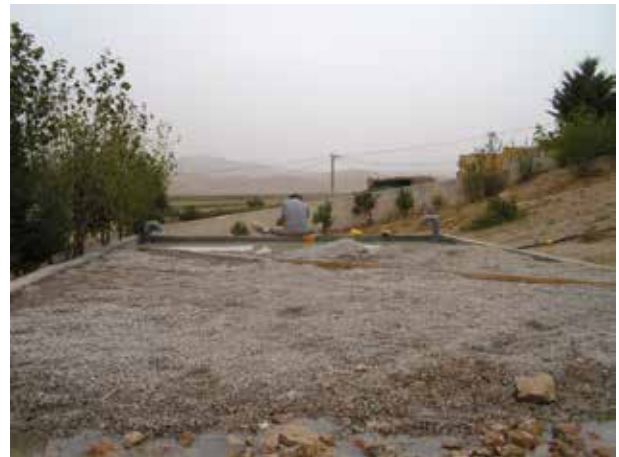
Image 577 : Le drain est muni de reniflards.
