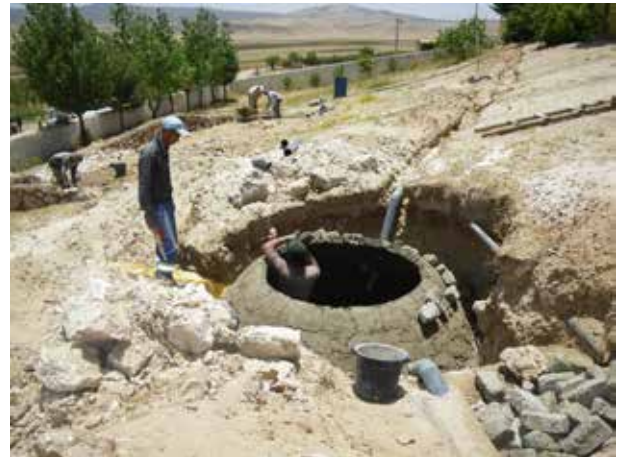
Image 508 : Construction du dôme du digesteur.
