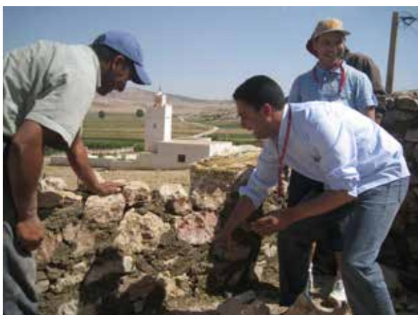
Image 641 : Les participants de l'atelier gagnent de l'expérience pratique sur les chantiers (TDSU Khaled).
