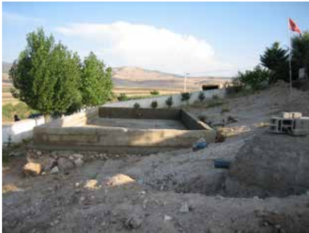
Image 560 : Le bassin est construit.
