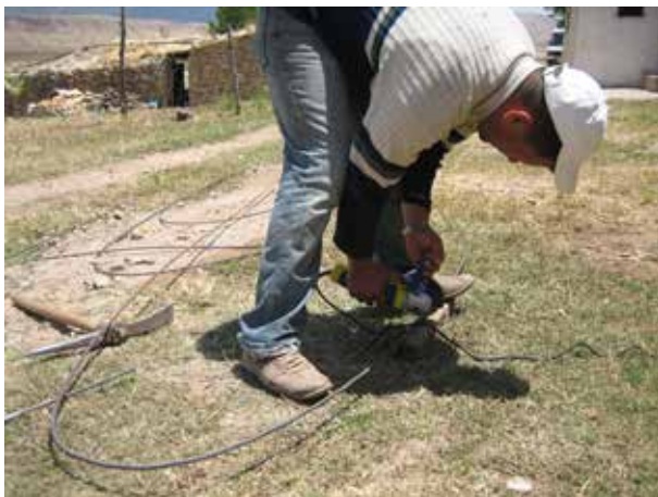
Image 141 : Les fers ronds sont coupés à l'aide de la meuleuse.
