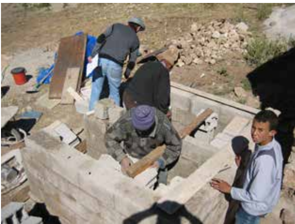
Image 242 : Installation du support pour la dalle.
