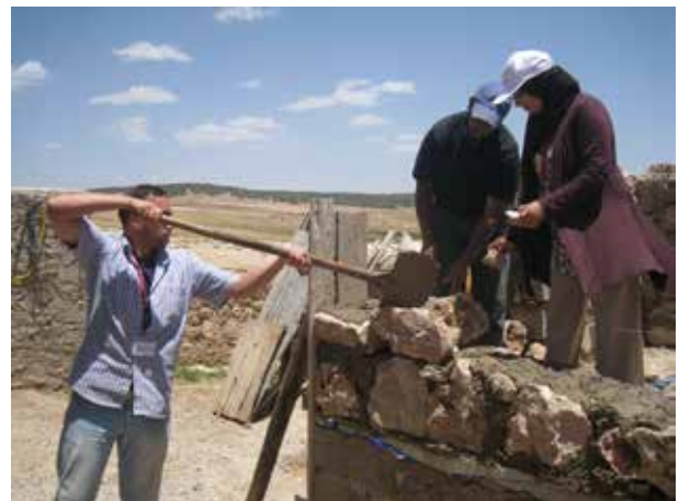
Image 646 : Les participants de l'atelier gagnent de l'expérience pratique sur les chantiers (TDSU Khaled).
