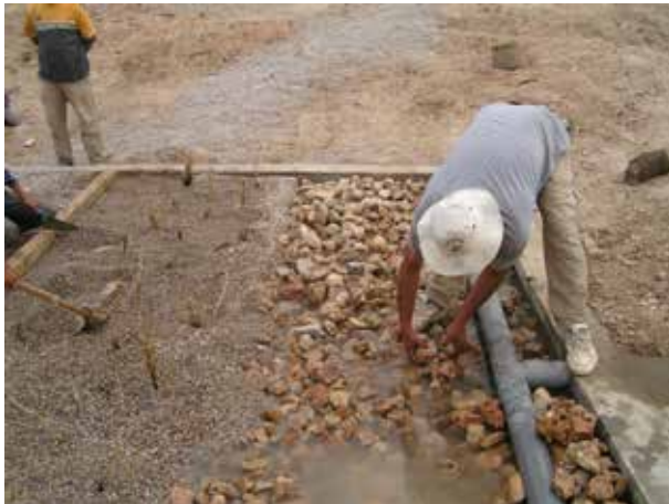
Image 580 : Placement des galets à l'entrée du filtre.
