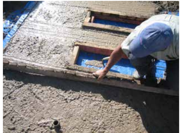
Image 310 : Le béton est lissé et compacté à l'aide d'une planche.
