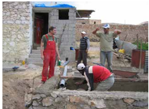
Image 211 : Application des enduits à l'intérieur du filtre.
