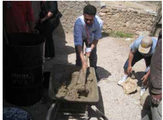
Image 638 : Les participants de l'atelier gagnent de l'expérience pratique sur les chantiers (TDSU Khaled).
