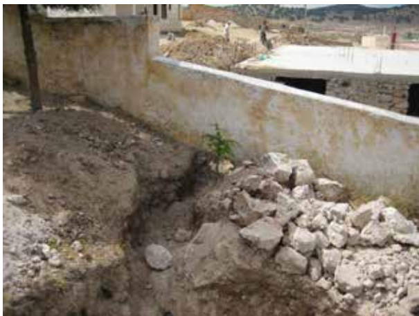
Image 485 : La conduite passe au-dessous du mur de la cour de l'école.
