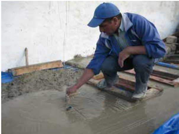
Image 151 : Une pente est formée autour du conduit d'écoulement de la douche.
