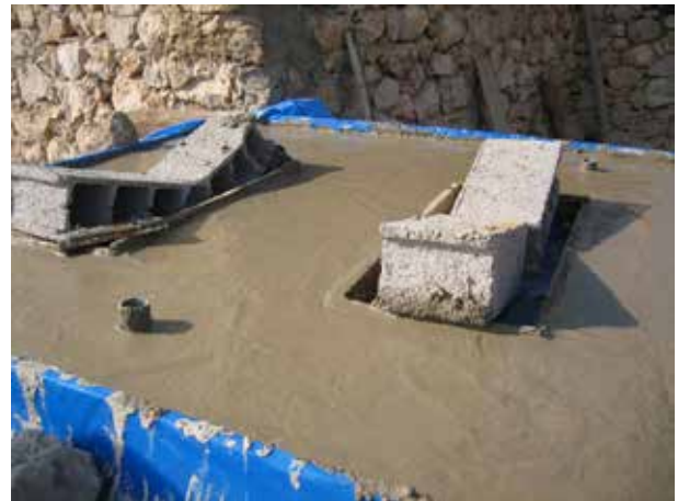
Image 259 : La dalle est finalisée.
