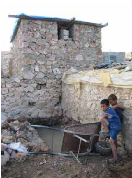
Image 360 : Vue de la TDSU et de la dalle du filtre planté.
