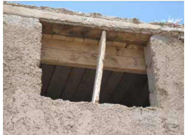
Image 65 : Support du linteau de la fenêtre.
