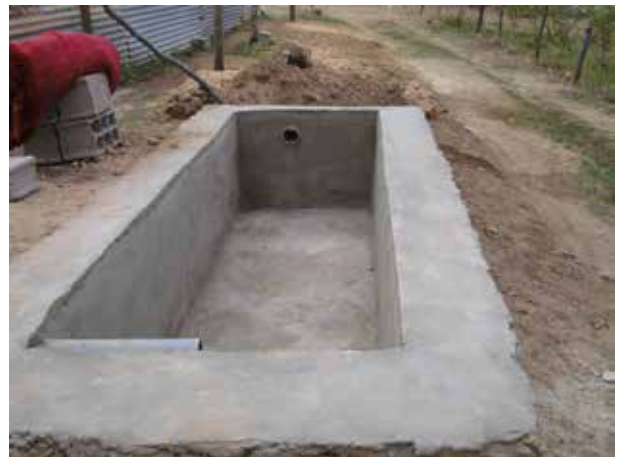
Image 221 : Le bassin du filtre planté est finalisé.
