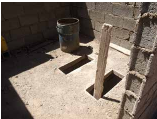
Image 48 : Dalle avec trous pour toilettes.
