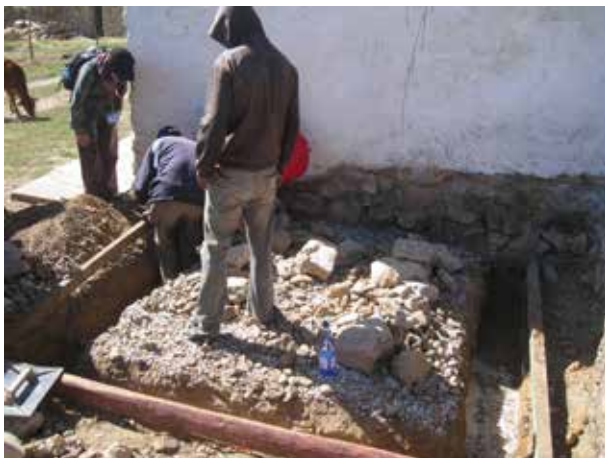
Image 130 : Préparation d'un coffrage horizontal.
