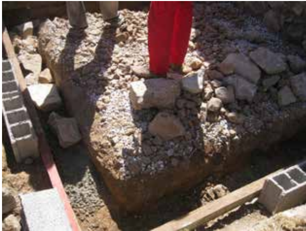
Image 132 : Des pierres sont utilisées dans la fondation.
