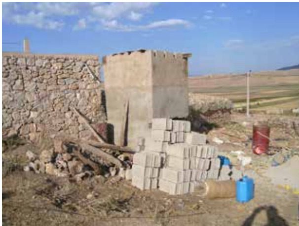
Image 268 : Les enduits extérieurs sont appliqués.
