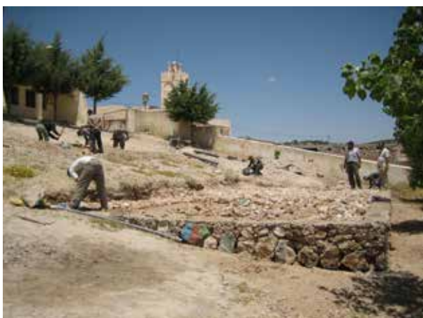
Image 542 : Finalisation du terrassement par une couche de pierres concassées.
