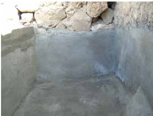
Image 364 : Enduisage à l'intérieur du bassin.
