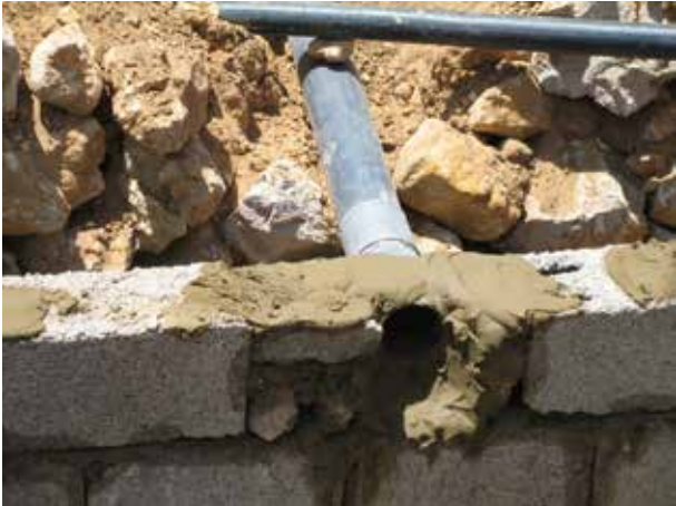
Image 464 : Le branchement du tuyau d'entrée est fait avec du mortier étanche.
