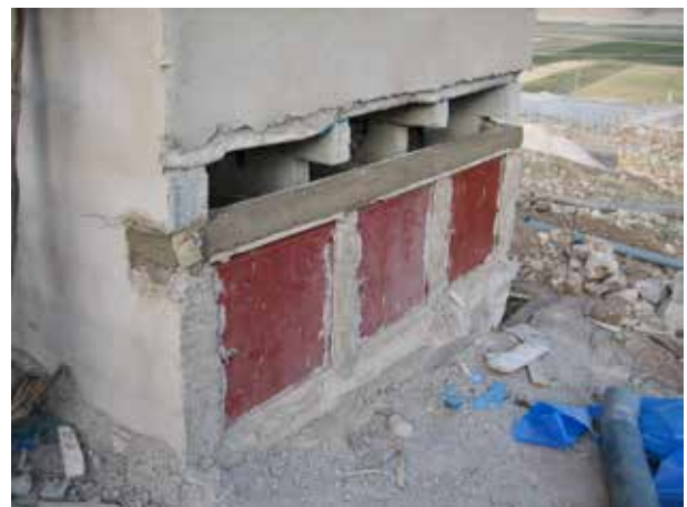
Image 77 : Le linteau au-dessus des portes des fosses est fait. Il manque encore une rangée de briques.
