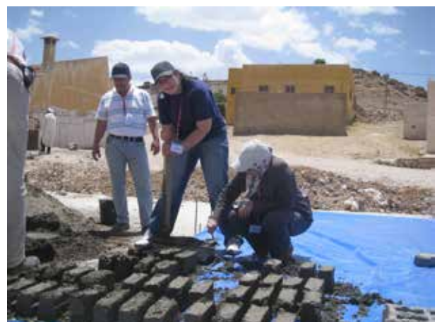
Image 660 : Les participants de l'atelier gagnent de l'expérience pratique sur les chantiers (filtre planté).
