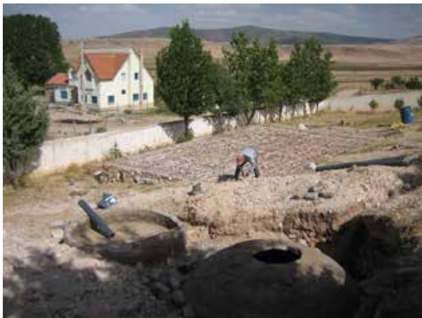
Image 546 : Vue du chantier avant de bétonner la dalle.
