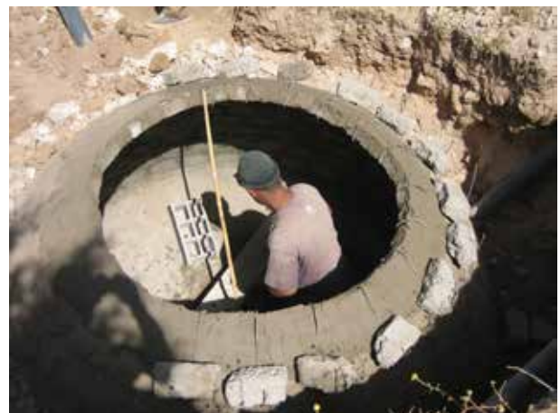
Image 510 : La baguette de mesure maintient la brique lors de sa pose.
