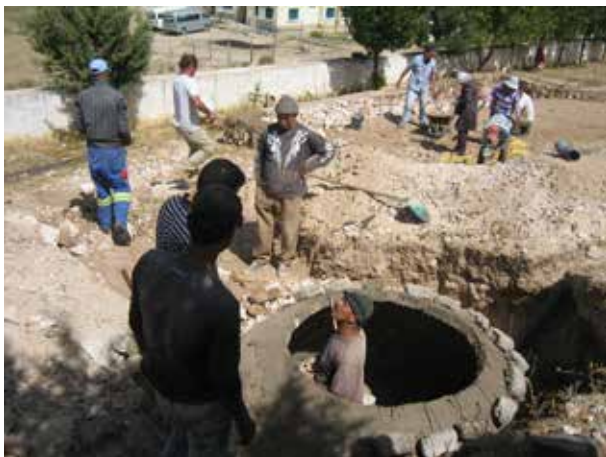
Image 540 : Vue du chantier pendant le terrassement du site du filtre planté.
