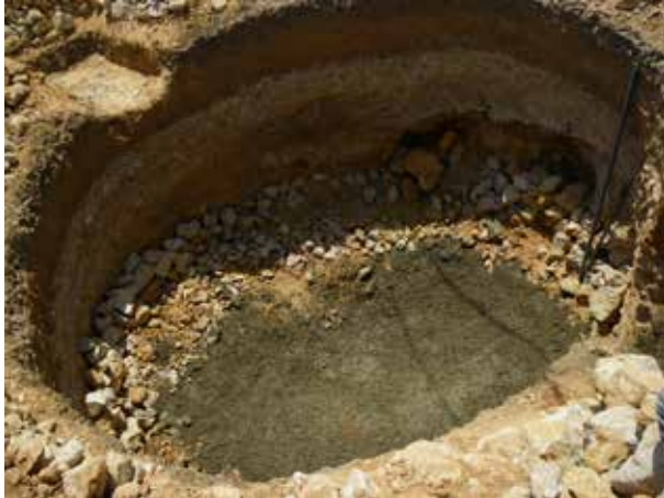
Image 388 : Bétonnage du fond (radier) de la cuve.
