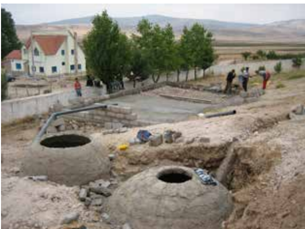
Image 552 : Le chantier pendant la pose de la dalle du filtre planté.
