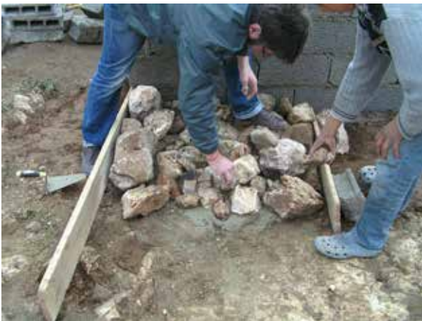
Image 28 : Construction de l'escalier avec des pierres naturelles et du béton. Deux planches forment le coffrage pour la première marche.
