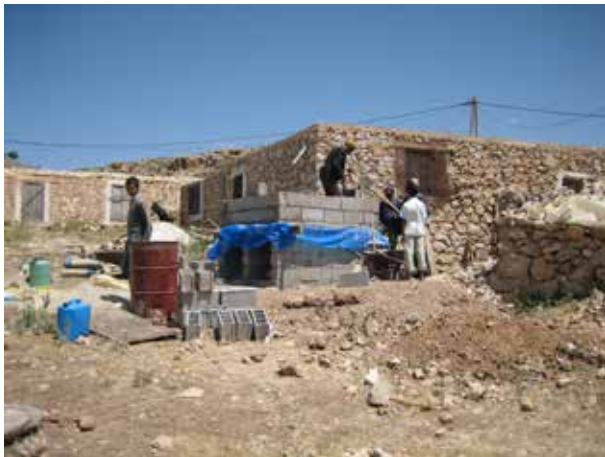
Image 262 : Aperçu du chantier pendant la maçonnerie.
