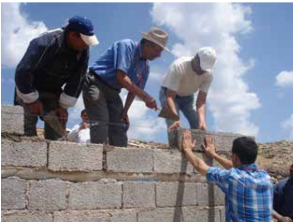
Image 623 : Les participants de l'atelier gagnent de l'expérience pratique sur les chantiers (TDSU Ferhaoui).
