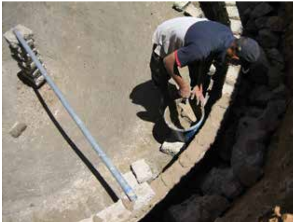
Image 398 : Une couche de mortier est posée.
