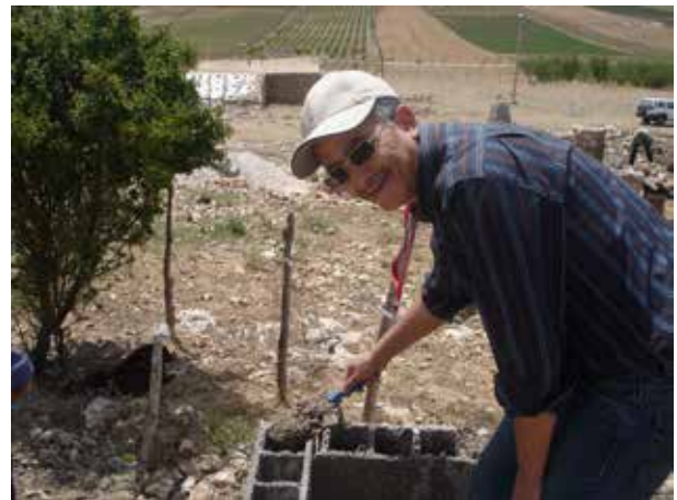
Image 624 : Les participants de l'atelier gagnent de l'expérience pratique sur les chantiers (TDSU Ferhaoui).
