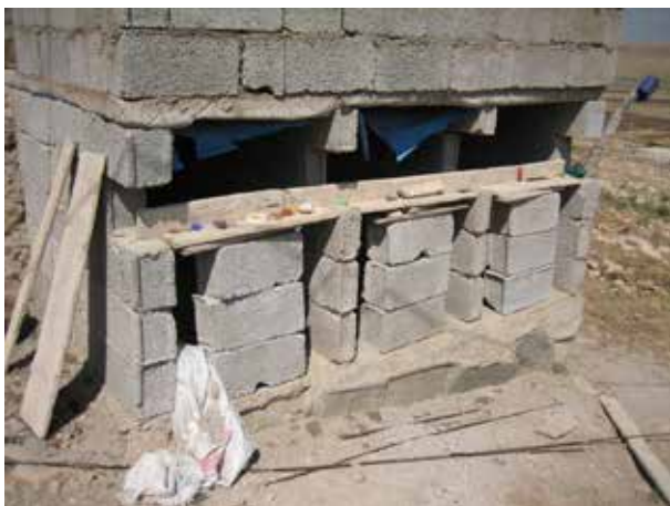
Image 76 : Préparation d'un coffrage pour le linteau au-dessus des portes des fosses.
