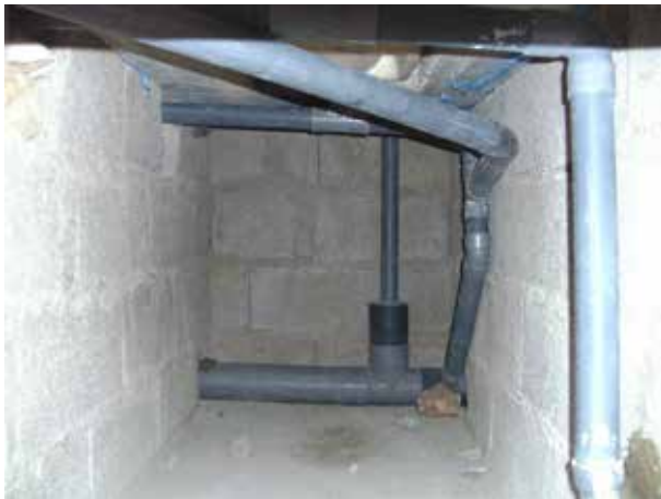
Image 284 : Vue intérieure des trois systèmes de conduites (eaux de lavage anal à droite, eaux grises en bas (110 mm) avec pièce T, et urine).
