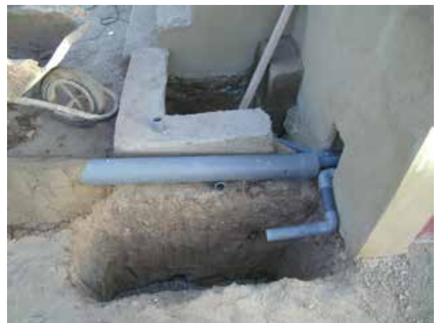
Image 186 : Trois tuyaux sortent de la TDSU. Les eaux grises sont conduites vers le filtre planté dans un tuyau de 110 mm. Un couvercle va être placé sur le petit mur autour du réservoir d'urine.
