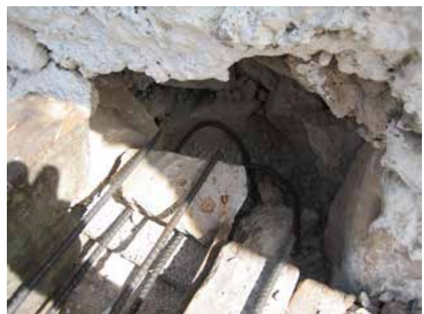
Image 159 : Aussi pour le toit le ferrailage doit être bien ancré dans le mur de la maison.
