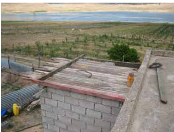
Image 158 : Coffrage du toit finalisé.
