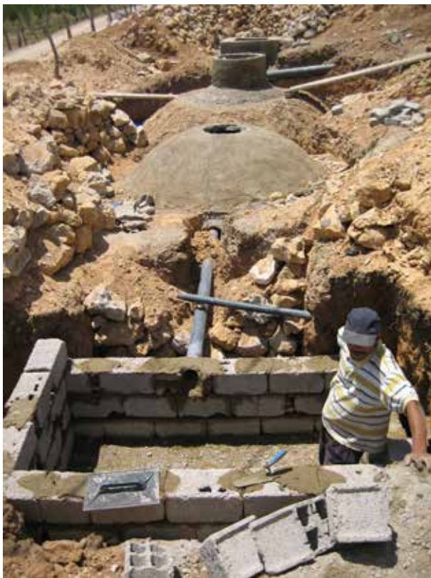
Image 462 : Le tuyau d'entrée est branché.
