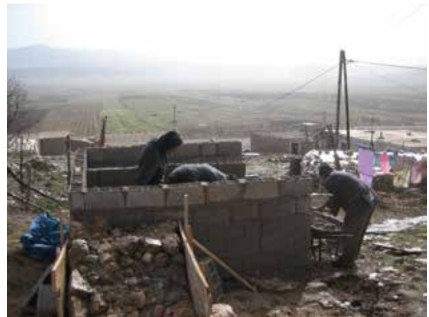
Image 29 : On voit qu'il est important de mouiller les briques – sinon l'eau dans le mortier est absorbée par les briques comme visible dans la dernière rangée de briques.
