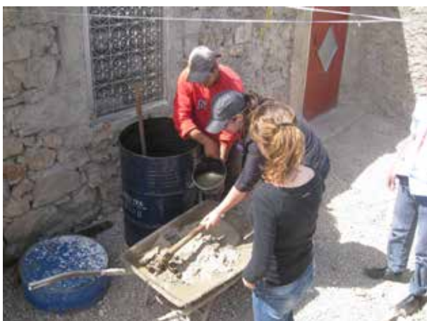
Image 635 : Les participants de l'atelier gagnent de l'expérience pratique sur les chantiers (TDSU Khaled).
