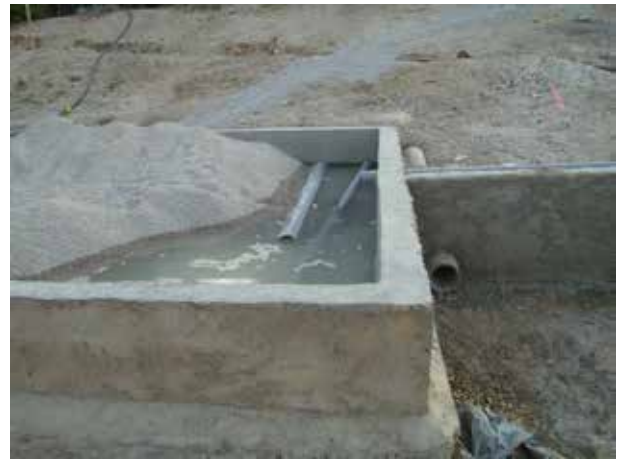
Image 571 : Placement des graviers.
