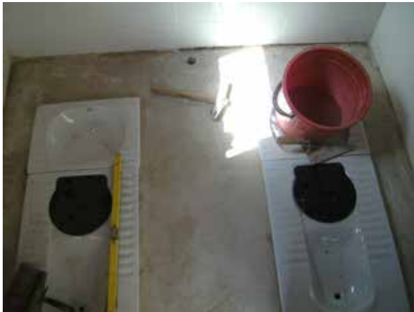
Image 276 : L'intérieur de la TDSU avant pose du carrelage sur le fonds. Les deux sièges indiens sont placés.
