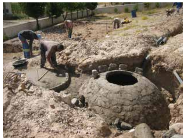
Image 512 : Le radier du fond du bassin d'expansion est posé.
