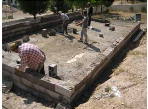
Image 555 : Les parois sont montées à l'aide de blocs en béton remplis de mortier.
