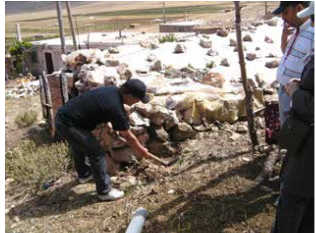
Image 95 : Le tuyau va entrer dans le mur de l'étable.
