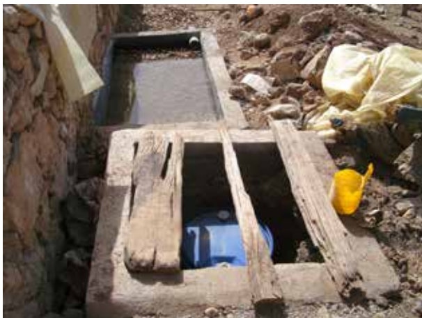
Image 293 : Vue du réservoir d'urine et du filtre pendant la mise en place du matériau de filtration.
