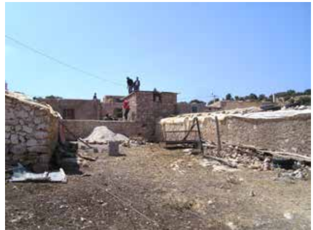
Image 328 : Préparation du coffrage pour la toiture.
