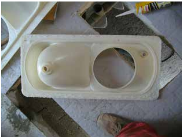
Image 104 : Fixation des sièges de toilette à séparation d'urine avec de la silicone.
