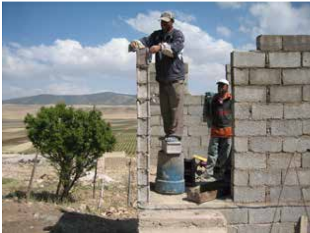
Image 52 : Utilisation d'un fil à plomb pour assurer la verticale.
