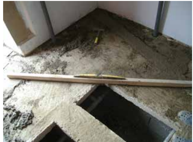
Image 341 : Préparation de l'horizontale avant la pose du carrelage.
