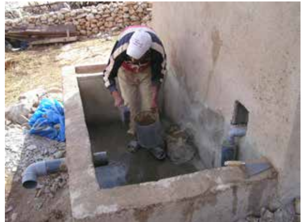
Image 122 : Finition avec du lait de ciment 1 jour après appliquer la couche d'enduits.
