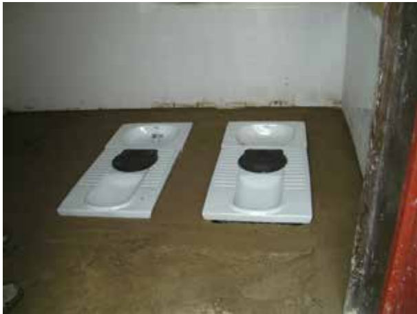
Image 342 : Les deux sièges de toilette sont placés avant la pose du carrelage.
