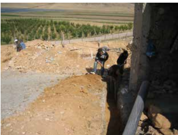
Image 433 : La conduite des eaux usées est posée sur une couche de sable.
