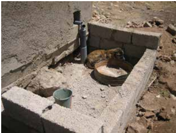
Image 115 : Murs du filtre planté en train de construction.
