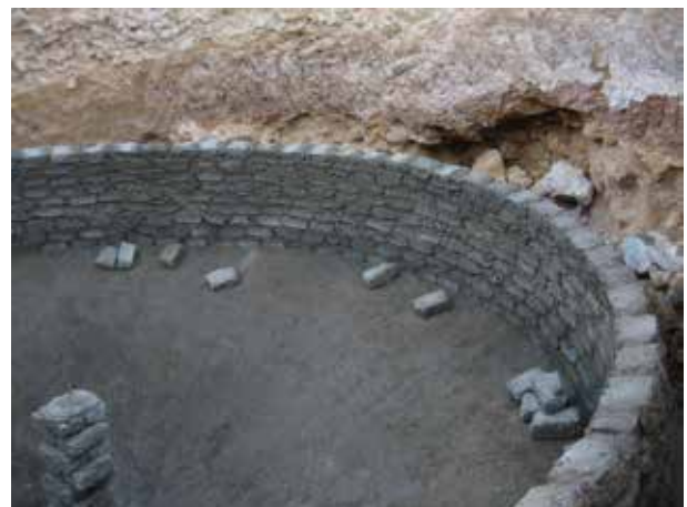
Image 407 : Le dessus des briques est toujours parallèle à la baguette de mesure, ce qui forme le dôme hémisphérique.
