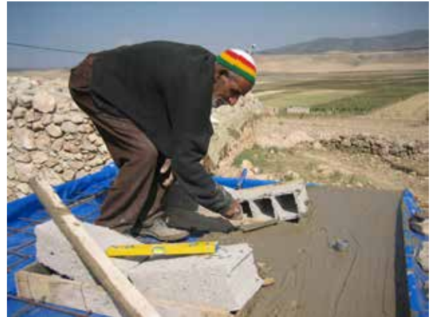
Image 253 : Distribution du béton avec la truelle.
