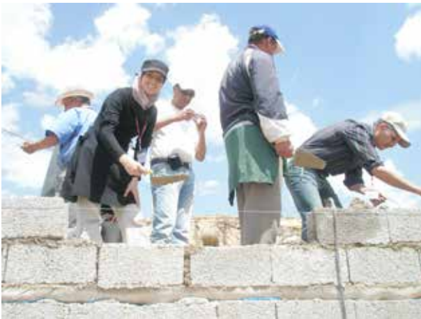
Image 627 : Les participants de l'atelier gagnent de l'expérience pratique sur les chantiers (TDSU Ferhaoui).
