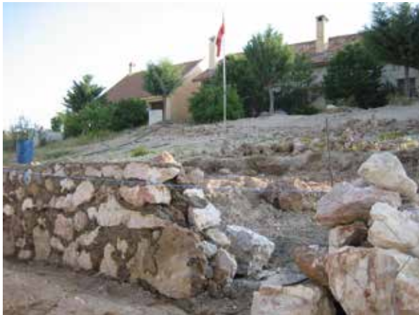
Image 538 : Construction du mur de soutènement en pierres naturelles.
