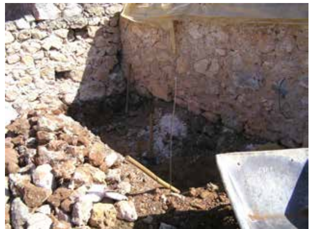
Image 355 : Excavation pour le filtre. Un grand rocher ne peut pas être enlevé.
