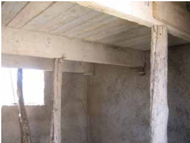
Image 60 : Le support du toit est prêt.
