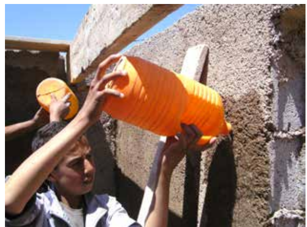
Image 57 : Arrosage des enduits pour prévenir des fissures.
