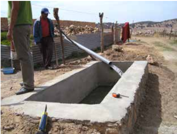
Image 222 : Après séchage complet le bassin est rempli pour tester l'étanchéité.
