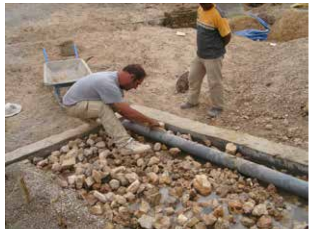
Image 579 : Ajustement du tuyau d'alimentation.
