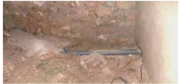
Image 283 : Vue finale de la conduite des eaux grises. Le pièce T sert à accéder le tube en cas d'un bouchon.
