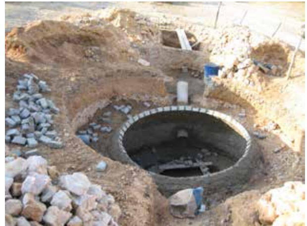
Image 413 : Enduisage et remblaiement de terre autour du dôme du digesteur.
