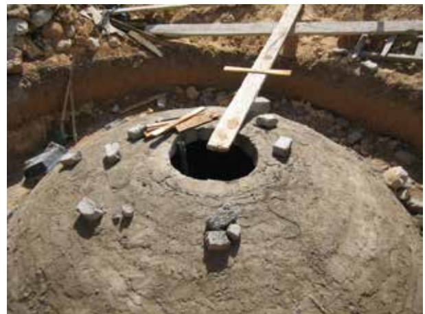
Image 421 : Le dôme du digesteur sans couronne.
