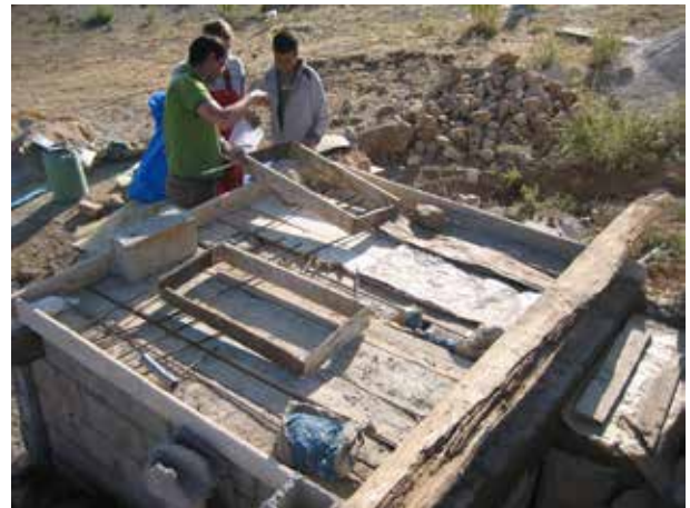
Image 247 : Préparation du ferrailage autour des deux cadres.
