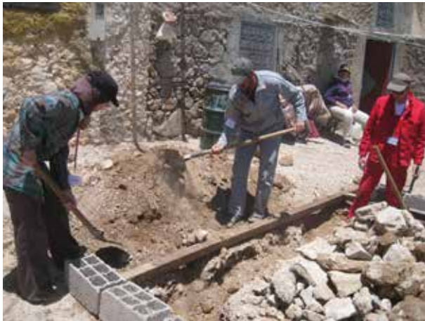
Image 295 : Travaux d'excavation pour la fondation.
