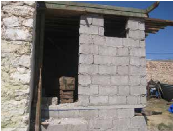
Image 160 : Vue du support et du coffrage pour le toit.
