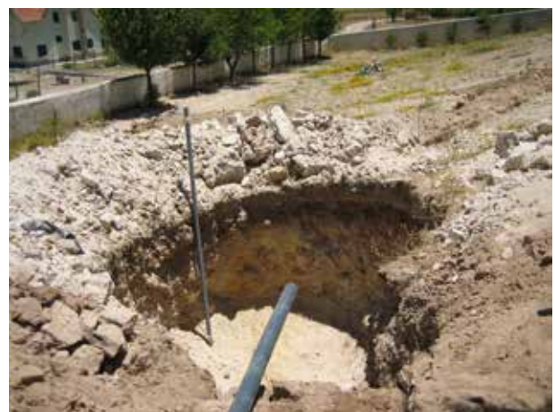
Image 494 : Arrivée du tuyau des eaux usées de la mosquée au site du prétraitement.
