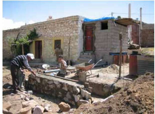
Image 207 : Aperçu du chantier pendant la construction des murs du filtre planté.
