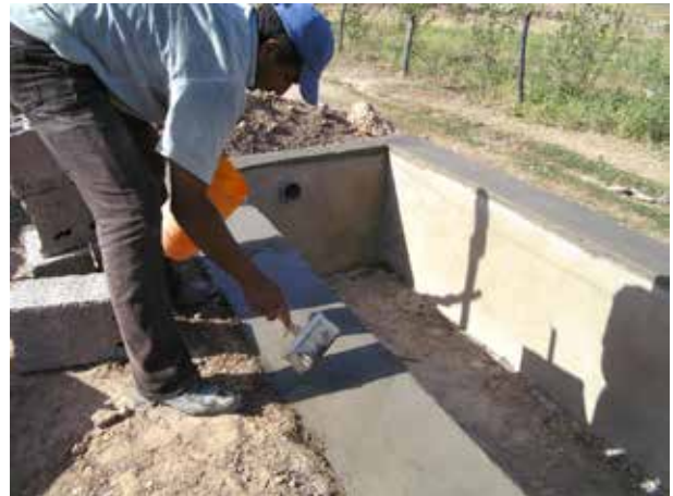
Image 219 : Application de lait de ciment pour lisser la superficie du bassin.
