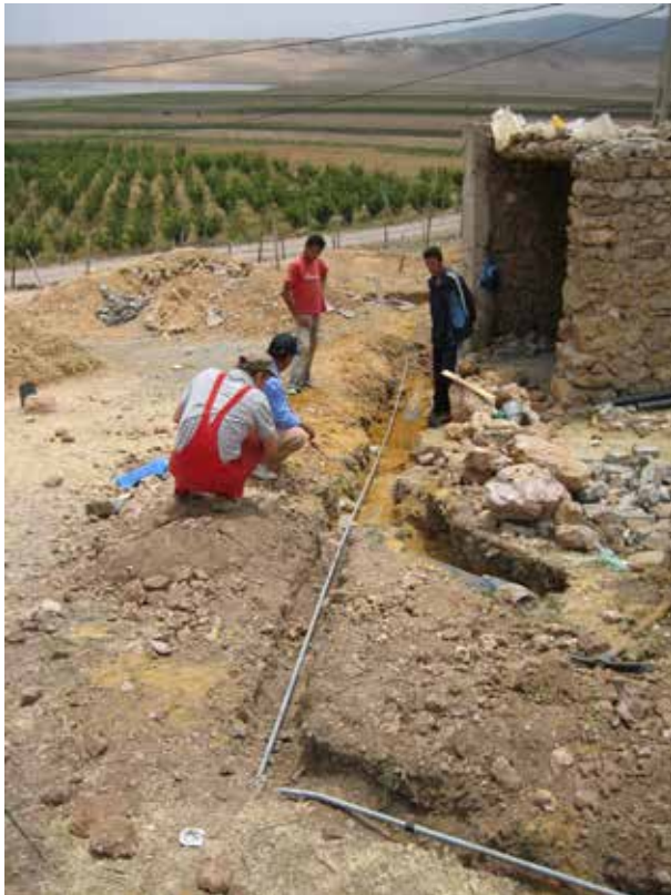
Image 440 : La tuyauterie galvanisée est placée dans la tranchée de la conduite des eaux usées.
