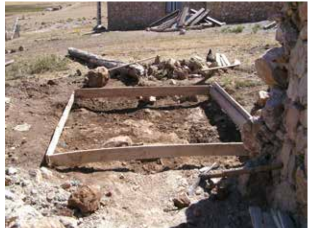
Image 233 : Coffrage pour la fondation, préparé avec les planches disponibles sur place.
