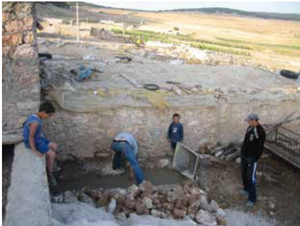
Image 362 : Vue de la dalle du filtre planté au-dessous du bâtiment de la TDSU.
