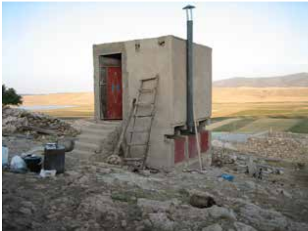
Image 74 : Placement provisoire du tuyau de ventilation. La porte est installée.
