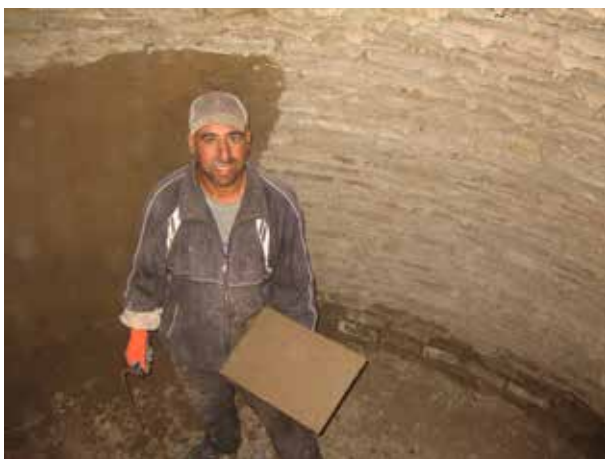
Image 425 : Pose de la première couche d'enduit.
