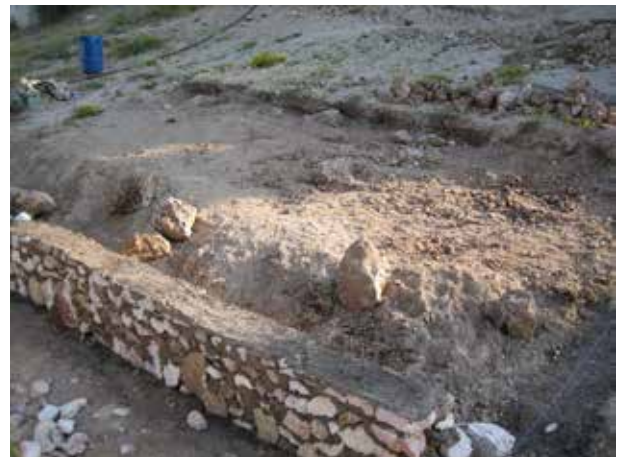
Image 537 : Mur de soutènement du filtre végétalisé.
