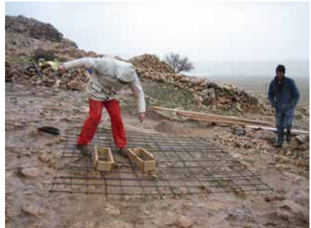
Image 35 : Préparation du ferrailage.
