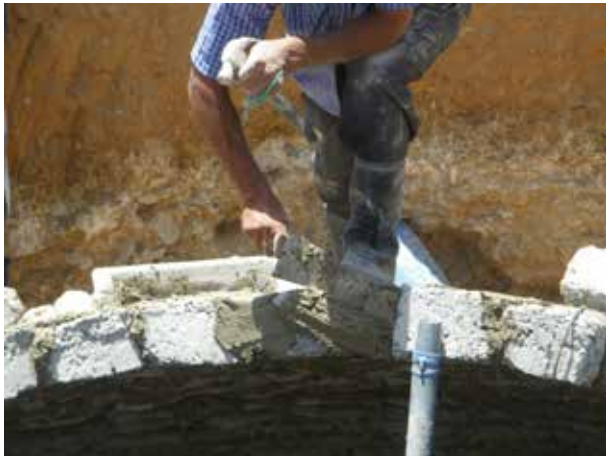
Image 418 : Pose des rangées supérieures de briques. La baguette de mesure maintient la brique lors de sa pose.
