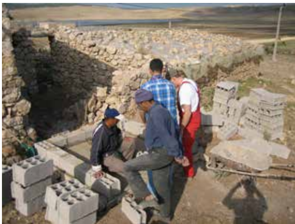
Image 236 : Construction des murs des fosses.
