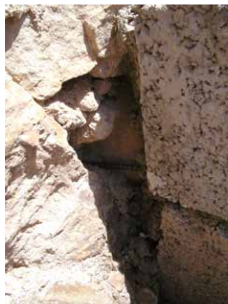
Image 361 : Le mur du filtre est fixé au mur existant à l'aide de fers ronds.
