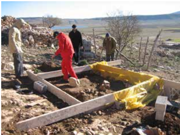
Image 16 : Coffrage étanché avec une bâche en plastique.
