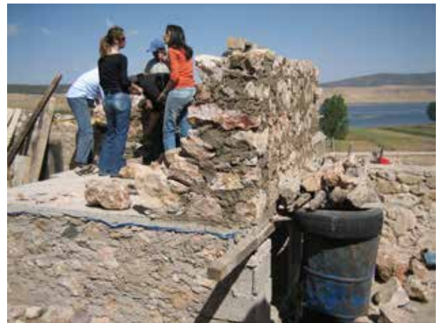
Image 318 : Les murs de la superstructure sont également faits en pierres naturelles.
