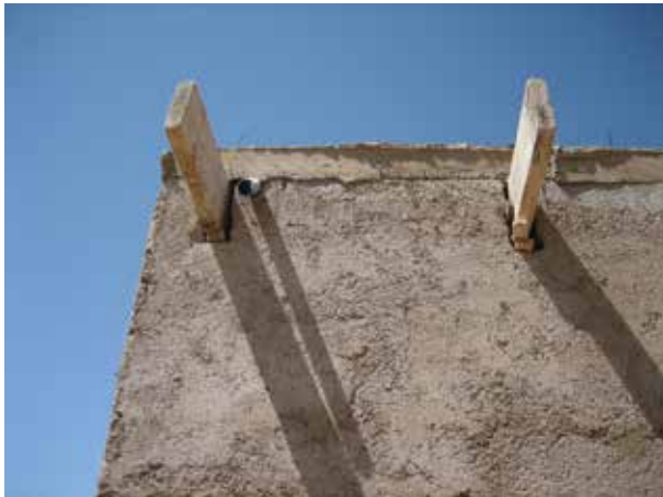
Image 64 : Le toit en béton armé après enlever le coffrage. Le support idéalement reste encore 2 semaines ou plus (dans ce cas moins à cause du temps limité pendant l'atelier). Un tuyau est installé pour l'évacuation des eaux de pluie.
