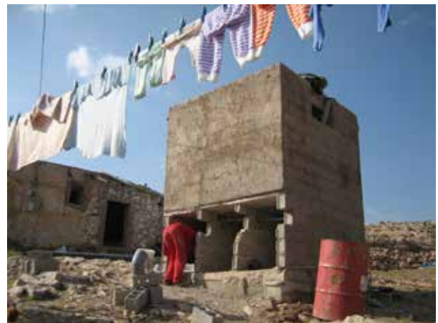
Image 63 : Installation parallèle du coffrage pour le toit et de la tuyauterie.
