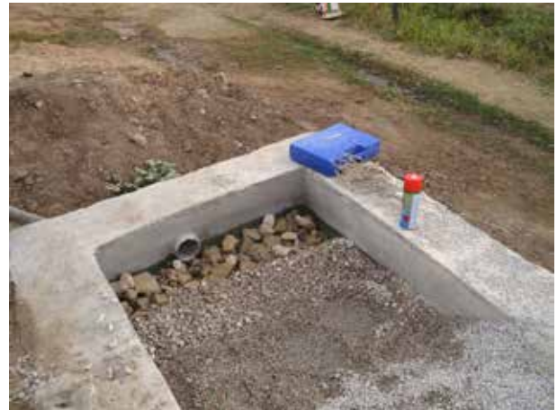
Image 229 : La zone de drainage avec ses 3 tailles du grain.
