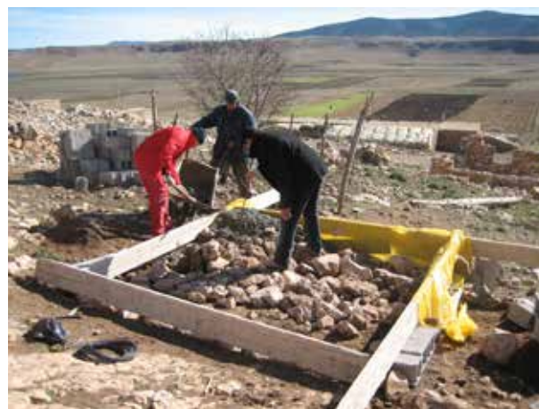
Image 21 : Les interstices entre les pierres sont colmatés à l'aide d'une barre de fer.
