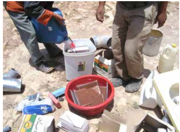
Image 101 : Mouillage du carrelage avant la pose.
