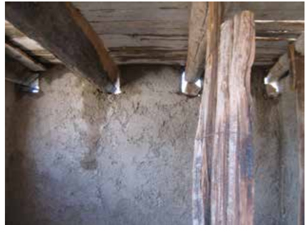
Image 273 : Le support pour le toit vu de l'intérieur de la toilette.
