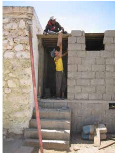
Image 157 : Préparation du support pour le toit en béton armé.
