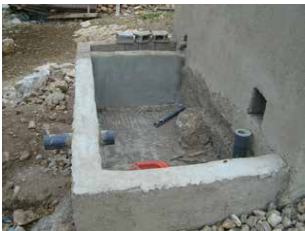
Image 117 : Les murs sont finis, une couche d'enduits est appliquée et le tuyau de sortie est intégré dans le mur.
