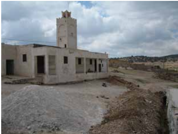
Image 483 : Travaux d'excavation pour la conduite des eaux usées de la mosquée vers le filtre planté.
