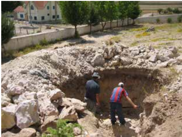
Image 501 : Excavation de la cuve du digesteur.
