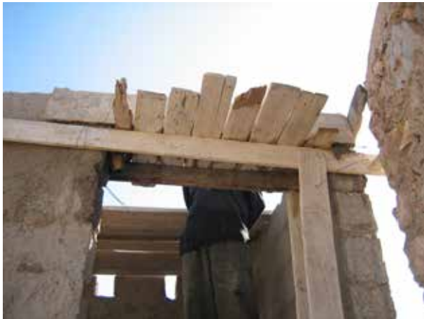
Image 266 : Coffrage du linteau pour la porte.
