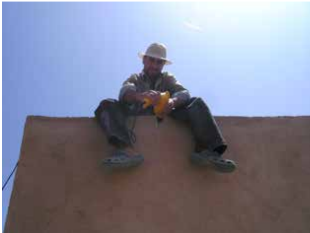
Image 90 : Préparation de la fixation du tuyau de ventilation.
