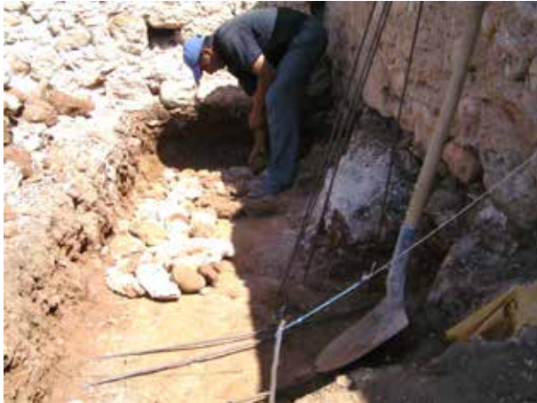
Image 356 : Une couche horizontale de moellons forme la base pour la fondation (dalle) du filtre planté.
