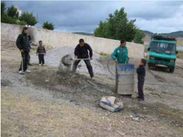
Image 383 : Préparation du béton pour la fabrication des blocs.
