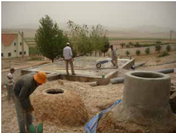
Image 576 : Distribution des graviers dans le bassin.
