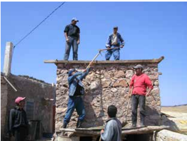
Image 329 : Application du béton.
