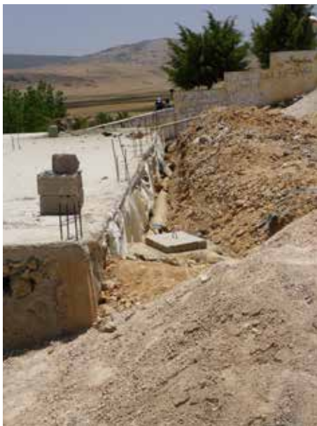
Image 491 : La chambre de visite est couverte d'une dalle amovible en béton armé.
