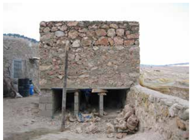
Image 324 : Vue latérale du gros œuvre.
