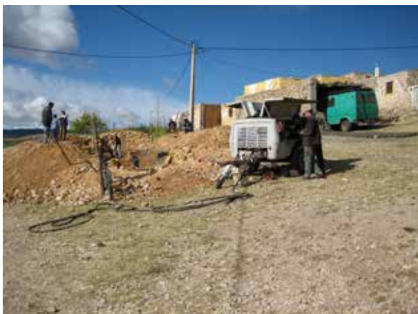
Image 377 : Aperçu du chantier et de la maison de la famille bénéficiaire.
