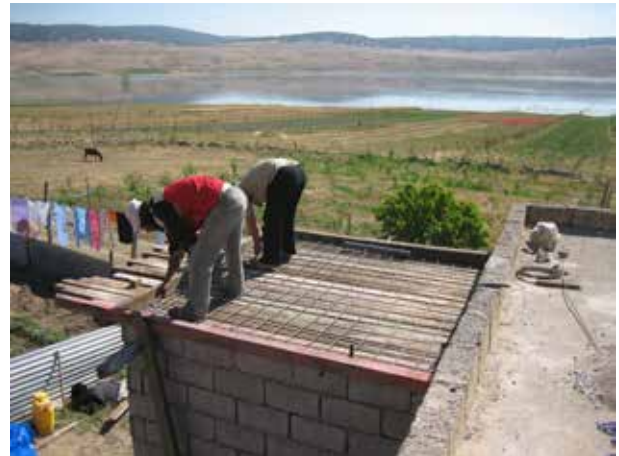
Image 161 : Préparation du ferrailage.
