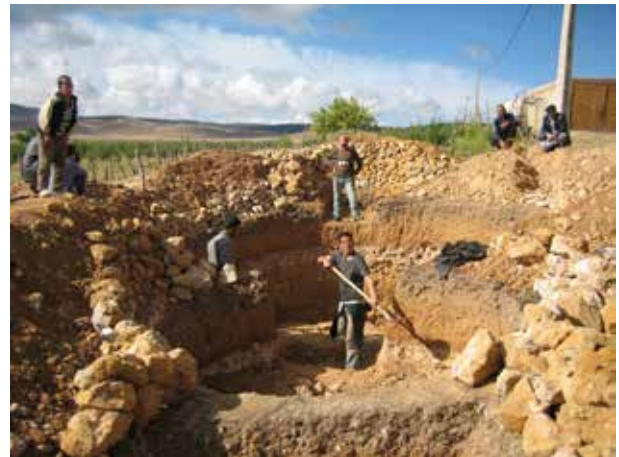
Image 376 : La petite excavation ronde est prévue pour le bassin d'expansion.
