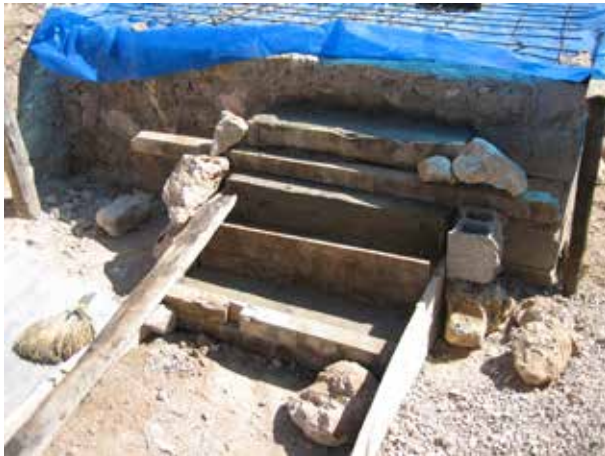
Image 315 : Coffrage pour bétonner l'escalier.
