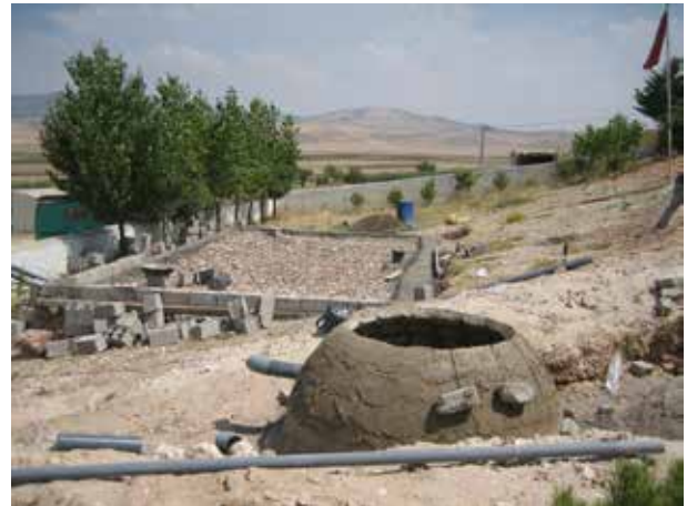
Image 549 : Pose de la première rangée de briques.
