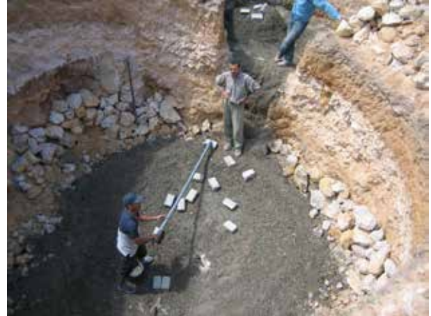
Image 389 : Définition du centre du dôme de la cuve.
