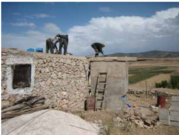
Image 274 : Coulée du toit en béton
