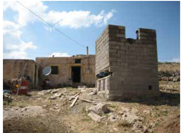
Image 53 : Niche pour la fenêtre dans les murs finalisés.
