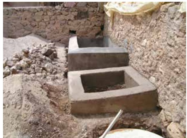
Image 365 : Le bassin du filtre planté et les murs autour du réservoir d'urine sont finalisés.
