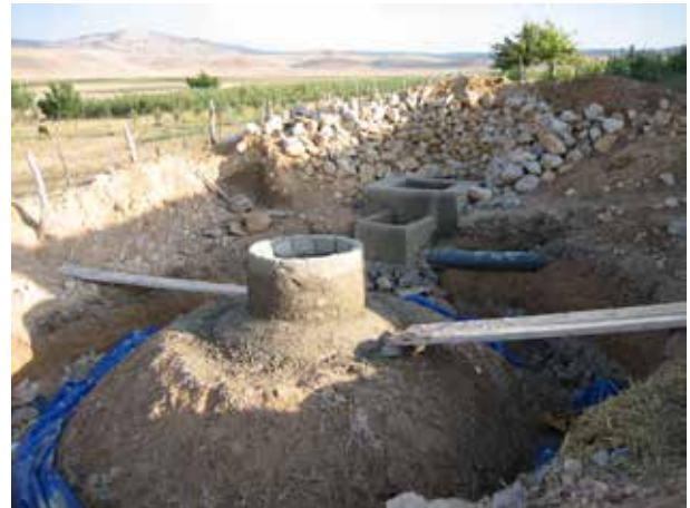
Image 457 : Vue du digesteur avec la couronne de couvercle.
