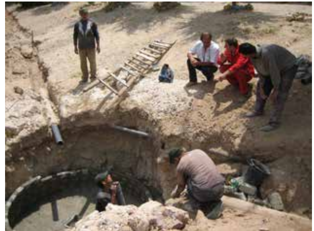
Image 504 : Construction des premières rangées de briques.
