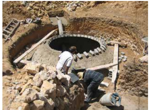
Image 415 : La buse et le radier du bac d'alimentation sont préparés.
