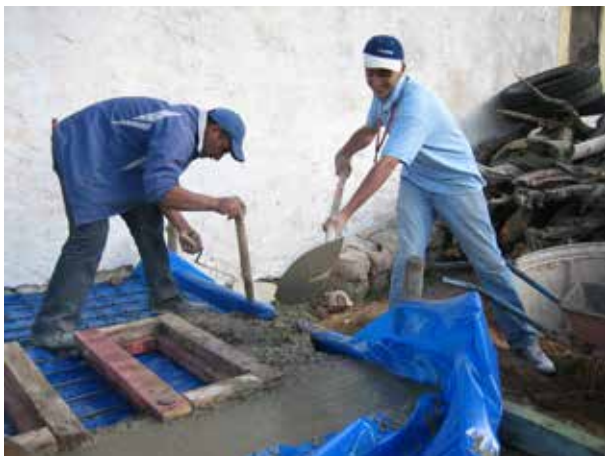
Image 149 : Utilisation d'un bâton pour colmater les interstices et pour pousser le béton dans les briques des murs au-dessous de la dalle.
