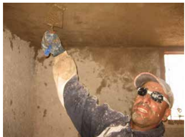
Image 73 : Application d'une 2 ème couche d'enduits au toit.
