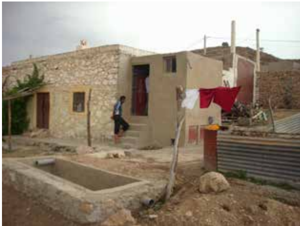
Image 218 : Vue du chantier avant reprise du travail en juillet 2010.
