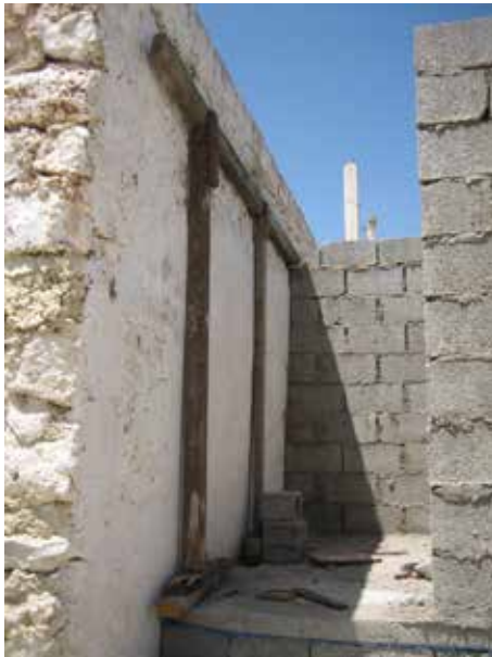
Image 156 : Des poutres vont porter le coffrage pour le toit.
