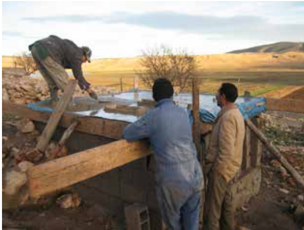
Image 44 : Finalisation de la dalle avec une truelle.
