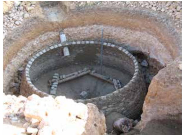
Image 409 : La buse d'alimentation est posée. Une couronne de mortier est faite sur le raccordement de la buse du bassin d'expansion au mur de briques.
