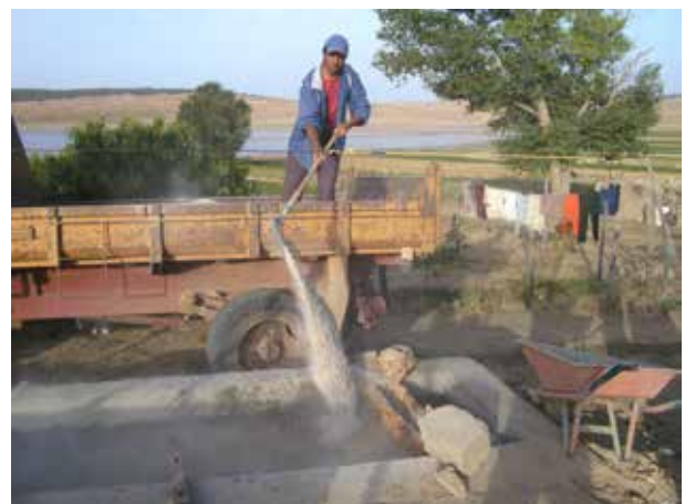
Image 227 : Du gravier fin est versé dans la partie principale du filtre.
