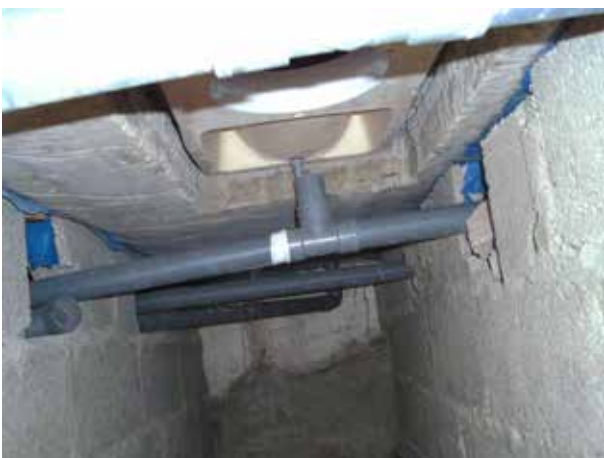
Image 179 : Vue de la tuyauterie dans la fosse au milieu (placement provisoire).
