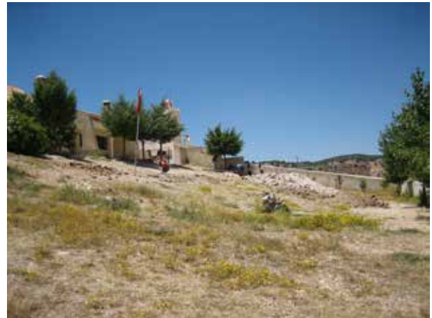
Image 496 : Vue du chantier pendant les travaux d'excavation.
