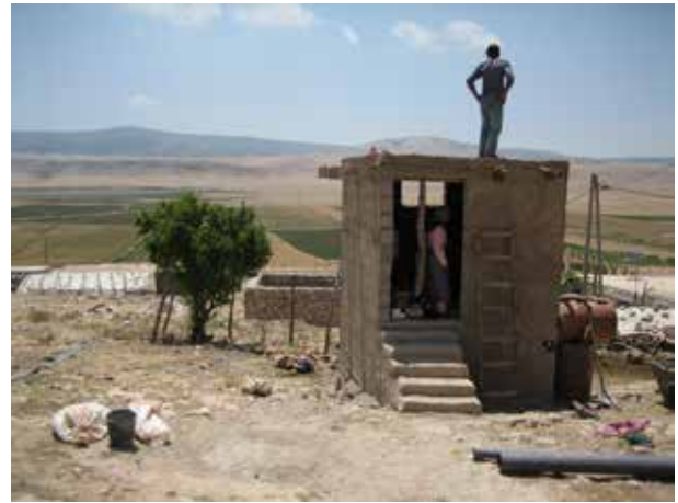
Image 71 : Inspection du gros œuvre de la toilette.
