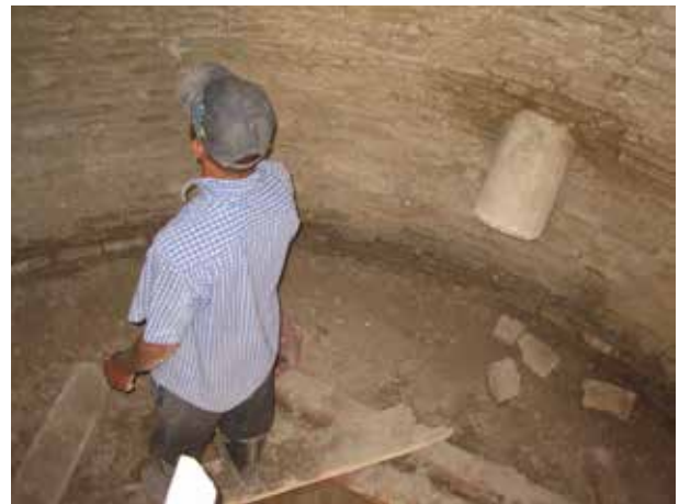
Image 424 : Préparation des surfaces dans la cuve centrale avec un marteau avant de poser l'enduit.
