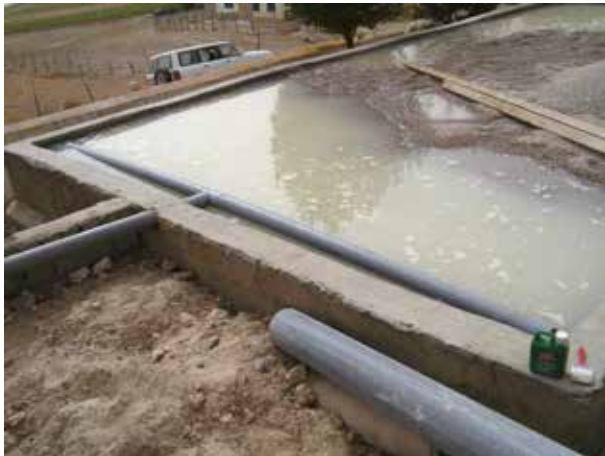
Image 574 : Le tuyau d'alimentation est placé.
