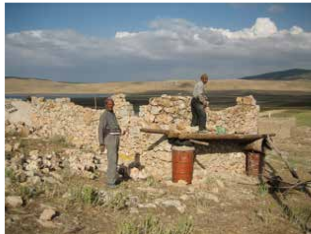
Image 7 : Méthode traditionnelle de construction avec pierres naturelles.
