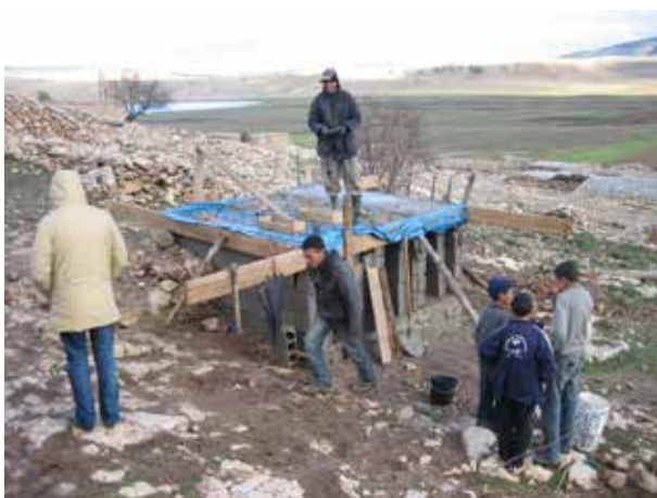
Image 42 : Le chantier pendant la coulée de la dalle.
