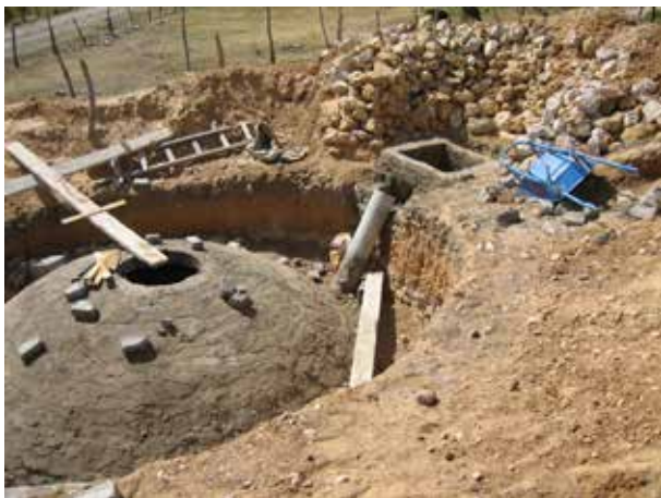
Image 420 : Les briques sont montées jusqu'au sommet. Un trou d'homme est maintenu.
