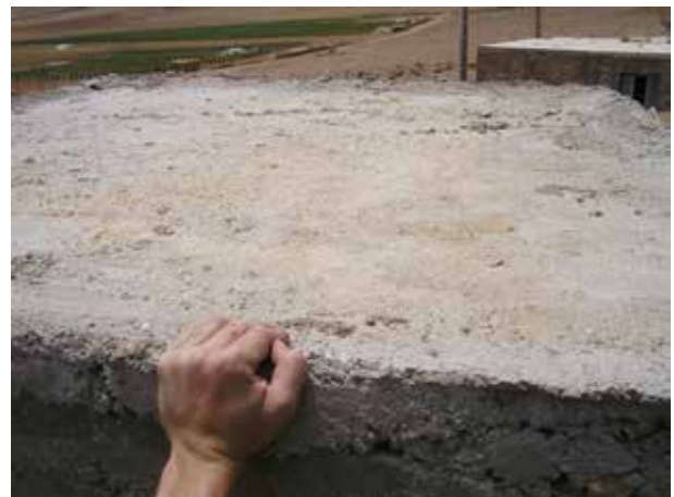
Image 275 : Vue du toit après le séchage.
