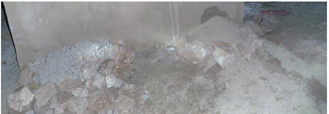
Image 286 : Vue extérieure finale – la tuyauterie est couverte.
