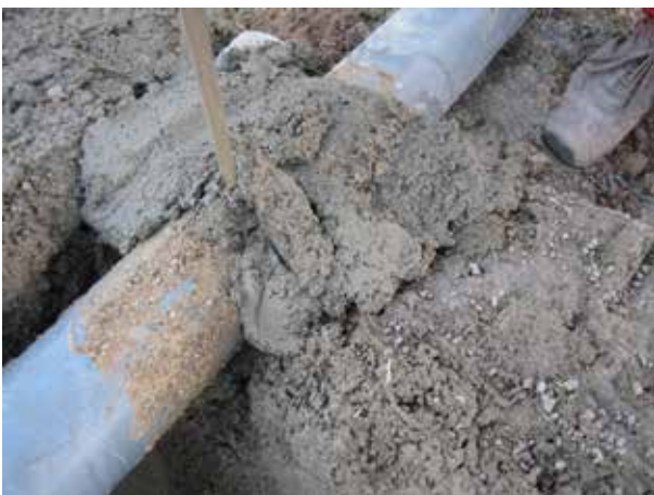
Image 216 : Du mortier est mis autour du tube.
