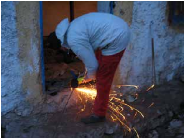
Image 34 : Découpe des fers ronds avec une meuleuse pour le ferrailage de la dalle.
