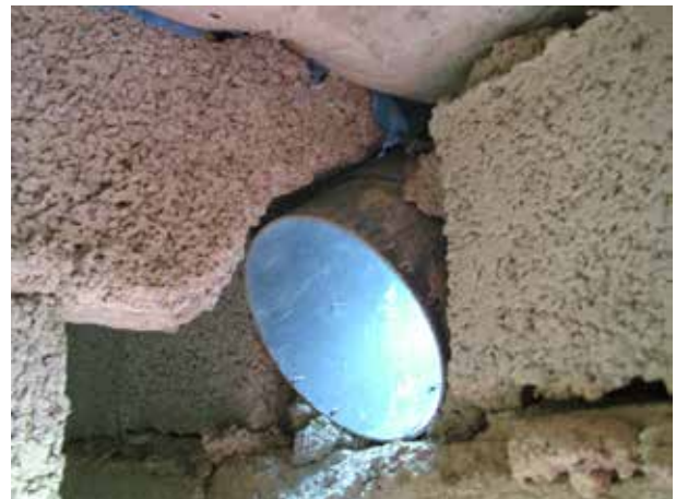
Image 87 : Placement du coude 45° pour le tuyau de ventilation 160 mm.
