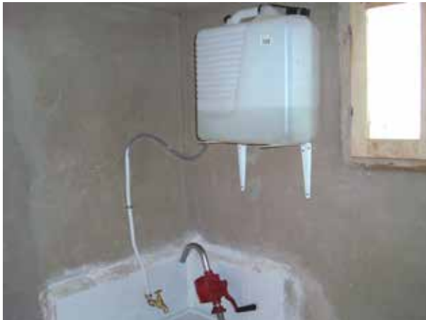
Image 278 : Installation du réservoir et des conduites d'eau.
