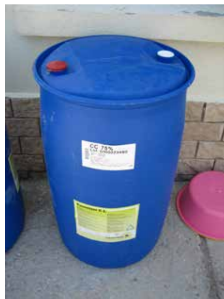
Image 708 : Fût 200 l en HDPE (pour additives pour alimentation animale), utilisé comme réservoir d'urine. Une ouverture pour brancher le tuyau, l'autre pour pomper.
