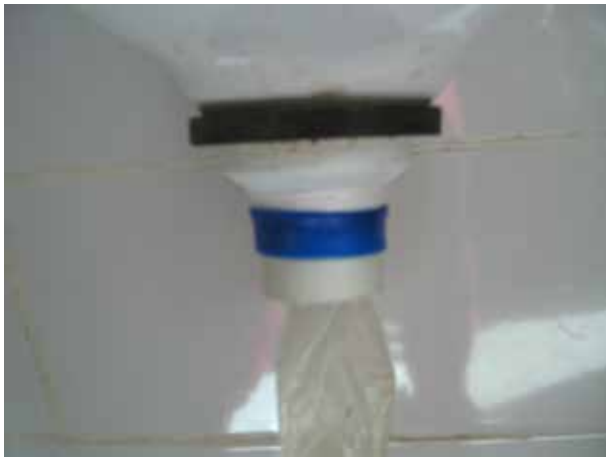
Image 193 : Un préservatif avec bout coupé est attaché à la sortie de l'urinoir pour retenir les odeurs dans le tuyau.
