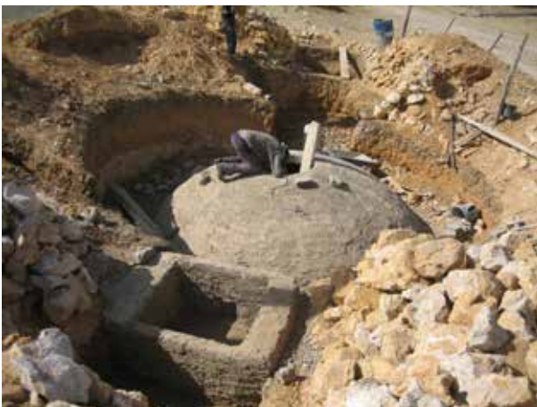
Image 431 : Vue globale du chantier.
