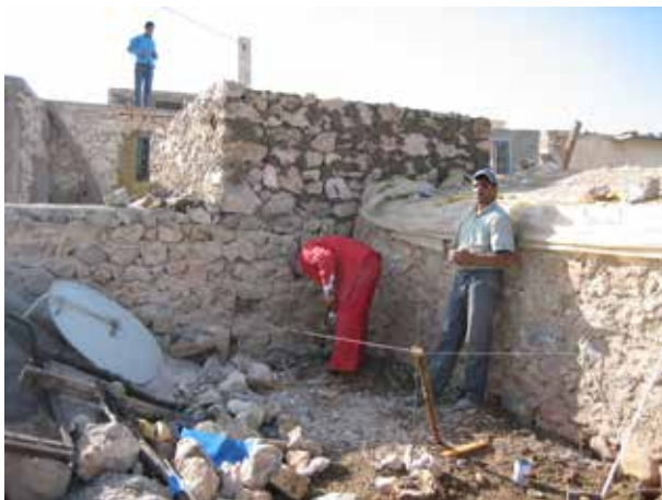
Image 354 : La corde de délimitation montre le placement du filtre planté en aval de la TDSU.
