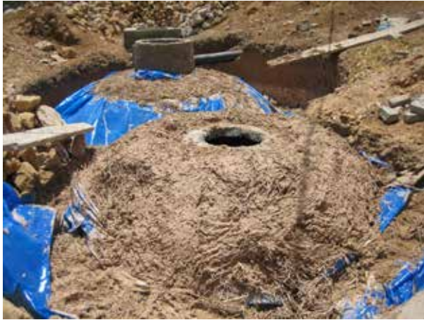
Image 452 : Une couche du matériau est aussi posée sur les parois du bassin d'expansion. La couverture avec une bâche en plastique empêche le séchage de l'argile.
