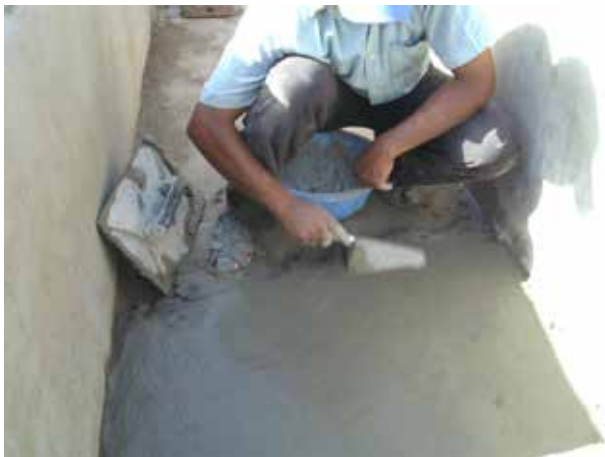
Image 220 : Application des enduits étanches à l'intérieur du bassin.
