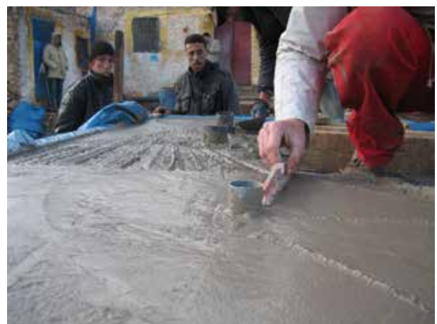
Image 43 : Une pente est formée autour du conduit d'écoulement de la douche.
