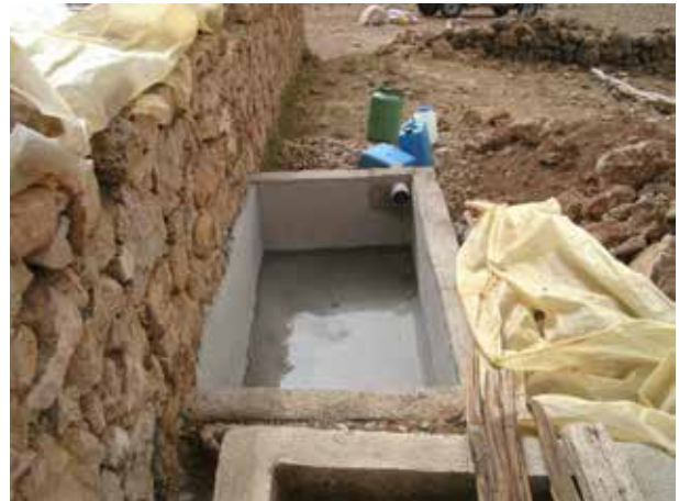
Image 292 : Après application et séchage des enduits étanches le bassin est rempli d'eau.
