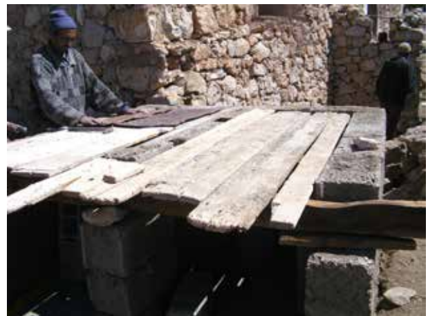
Image 243 : Préparation du support avec des planches disponibles.
