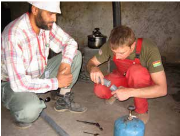
Image 86 : Préparation d'un manchon avec un tube chauffé et l'outil.
