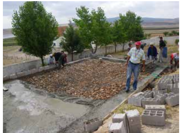
Image 551 : Pose de la dalle de fond du filtre végétalisé.
