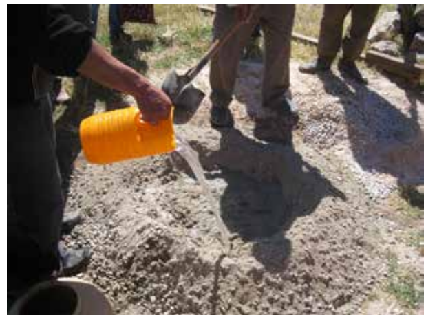
Image 131 : Préparation du béton pour la fondation.
