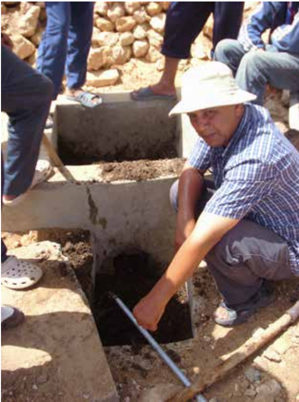
Image 477 : Première alimentation du digesteur.
