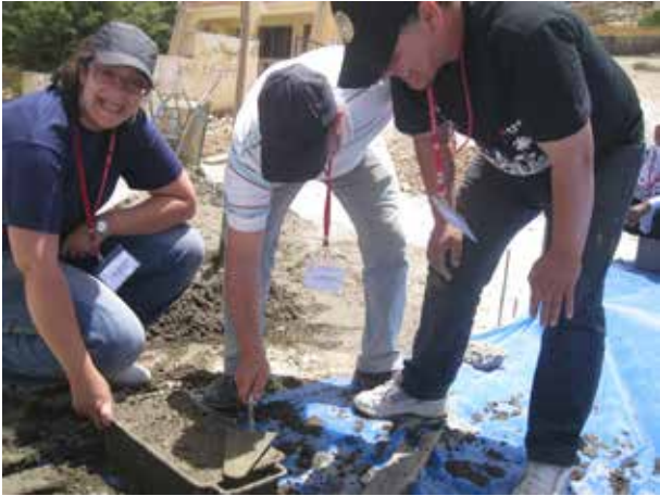
Image 661 : Les participants de l'atelier gagnent de l'expérience pratique sur les chantiers (filtre planté).
