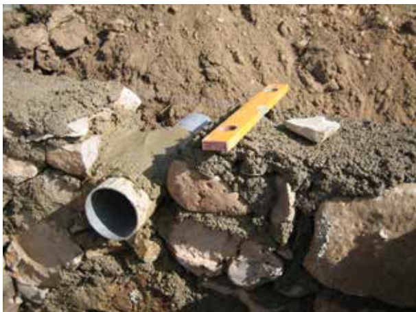
Image 210 : Pose du tuyau de sortie.
