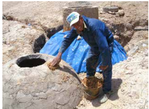
Image 528 : Pose de la couche isolante sur le bassin d'expansion. Un plastique couvre l'isolation du digesteur pour éviter son séchage.
