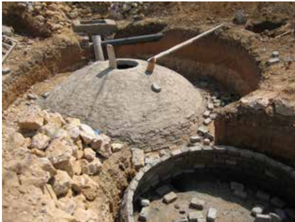
Image 444 : Vue du chantier. Le bassin d'expansion est en construction.
