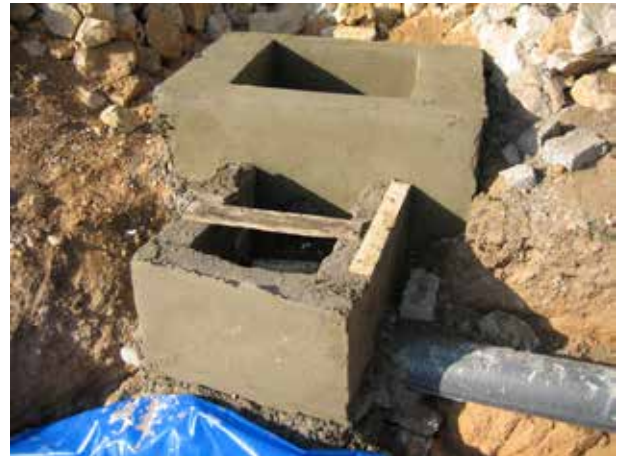
Image 436 : Une couche d'enduit est posée.
