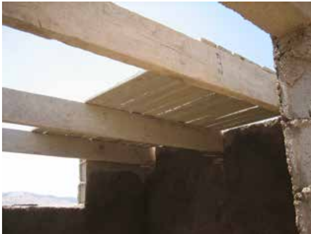
Image 58 : Support pour le toit en train de préparation.
