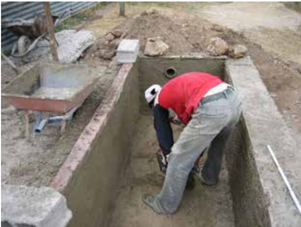
Image 212 : La première couche de l'enduisage est presque finalisée. Le tube de sortie est déjà incorporé au mur.
