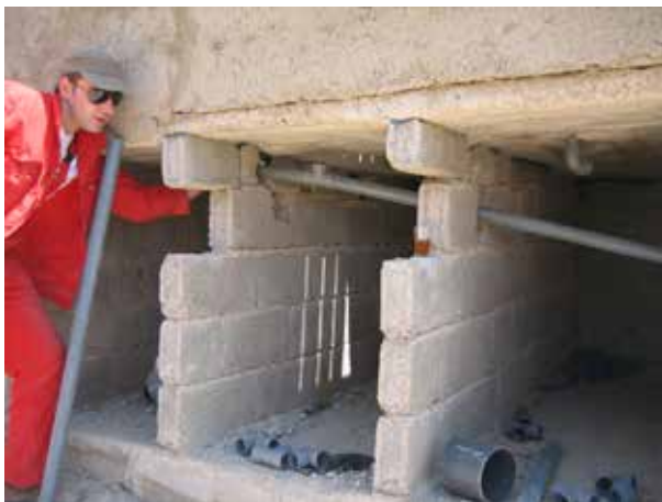
Image 80 : Installation des tuyaux avant la fixation des portes des fosses.
