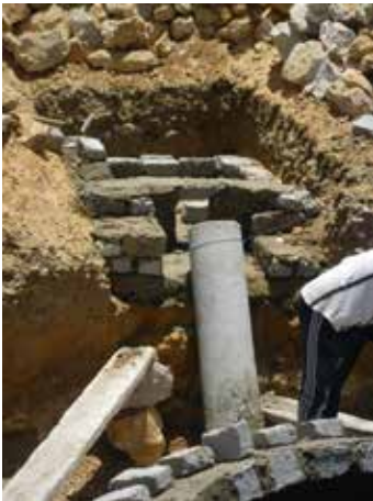
Image 429 : Le bac d'alimentation en construction.
