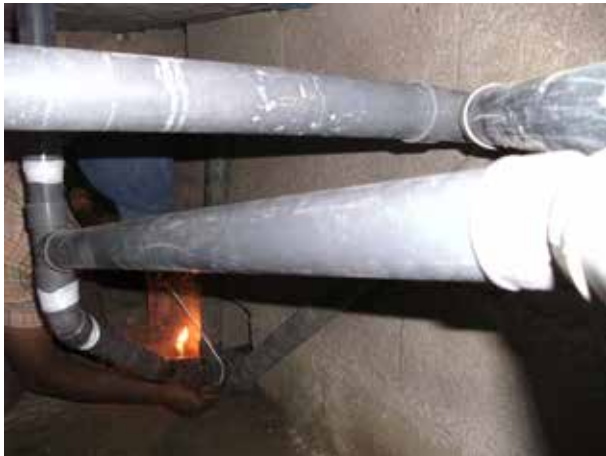
Image 181 : Travaux d'installation dans la 3 ème chambre (celle pour la tuyauterie).
