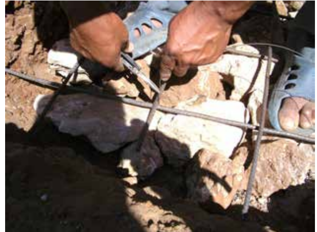
Image 357 : Préparation du ferrailage pour la dalle du filtre planté.
