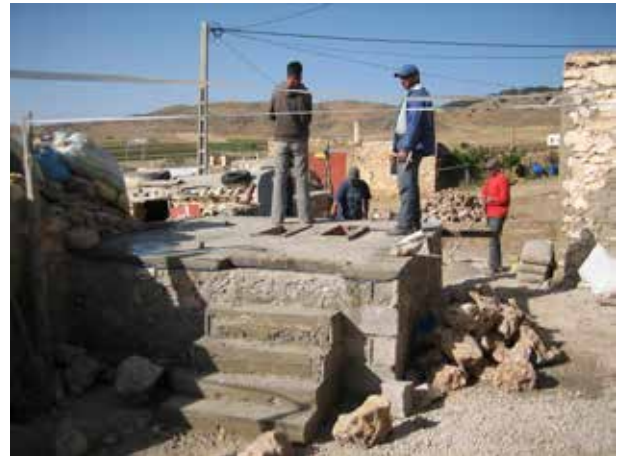
Image 316 : Escalier et dalle finalisés.
