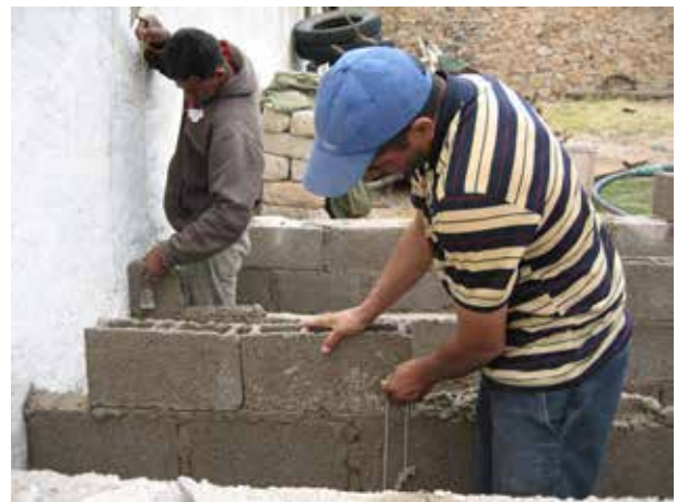
Image 138 : Utilisation d'un fil à plomb.
