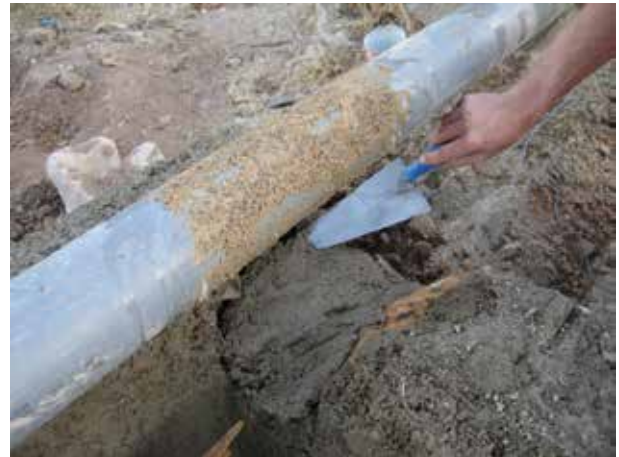
Image 215 : Mise en place du tube d'entrée.
