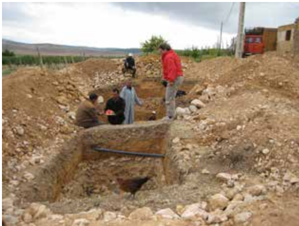
Image 375 : L'excavation rectangulaire au premier plan est prévue pour la fosse de stockage de l'effluent.
