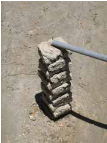
Image 396 : Mur et baguette de mesure au centre de la cuve du digesteur.
