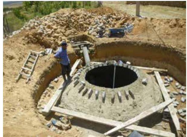
Image 419 : Le bac d'alimentation et le dôme du digesteur en construction.
