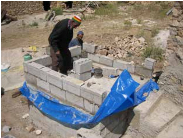
Image 260 : Construction des murs de la superstructure.
