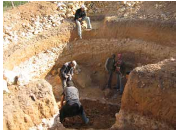
Image 380 : Travaux d'excavation à l'aide du marteau pneumatique.
