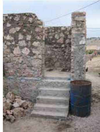
Image 326 : Les murs sont finalisés.
