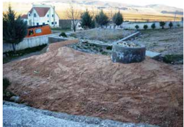
Image 587 : Remblaiement du digesteur et des conduites.
