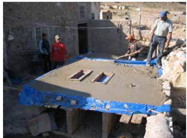
Image 312 : Le tuyau dans le béton forme le trou pour la conduite d'écoulement de la douche.
