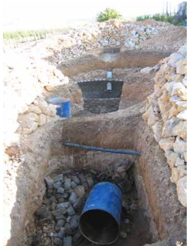
Image 411 : Vue de la buse d'alimentation et du chantier de la station biogaz.
