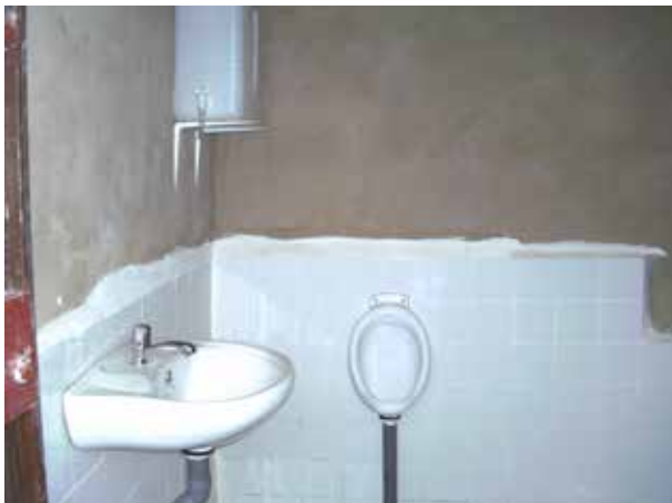
Image 195 : Réservoir d'eau, lavabo et urinoir sont installés.
