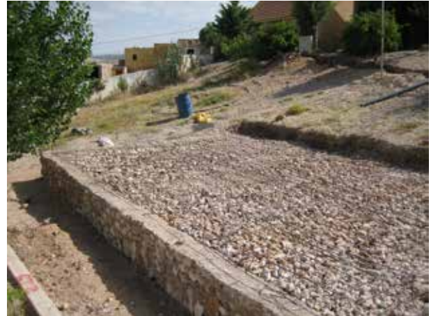
Image 545 : Vue de la fondation du filtre avant de couler la dalle.
