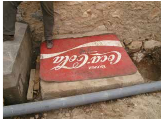
Image 353 : Le réservoir d'urine est enterré et couvert. Comme ça on peut éviter que l'urine se congèle en hiver.
