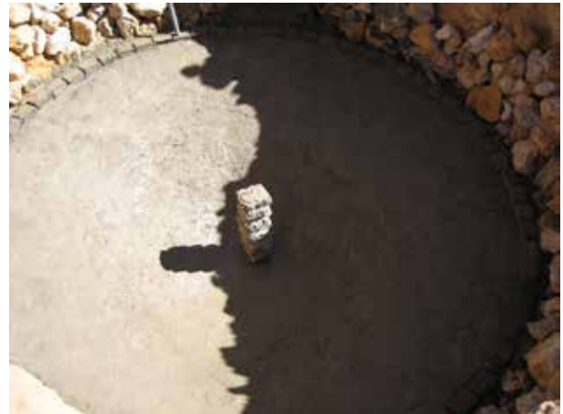
Image 393 : Une couche de 7 cm de béton est posée sur le fond de la cuve.
