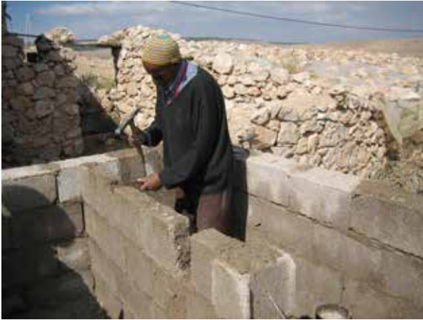
Image 240 : Préparation des niches où vont passer les conduites (urine et eaux nettoyage anal).
