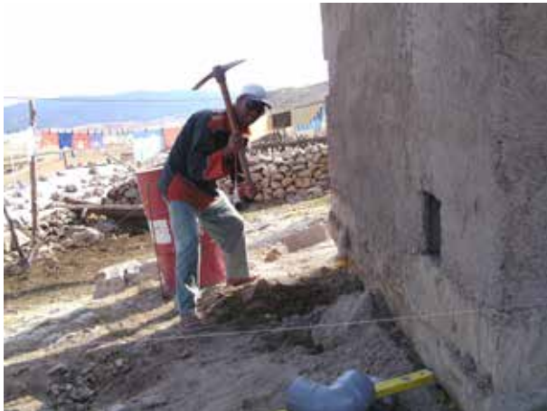
Image 113 : Démarrage des travaux d'excavation pour le filtre planté.
