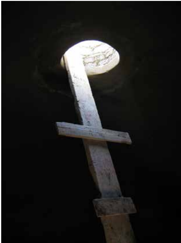
Image 427 : Dans la cuve centrale du digesteur.
