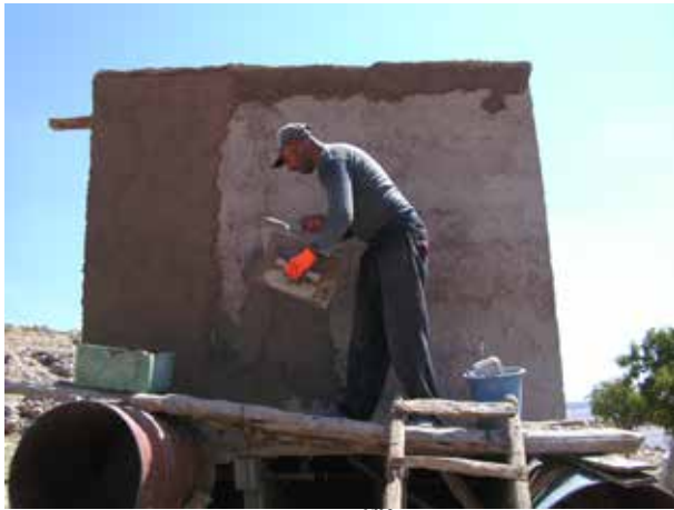
Image 70 : Application de la 2 ème couche d'enduits.
