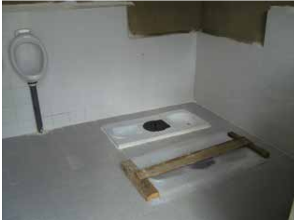
Image 197 : L'intérieur de la salle de bain est finalisé. Pour prévenir que les deux fosses sont remplies en même temps un des deux sièges de toilette est couvert.
