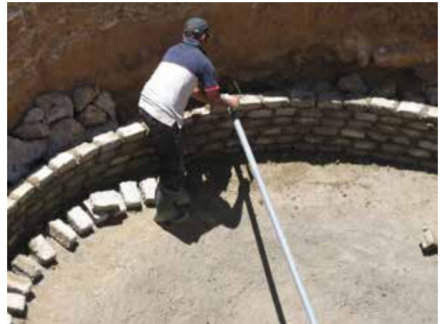
Image 403 : Utilisation de la baguette de mesure pour bien placer le bloc.
