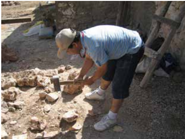
Image 649 : Les participants de l'atelier gagnent de l'expérience pratique sur les chantiers (TDSU Khaled).
