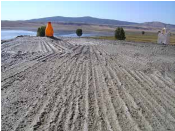
Image 331 : Le toit est finalisé. La bouteille orange sert de garde-place pour la sortie de la cheminée.
