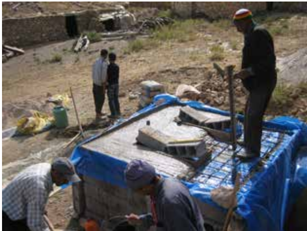
Image 256 : La dalle en train d'être coulée.
