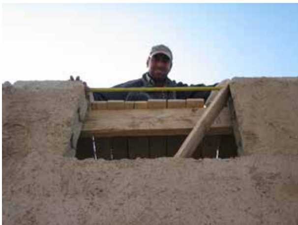
Image 62 : Préparation du coffrage pour le linteau au-dessus de la fenêtre.
