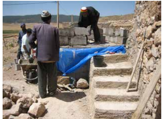
Image 261 : Construction des murs de la superstructure.
