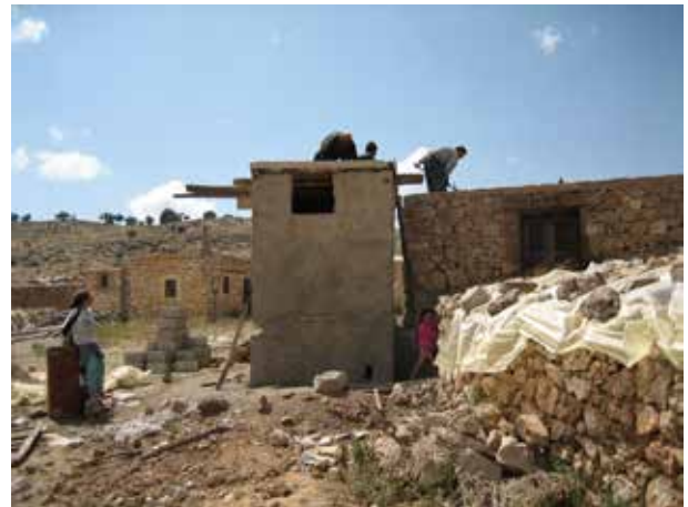
Image 269 : Préparation du coffrage pour le toit qui est porté par des poutres transversales.
