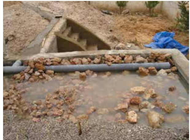
Image 581 : Le tuyau d'alimentation est ajusté à l'horizontale.
