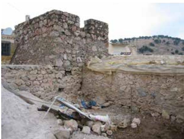
Image 323 : Le gros œuvre avec niche pour la fenêtre.
