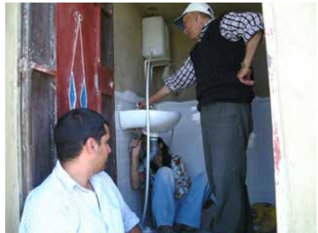
Image 196 : Installation du tube en métaloplastique pour l'approvisionnement en eau.
