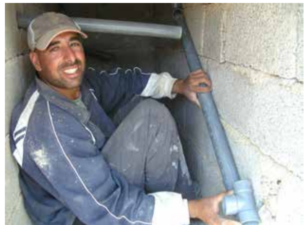
Image 81 : Installation de la tuyauterie.
