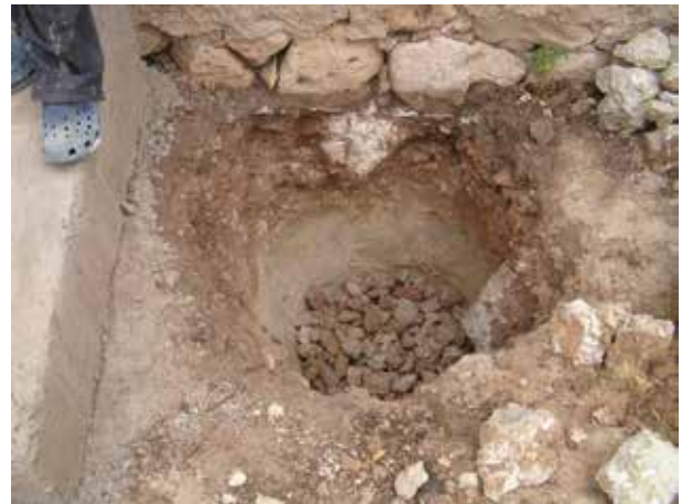
Image 349 : Excavation du filtre (puisard) pour l'eau de lavage anal, avec des moellons comme première couche de matériau de filtre. Au-dessus, du gravier va suivre.
