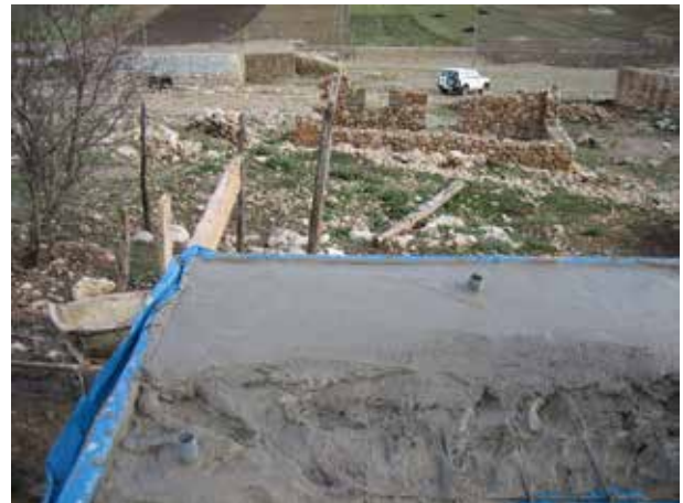
Image 41 : Les tuyaux (garde-places) restent vides pour former les trous dans la dalle.
