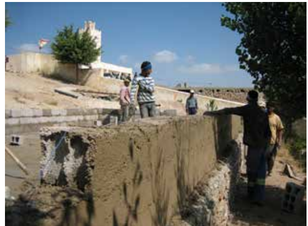
Image 557 : Application d'enduits sur les parois externes.
