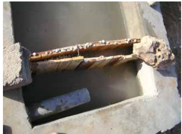
Image 225 : Avec des planches à la zone de l'entrée, les 3 différentes tailles du grain sont séparées pendant le placement du matériau de filtre.
