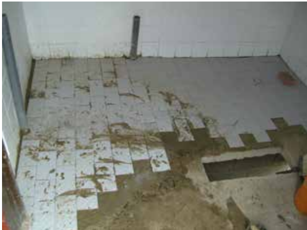
Image 102 : Pose du carrelage sur la dalle.
