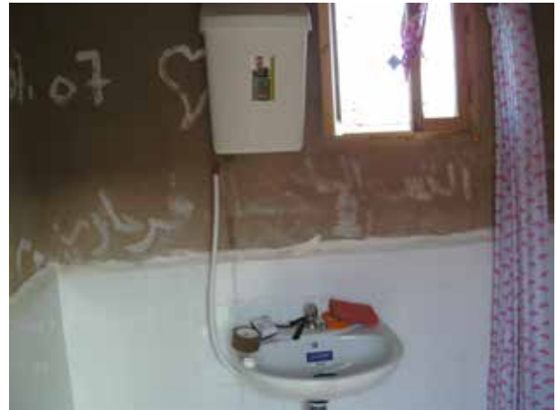
Image 109 : Une poubelle sert comme réservoir d'eau pour le lavabo.
