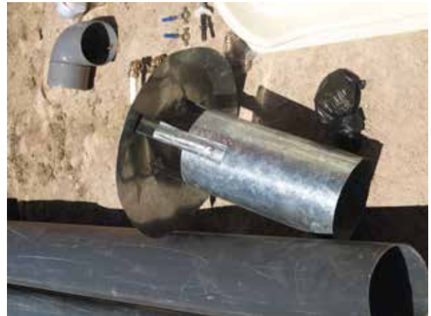
Image 91 : Chapeau à placer au-dessus du tuyau de ventilation.
