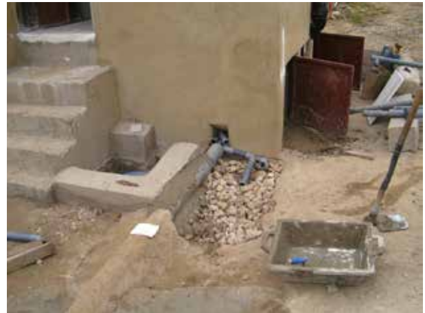
Image 188 : Une couche de moellons est placée à la superficie du filtre.
