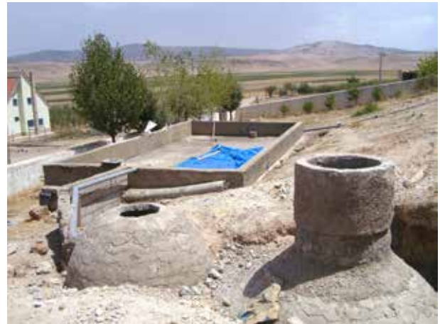
Image 524 : Digesteur et bassin d'expansion après séchage (juillet 2010).
