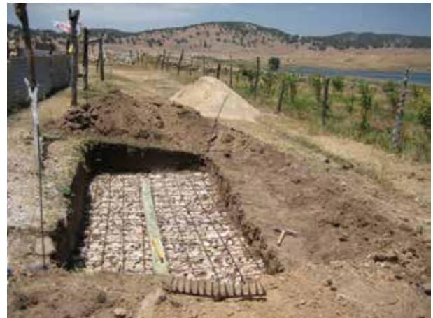
Image 203 : Le ferrailage pour la dalle est placé horizontalement.
