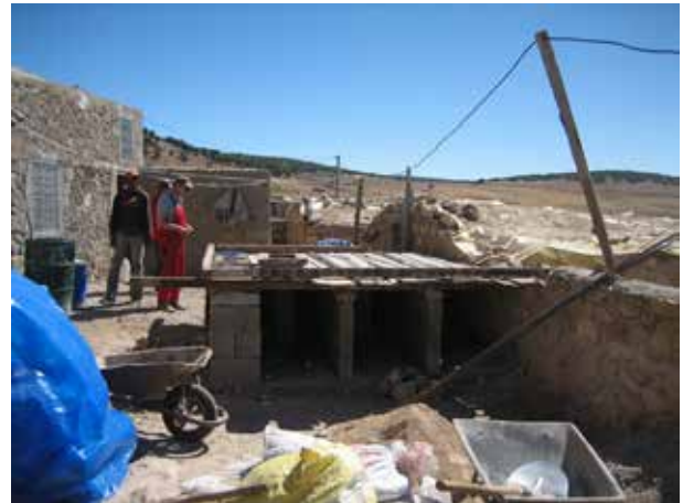
Image 304 : Vue des trois fosses et du support.
