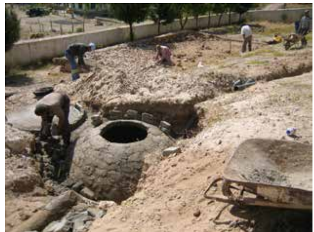
Image 541 : Pose d'une couche de pierres concassées.
