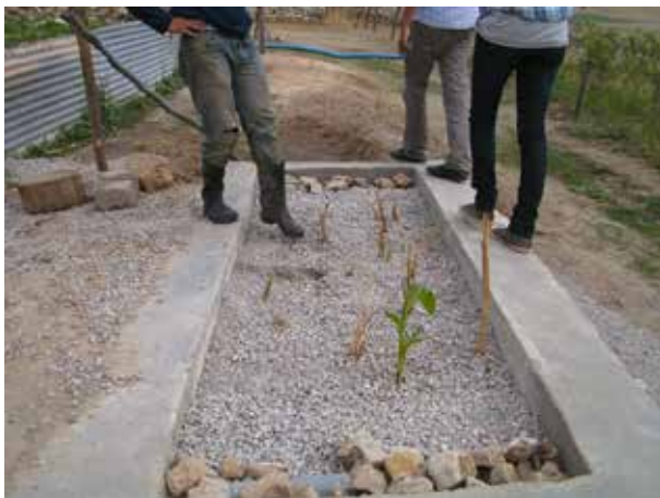
Image 230 : Le filtre est finalisé. Quelques roseaux sont déjà plantés.
