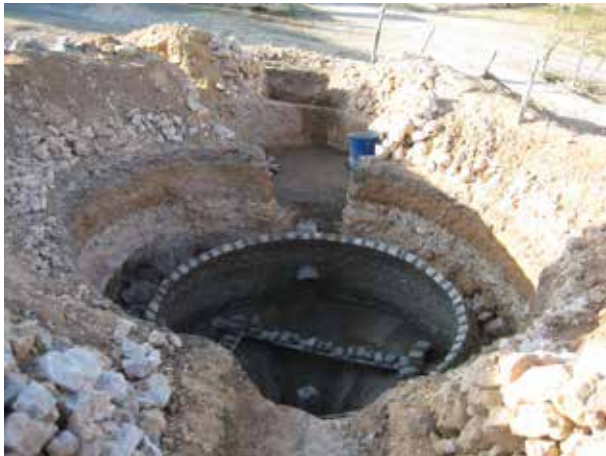
Image 412 : Le radier du fond du bassin d'expansion est posé.
