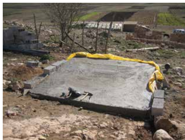
Image 23 : La fondation accomplie.
