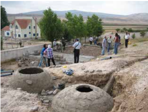
Image 663 : Les participants de l'atelier gagnent de l'expérience pratique sur les chantiers (filtre planté).
