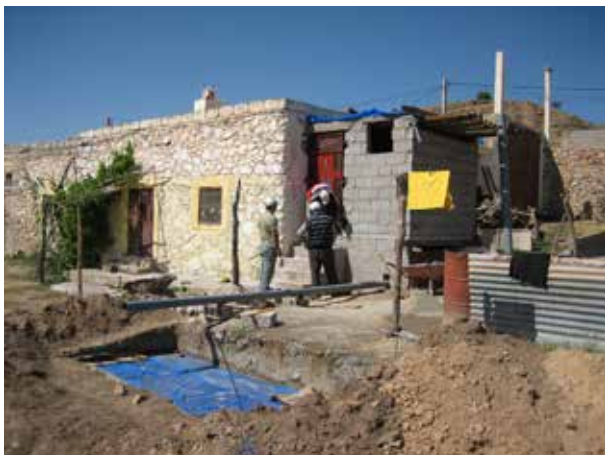
Image 204 : La dalle bétonnée est couverte par un plastique pendant le séchage.
