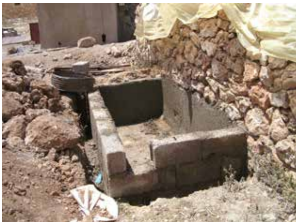
Image 289 : Murs du filtre finalisés, avec couche d'enduits intérieurs et niche pour le tuyau de l'effluent.
