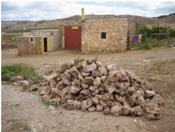
Image 695 : Pierres naturelles utilisées pour la construction de la toilette de famille Khaled.
