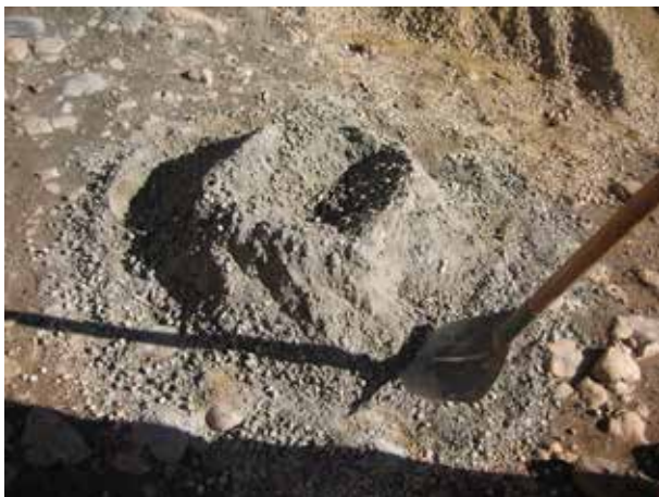
Image 18 : Mélange sec de gravier, sable et ciment.
