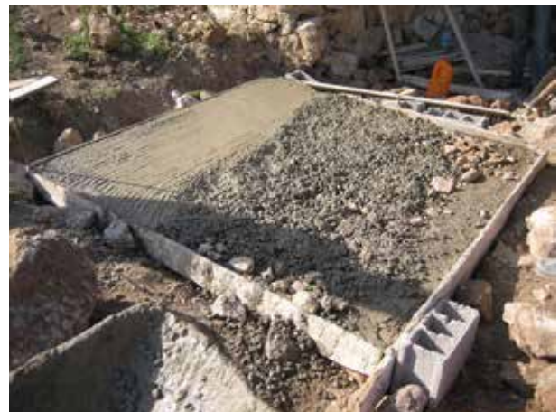
Image 235 : Coulée de la fondation. Pour épargner du béton le volume est partiellement rempli de pierres.
