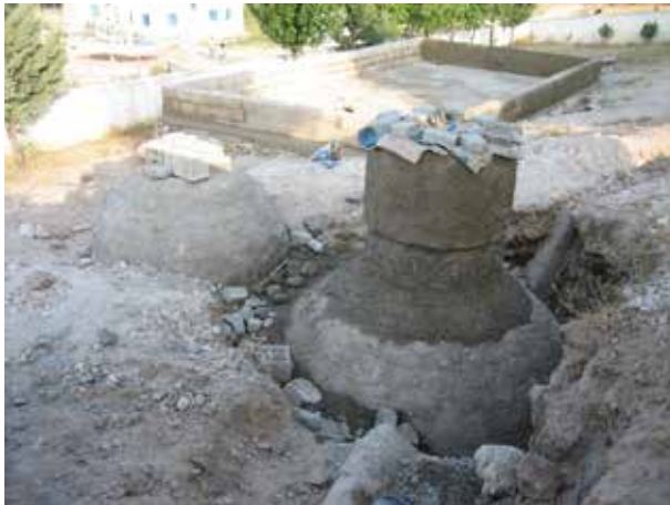
Image 523 : Un enduit extérieur est appliqué sur le digesteur et la couronne de couvercle.
