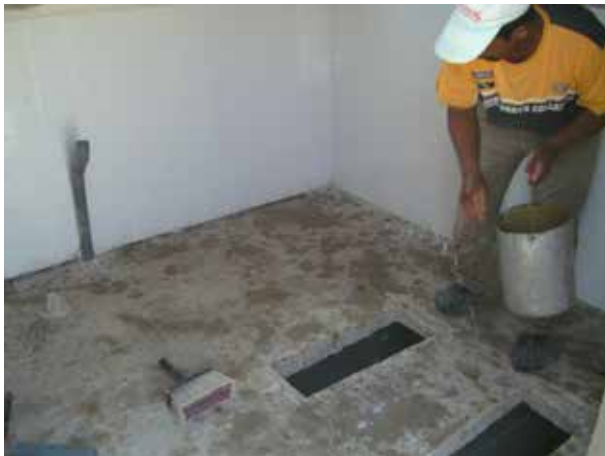
Image 100 : Humectage du béton avant la pose du carrelage.
