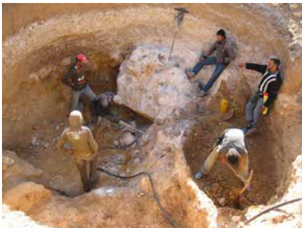
Image 381 : Travaux d'excavation à l'aide du marteau pneumatique.
