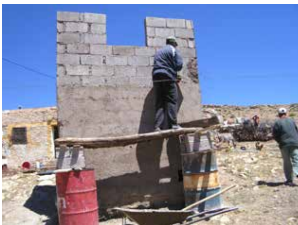
Image 56 : Application de la 1 ère couche d'enduits aux parois extérieures de la toilette.
