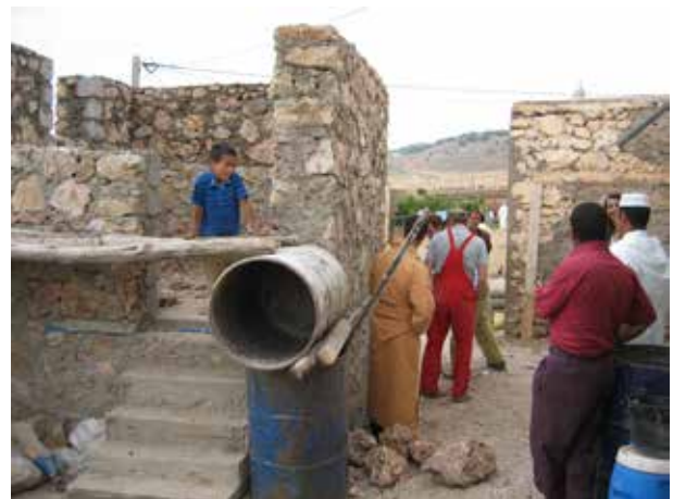
Image 322 : Le chantier pendant la construction de la superstructure.
