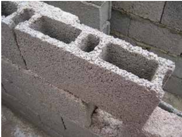
Image 703 : Briques (blocs) en béton 20 x 10 x 40 cm.
