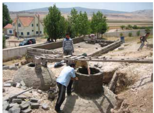
Image 522 : Pose des dernières rangées de briques de la couronne.
