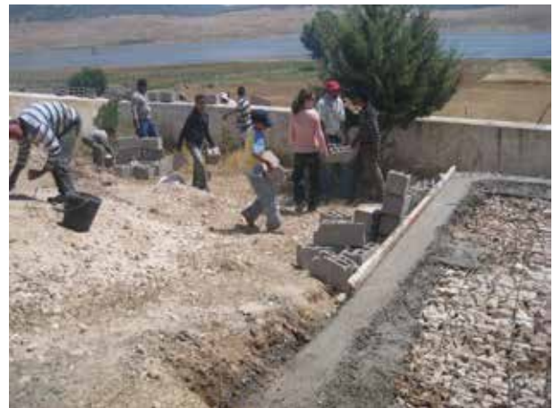
Image 547 : Pose de béton au bord du filtre pour la première rangée de briques.
