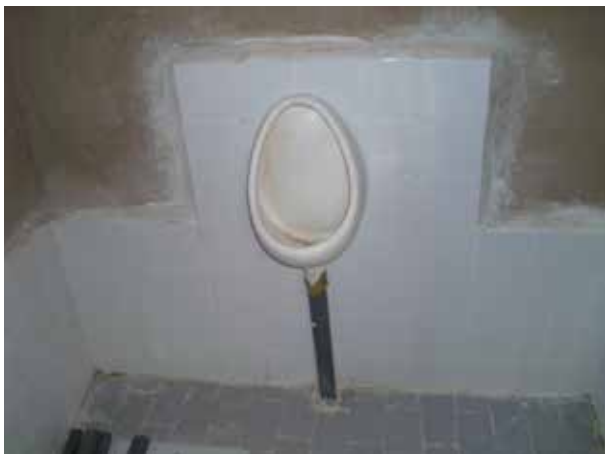
Image 280 : L'urinoir sec est installé.
