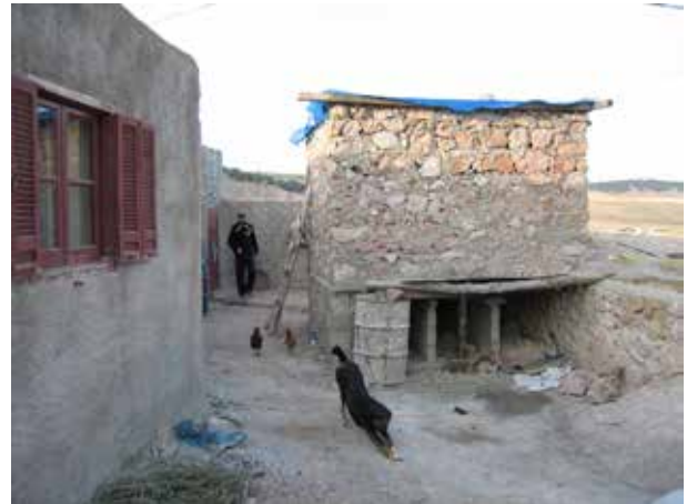
Image 332 : Le toit est couvert par un plastique pour que le béton ne sèche pas trop rapidement.
