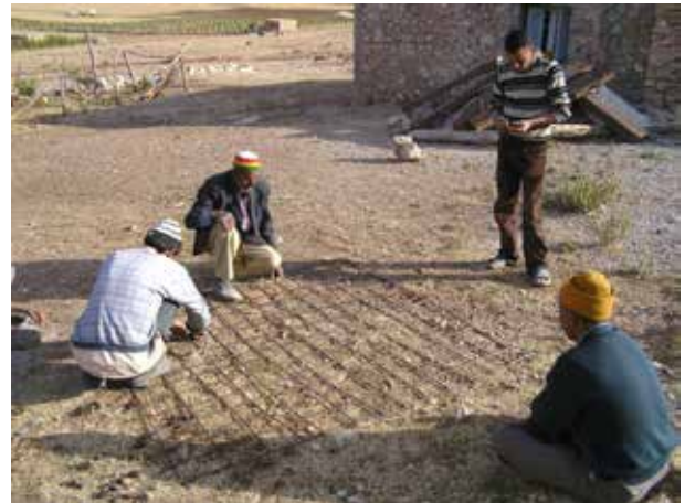
Image 267 : Préparation du ferrailage.
