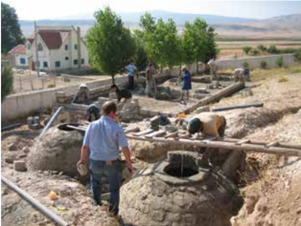
Image 554 : Pose de la 2 ème rangée de briques des parois du filtre.
