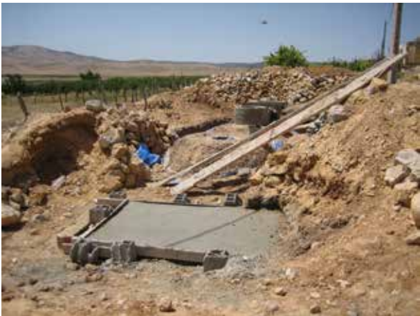
Image 466 : Le couvercle en béton armé est coulé.
