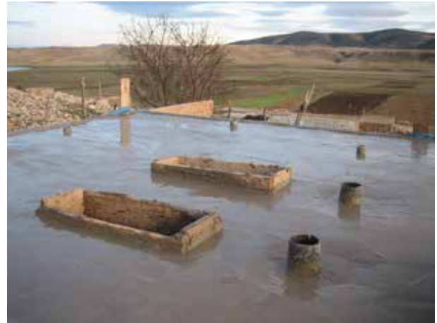
Image 45 : La dalle fraîche avec des formes pour sièges de toilette et sorties pour lavabo, urinoir, douche et nettoyage anal.
