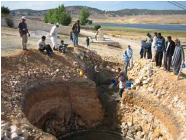
Image 392 : Préparation du béton pour le radier.
