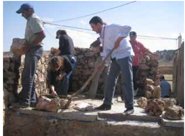
Image 644 : Les participants de l'atelier gagnent de l'expérience pratique sur les chantiers (TDSU Khaled).
