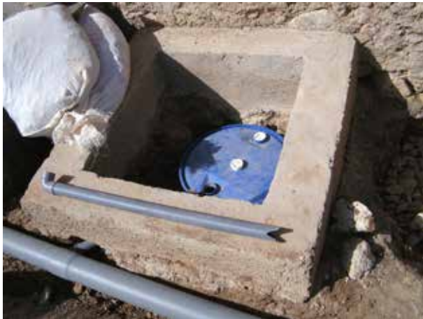
Image 352 : Réservoir d'urine avec tuyau plongeur.
