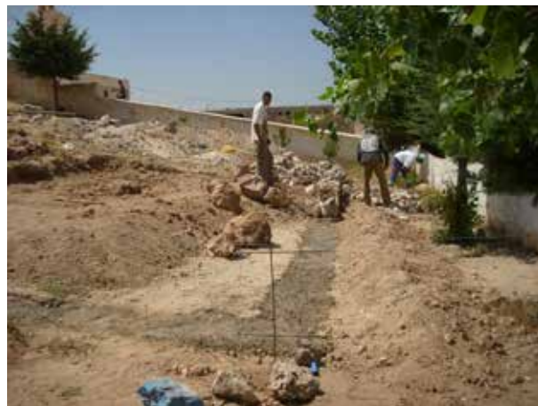
Image 536 : Fondations du filtre végétalisé.
