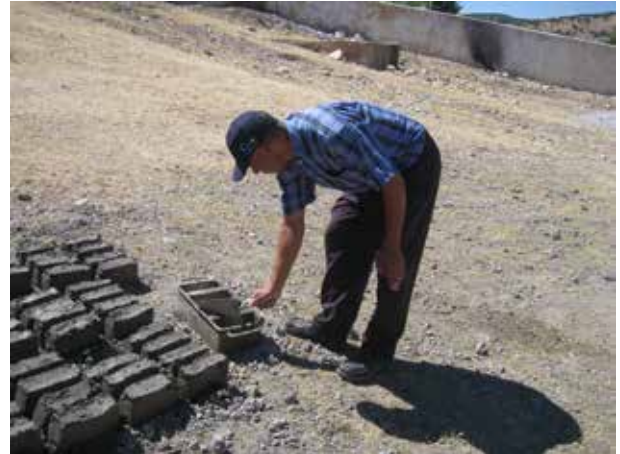
Image 384 : Le maçon démontre l'utilisation des moules à briques.
