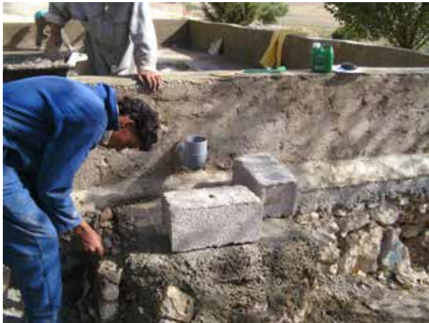
Image 564 : Construction de la chambre de visite à la sortie du filtre.
