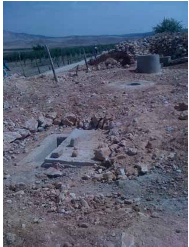
Image 478 : Vue globale du digesteur finalisé. Il manque encore le couvercle du bassin d'expansion.
