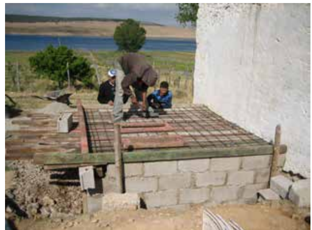
Image 142 : Préparation du ferrailage. Les deux cadres en bois servent comme formes pour les sièges de toilette.
