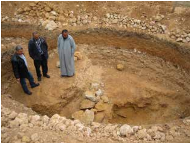
Image 373 : Excavation pour la cuve du digesteur après une semaine de travail.
