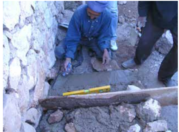
Image 245 : Construction de l'escalier.
