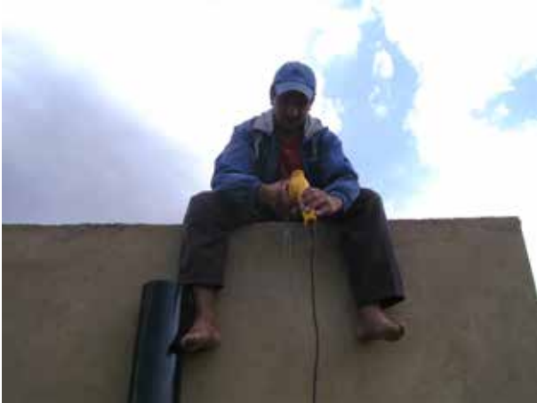
Image 175 : Préparation de la fixation du tuyau de ventilation.
