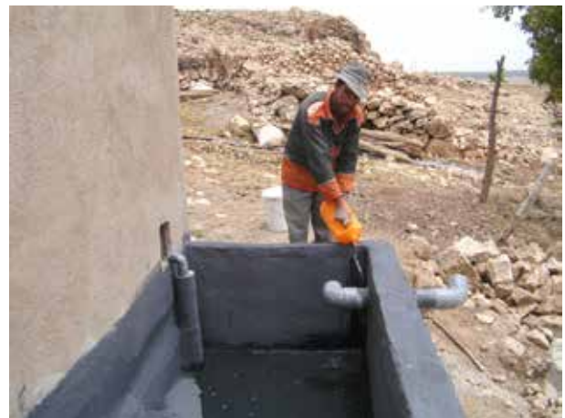
Image 124 : Après l'application d'une couche de bitume le bassin est finalement étanche.
