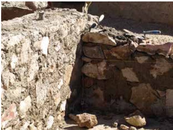
Image 301 : Les fosses sont attachées au mur existant.
