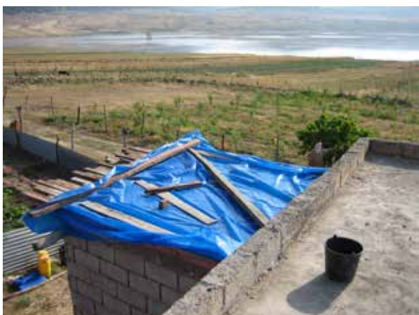
Image 164 : Le toit est couvert par un plastique pour que le béton ne sèche pas trop rapidement.
