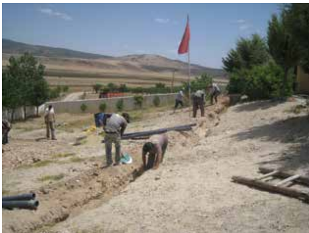
Image 497 : Préparation de la tranchée pour la conduite des eaux usées de l'école.
