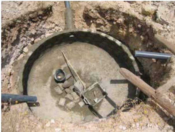
Image 505 : La buse d'alimentation venant de l'école est posée. Le tuyau à gauche est la buse du bassin d'expansion.
