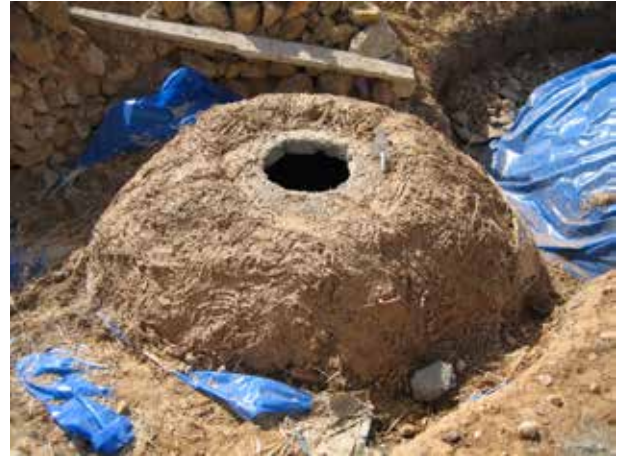
Image 453 : Couche d'isolation en argile et paille.
