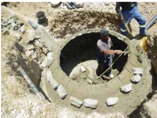
Image 509 : Pour les dernières rangées, l'emploi de contrepoids est nécessaire.
