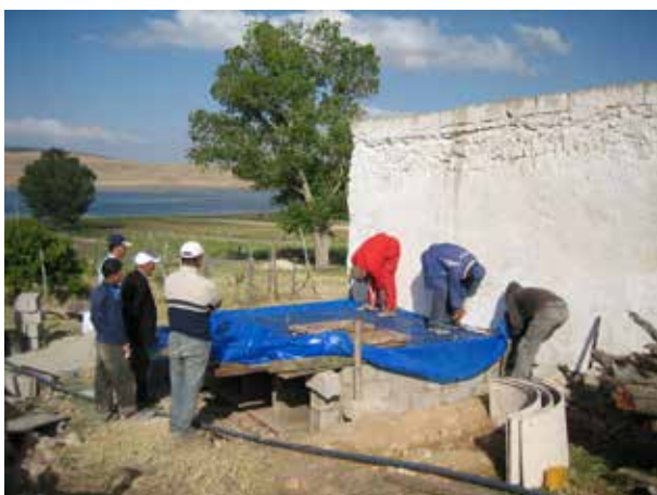
Image 143 : Une bâche en plastique est utilisée pour étancher le coffrage.
