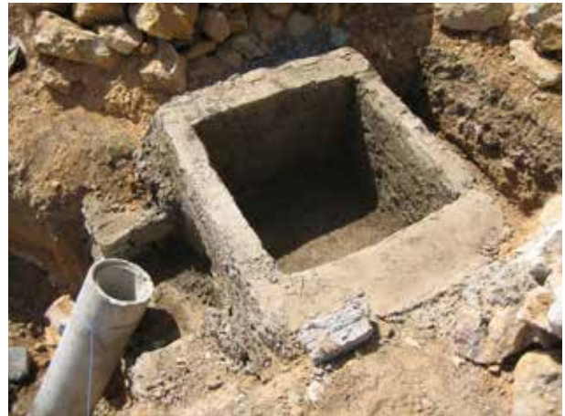
Image 430 : Un enduit est posé dans le bac d'alimentation.
