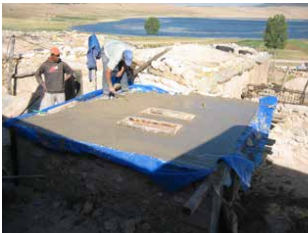
Image 311 : Les ouvriers en train de bétonner la dalle.
