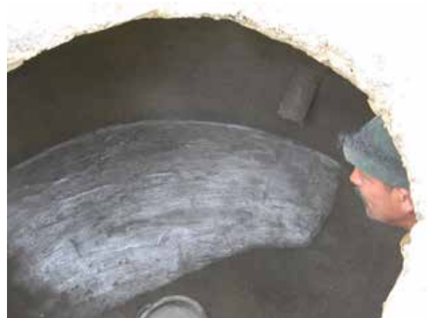
Image 518 : Application du lait de ciment à l'intérieur du bassin d'expansion.
