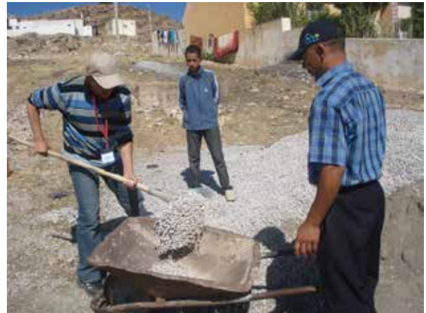
Image 650 : Les participants de l'atelier gagnent de l'expérience pratique sur les chantiers (digesteur).
