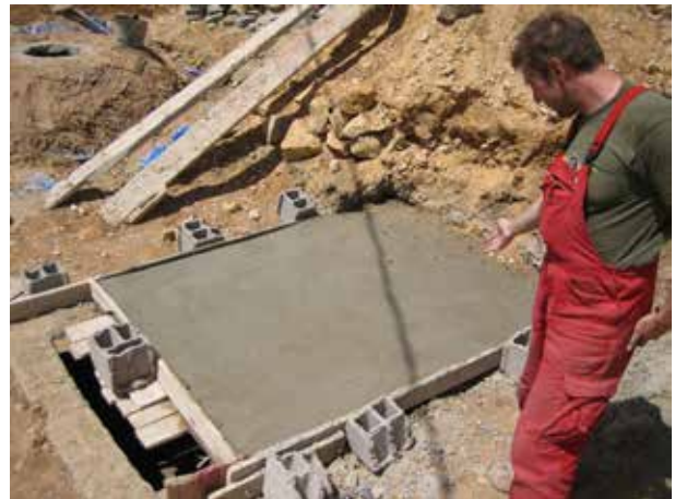
Image 467 : Le couvercle en béton armé est coulé.
