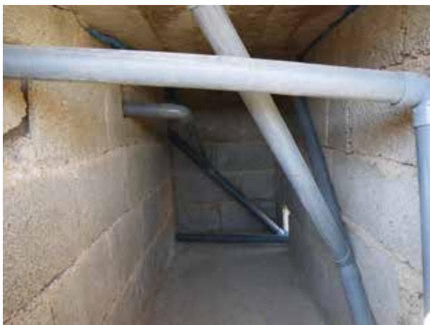
Image 82 : Vue de la tuyauterie dans la 3 ème fosse de la toilette.
