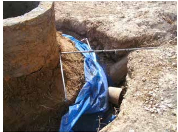
Image 530 : Le tuyau galvanisé avec vanne à bille et piège à eau est posé.
