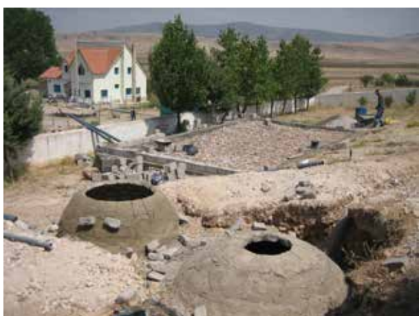
Image 515 : Les rangées de briques sont montées jusqu'à obtenir un trou au sommet de 60 cm de diamètre. Une couche de béton est posée à l'extérieur.
