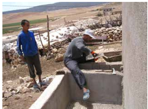
Image 118 : Application d'enduits dans le compartiment pour l'infiltration des eaux de nettoyage anal.
