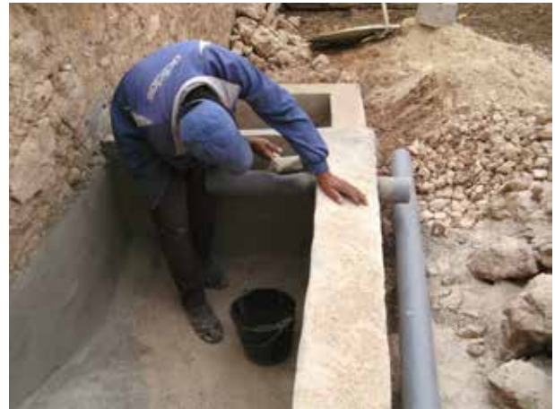
Image 369 : Le lait de ciment étanche les parties autour du tuyau de sortie et finalise la superficie.
