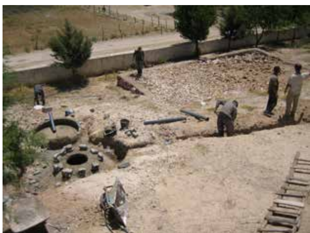
Image 513 : Vue du chantier dans la cour de l'école. Le dôme du digesteur est partiellement remblayé.
