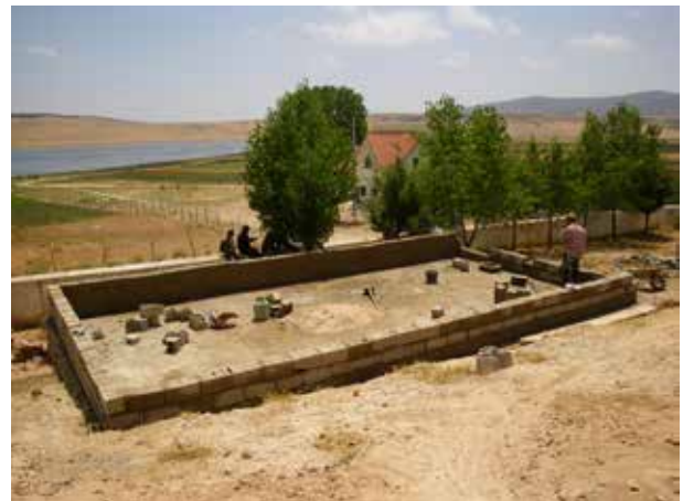
Image 559 : Le bassin du filtre en construction.
