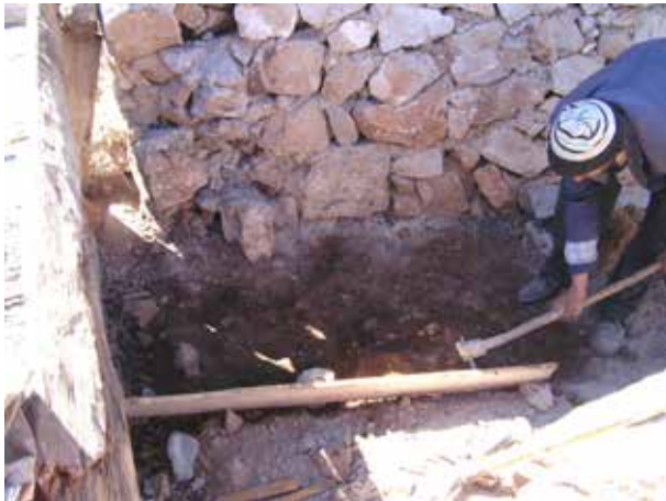
Image 244 : Préparation du terrain pour l'escalier.
