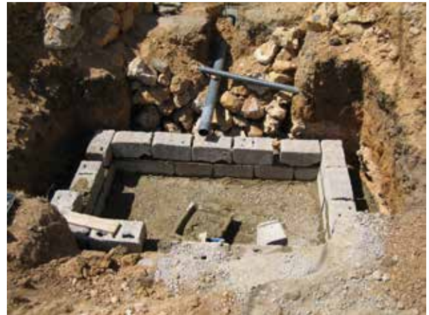
Image 461 : Construction des parois de la fosse.
