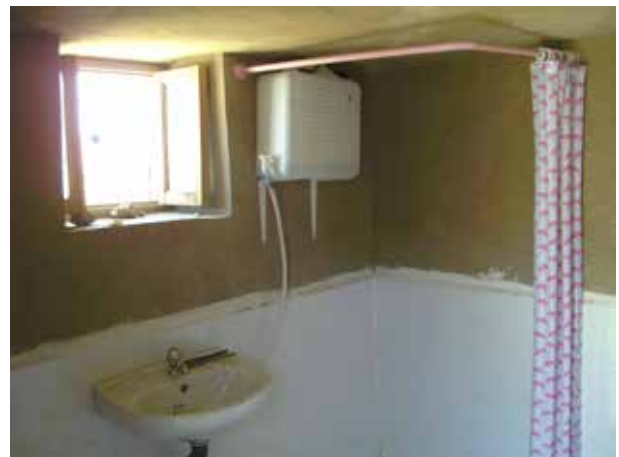
Image 345 : L'intérieur de la salle de bain est finalisé, y compris le rideau de douche et le réservoir d'eau pour le lavabo.
