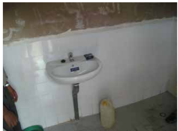
Image 107 : Branchement du lavabo au tuyau PVC avec deux coudes 45°.
