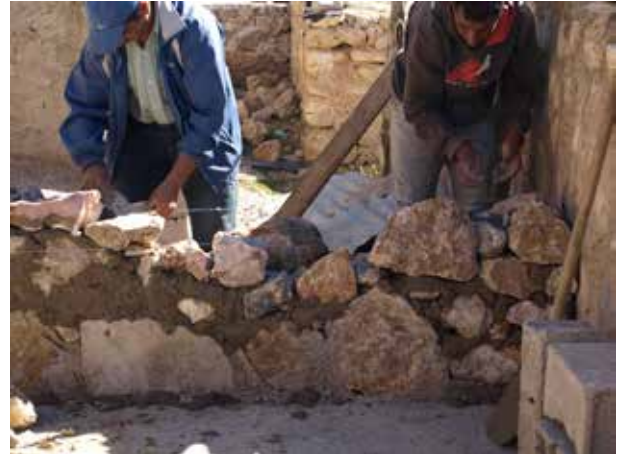
Image 300 : Construction des murs des fosses en pierres naturelles.
