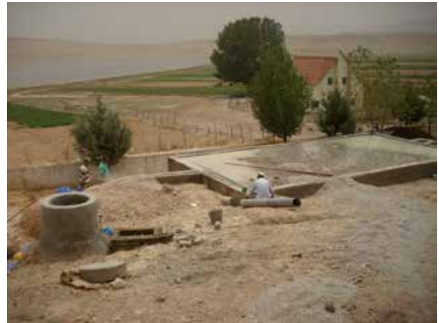
Image 575 : Vue globale du chantier avancé.
