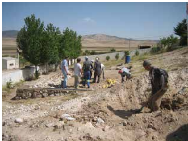
Image 511 : Régalage du site du bassin d'expansion.
