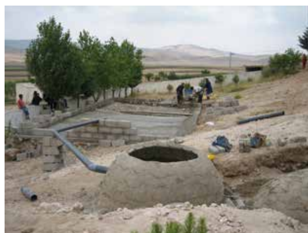
Image 516 : Préparation de la conduite du bassin d'expansion au filtre.
