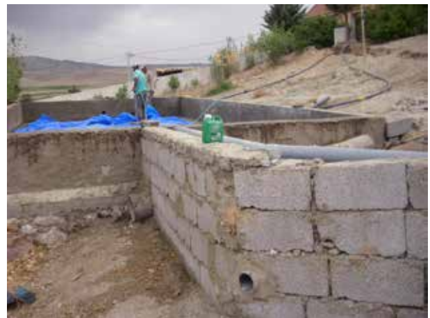
Image 567 : Le mur de protection de la conduite est muni de drains pour l'eau de pluie.
