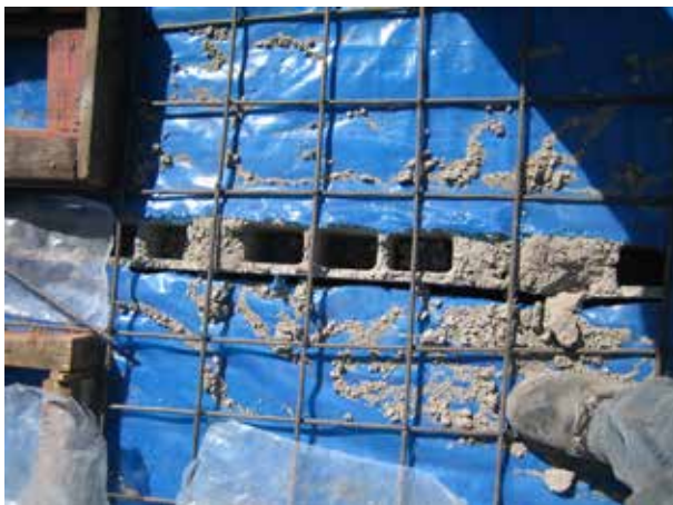
Image 307 : Des trous dans le plastique assurent la bonne liaison de la dalle avec les murs des fosses.
