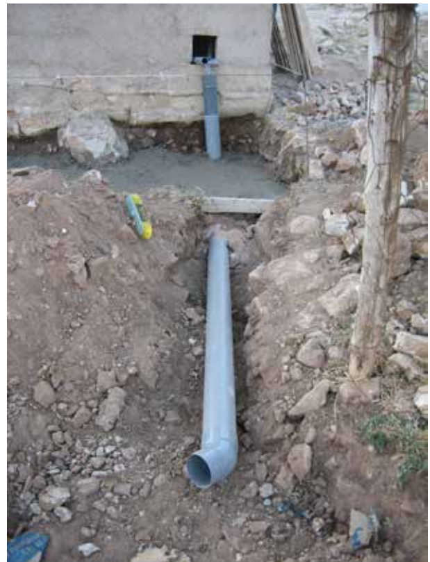
Image 93 : Passage souterrain de la conduite de l'urine au-dessous du filtre planté.
