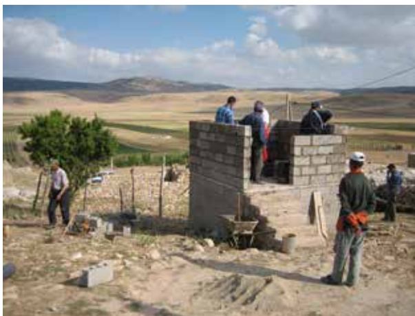
Image 50 : Construction des murs, vue 1.
