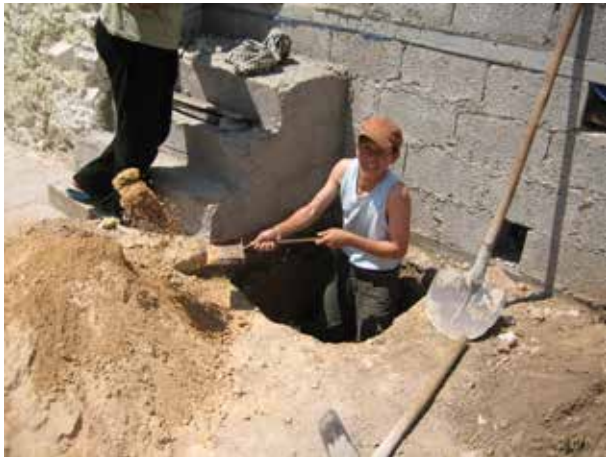
Image 183 : Excavation pour le réservoir d'urine.
