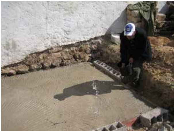
Image 134 : Irrigation du béton frais.
