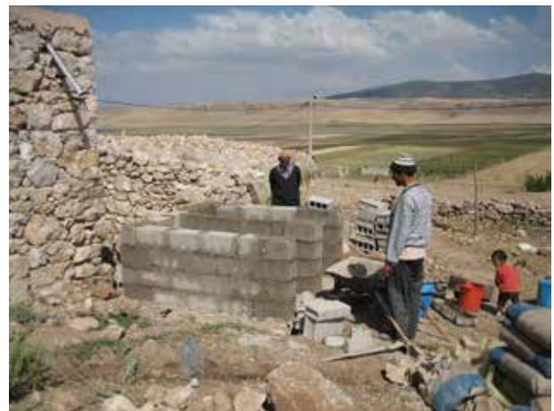
Image 237 : Les briques ont été mouillées avant leur placement.
