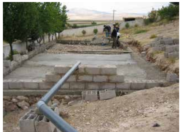
Image 553 : Raccordement au digesteur-décantateur.
