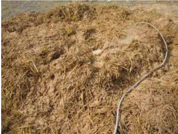
Image 448 : Arrosage du mélange d'argile et de paille.
