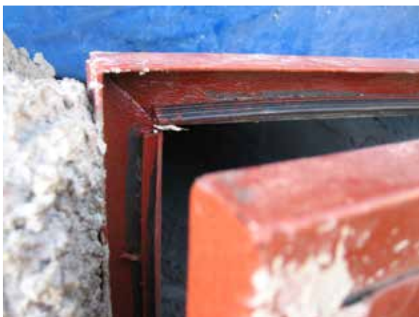
Image 713 : Porte de chambre fécale (fosse) avec gommage pour assurer la fermeture hermétique.
