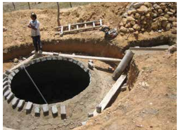
Image 417 : Les dernières rangées sont posées de l'extérieur du digesteur. La baguette de mesure maintient la brique lors de sa pose.
