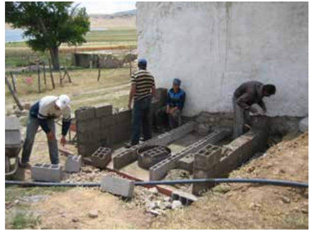
Image 136 : Les briques sont mouillées dans l'eau avant leur placement.
