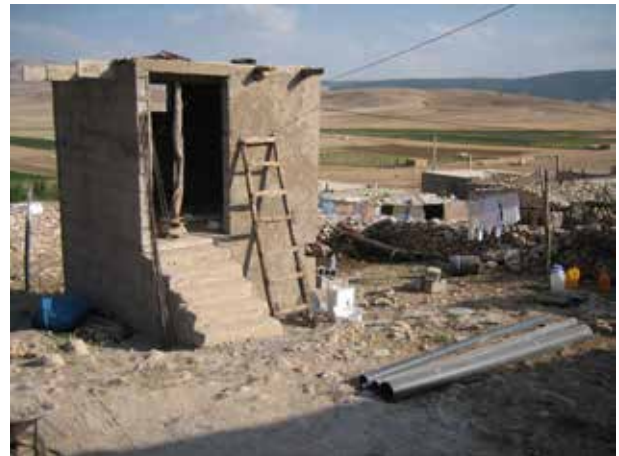
Image 61 : Vue de la toilette avant de bétonner le toit.
