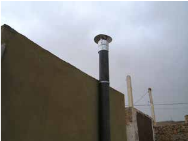
Image 177 : Le tuyau de ventilation est installé.
