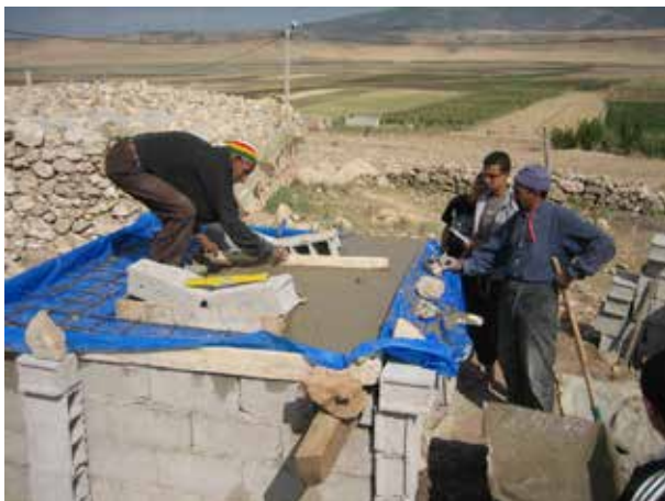
Image 254 : Utilisation d'une planche pour lisser et compacter le béton.
