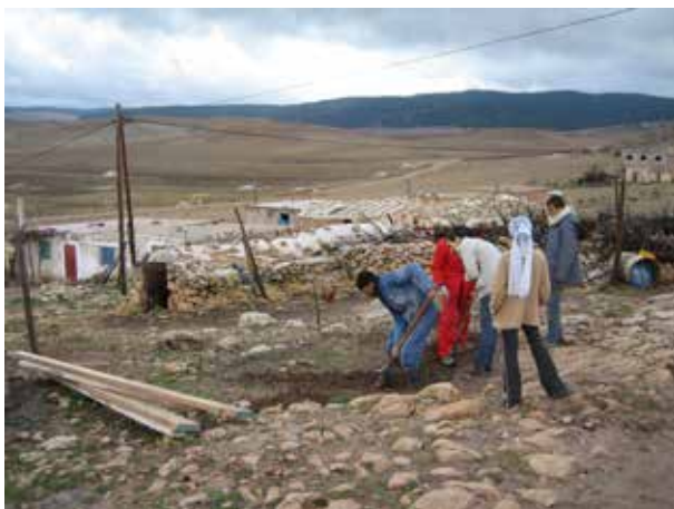
Image 14 : Travaux d'excavation pour la fondation.
