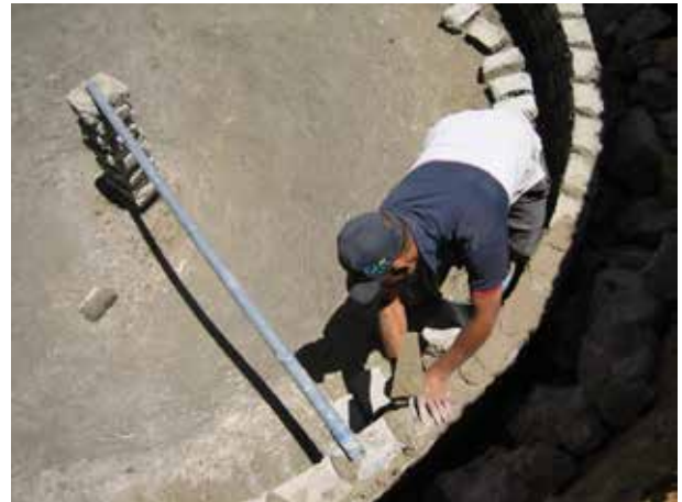
Image 399 : La brique est posée et enfoncée dans le mortier.
