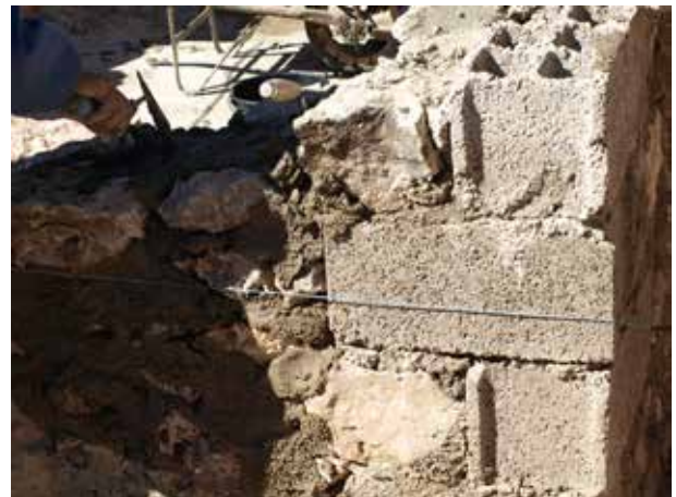
Image 302 : Des briques sont utilisées pour former les angles.
