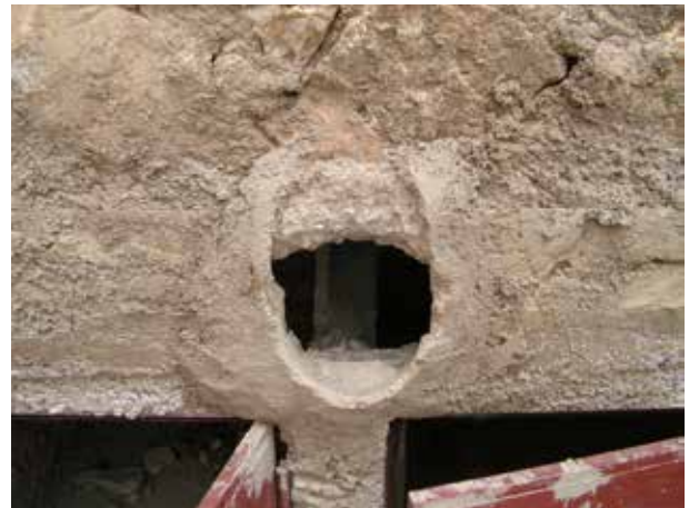
Image 337 : Un seul tuyau installé entre les deux fosses suffit pour garantir la ventilation.
