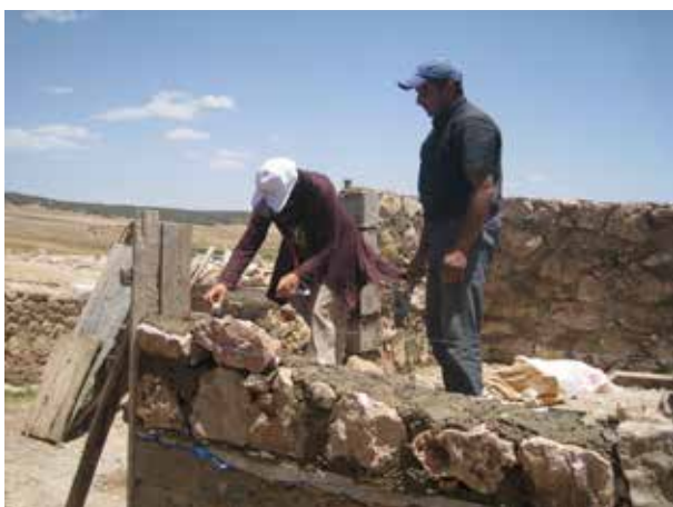
Image 647 : Les participants de l'atelier gagnent de l'expérience pratique sur les chantiers (TDSU Khaled).
