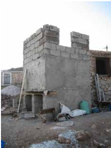
Image 264 : Niche pour la fenêtre dans les murs finalisés.
