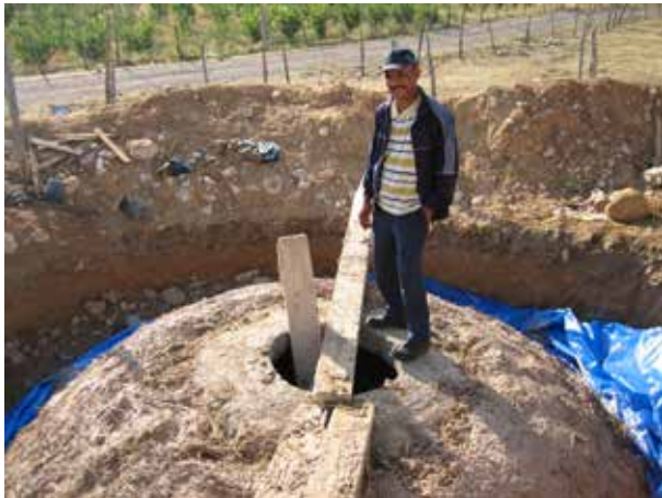
Image 450 : Une couche isolante d'argile et de paille est posée sur la surface extérieure du digesteur.
