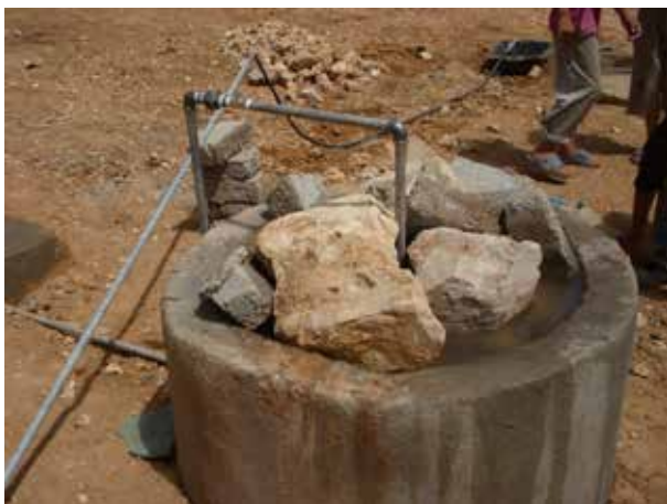
Image 475 : La conduite de gaz est branchée. Des moellons sont posés sur le couvercle et de l'eau est versée. De l'huile de vidange peut être versée sur l'eau pour réduire l'évaporation.
