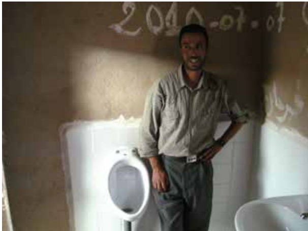
Image 108 : Les travaux d'installation à l'intérieur de la salle de bain sont conclus.
