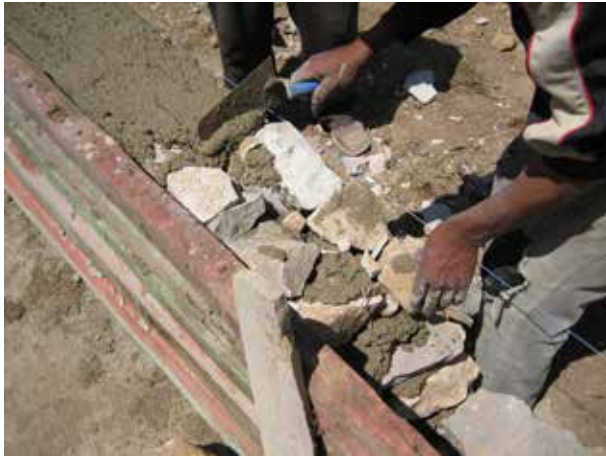
Image 206 : Murs en pierres naturelles sous construction.
