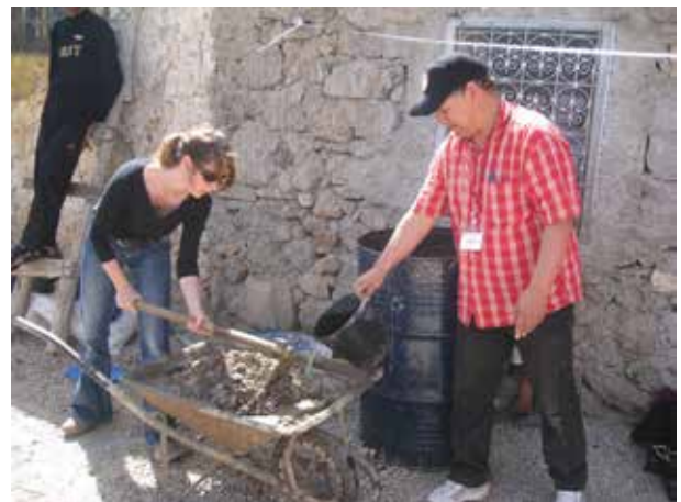
Image 640 : Les participants de l'atelier gagnent de l'expérience pratique sur les chantiers (TDSU Khaled).
