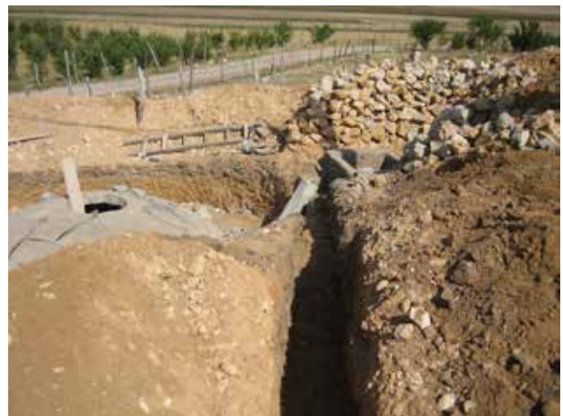
Image 432 : Tranchée pour la conduite des eaux usées de la maison.
