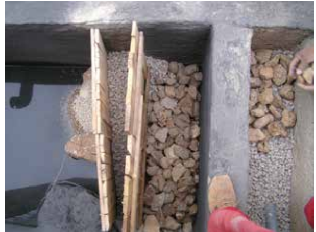
Image 126 : Avec des planches les 3 différentes tailles du grain sont séparées pendant le remplissage du filtre planté. A droite le compartiment pour les eaux de lavage anal.
