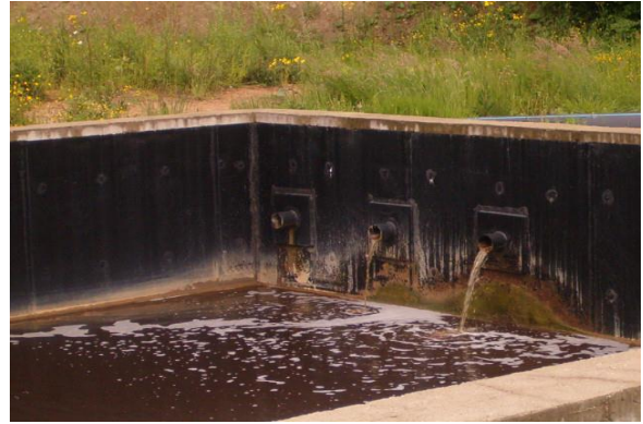
شكل ٣-٦ تجميع وتخزين الرشيع من مدفن صحي للقمامة بسرانيغو بالبوسنة والهرسك (صورة: F. Babić)
