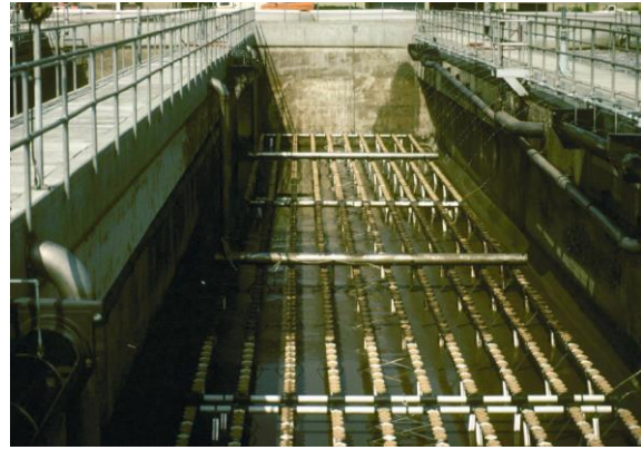
شكل ٩-٢١ حوض تهوية تم تجفيفه مجهز بقباب من السيراميك قبل (يساراً) وخلال (يميناً) التنظيف بواسطة استخدام الخراطيم من أعلى الحوض (Tank top Hosing). والناشرات الأقل تلوثاً، على اليمين تم تنظيفها فعلاً (Photo:M.K. Stenstrom)
