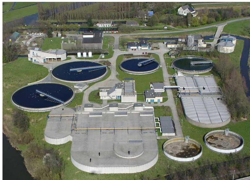
محطة معالجة مياه صرف صحي، كورتينورد في هولندا: خزانات الحمأة المنشطة مغطاة والهواء الذي يتم تجميعه يعالج (صورة):
