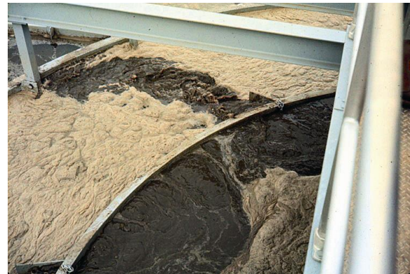
شكل ١٢-٨ الطفو (الخبث) على سطح المروقات (photo: Black and Veatch)
