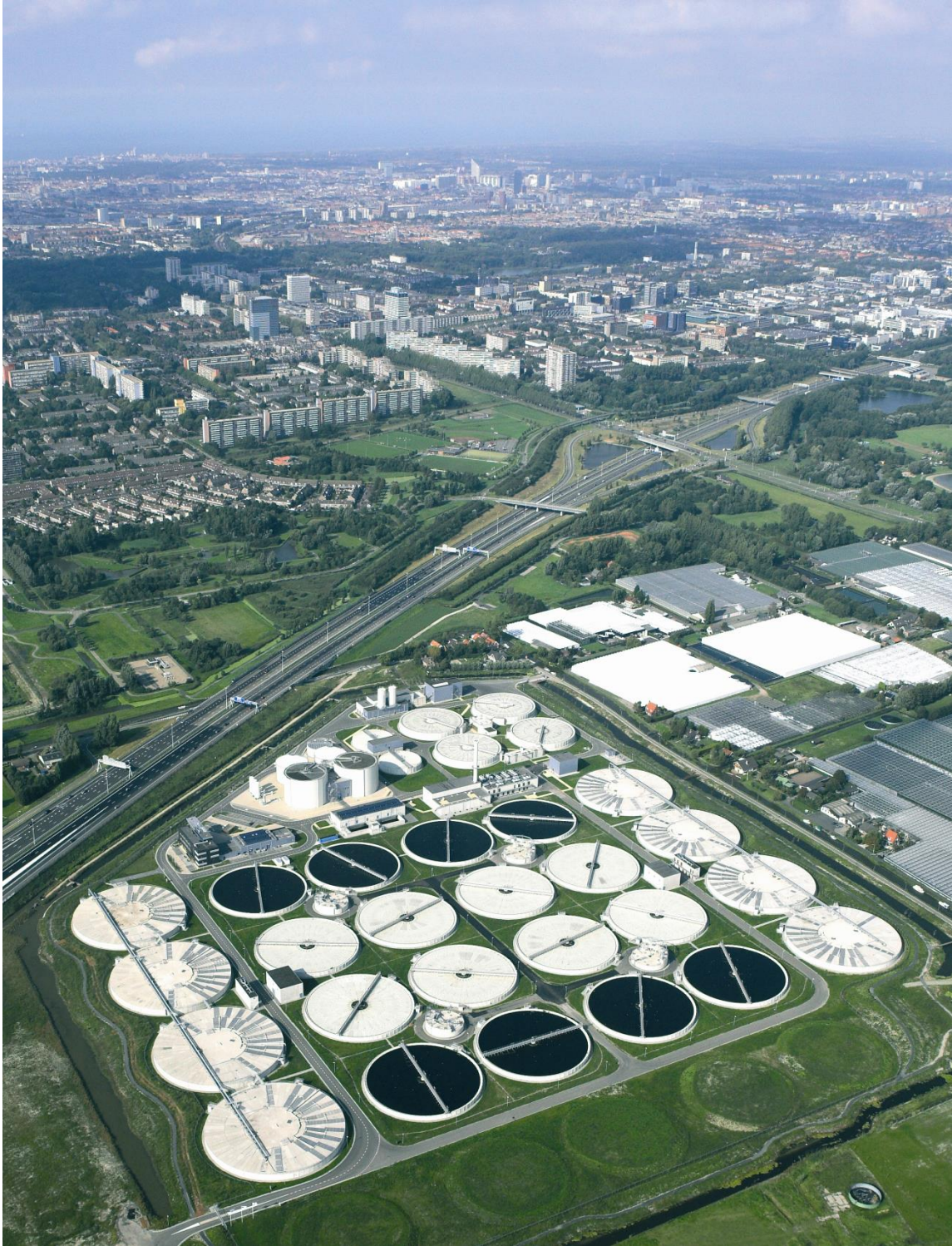
محطة معالجة مياه الصرف الصحي في "Harnaschpolder" محطة كبيرة (١,٣١ مليون مكافئ فرد) تقوم بجمع مياه الصرف الصحي من إقليم "Den Hague". وهي أول محطة في هولندا يتم تمويل إنشائها من خلال مشاركة القطاع العام والخاص (صورة: Aeroview-Rotterdam (.provided by courtesy of Delfluent B.V
