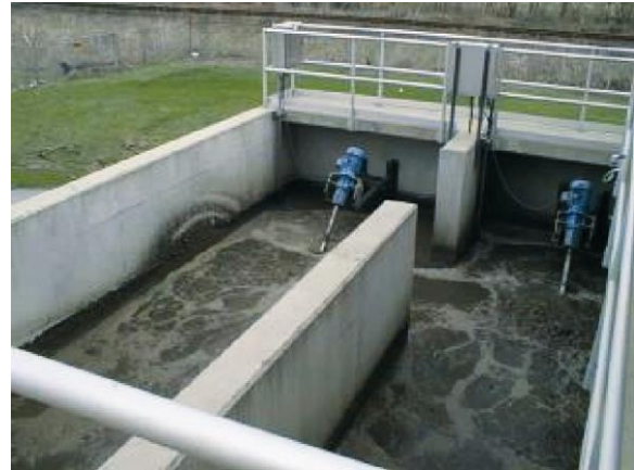
شكل ١١-٧ حوض انتقاء هوائي (photo: M.C.M. van Loosdrecht)
