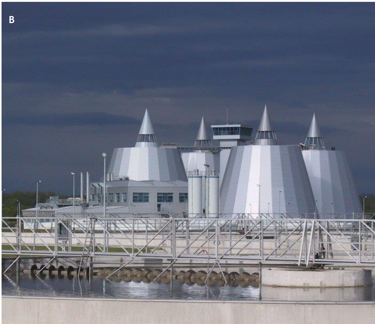
محطة معالجة مياه صرف صحي في زغرب (كرواتيا) مصممة لإزالة COD. وتم توفير إمكانيات التطوير والتوسع المستقبلي (أ). يحدث هضم الحمأة لاهوائياً في أربعة مفاعلات مصممة بشكل مستقبلي (صورة: Zagrebačke Otpadne Vode d.o.o.)
