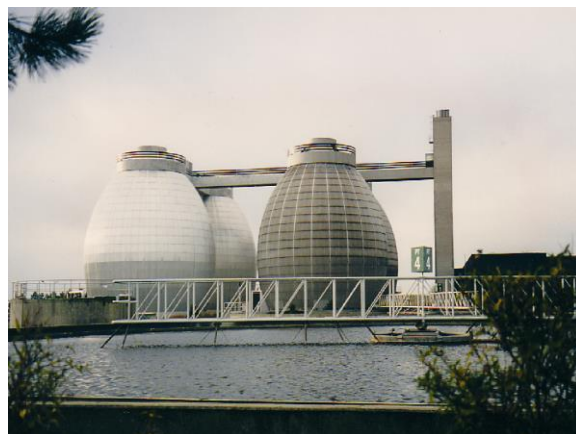
شكل ٣-٧ تنتج الهاضمات المادة الطافية للهاضم التي غالبًا ما تؤدي إلى زيادة مشاكل في محطات معالجة مياه لصراف الصحي بسبب الأحمال العالية للنيتروجين والمواد الأخرى (صورة: M. Henze)
