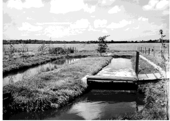
صورة رقم ١-٢ أول تطبيق (تجريبي) لنظام مصارف "Pasveer" (Voorschoten - هولندا) وكانت سعة المحطة ٤٠٠ مكافئ شخص و ٤٠ م ٣ / ساعة في تدفقات الجو الجاف (تصوير van Lohuizen, 2006)
