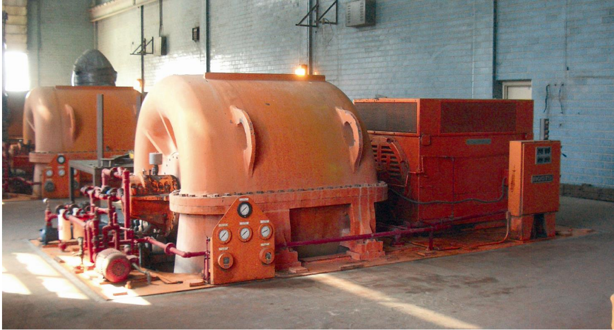
شكل ٩-١٣ نافخ طارد مركزي متعدد المراحل بريشات توجيه متغير في حالة تشغيل في محطة مياه صرف صحي كبيرة، وتظهر الأبعاد الكبيرة للنافخ، وهي التي تسحب ٣٥٠٠ ك. واط و ٤١٦٠ فولت أمبير تيار وناتج حوالي ٢٦ نيوتن متر مكعب/ ثانية (١٦٠٠ نيوتن متر مكعب/ دقيقة) في أمثل وضع تشغيل ( photos: D. Rosso)
