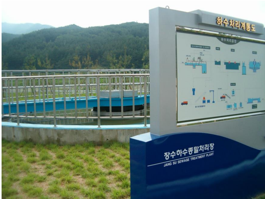
محطة معالجة مياه الصرف الصحي في جانج سو Jang Su في كوريا بأحدث التقنيات في الأجهزة الدقيقة وأوتوماتيكية عملية التحكم ( photo: ) (K-water)
