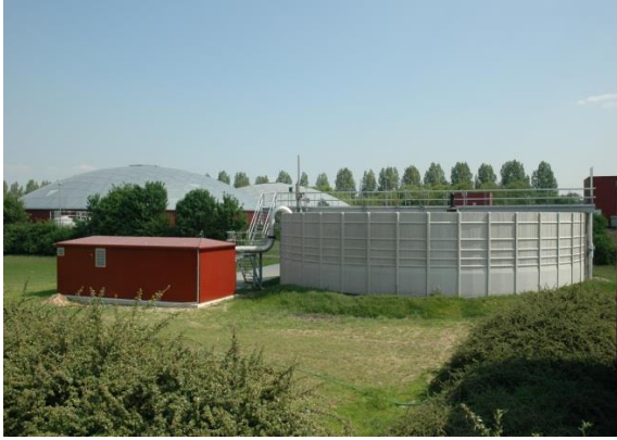
شكل رقم ٦-١٢ تطبيق كامل النطاق لتقنية BABE®: محطة Hertogenbosch لمعالجة مياه الصرف الصحي في هولندا (من الأمام: مفاعل الإضافة الحيوية؛ صورة: DHV B.V.)
