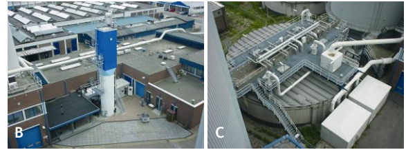
شكل رقم ٦-٩ (أ) منظر جوي لمنشآت معالجة الحمأة في محطة Dokhaven لمعالجة مياه الصرف الصحي و(ب) منظر لمفاعل الأناموكس (ج) مفاعل SHARON® من قمة هاضم الحمأة (صورة: Water Board Hollandse Delta)
