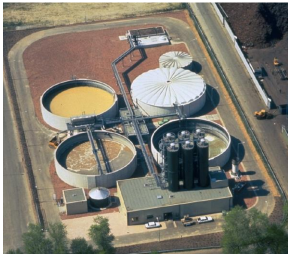
شكل ١٦-٢١ منشأة EGSB لمعالجة مياه صرف من مصنع ألبان في ألمانيا (أ) ومنشأة لمعالجة مياه صرف من مصنع بيرة في "دين بوش" في هولندا (ب). الصور بواسطة بيوتان بي في وياكوبس بي في على التوالي.
