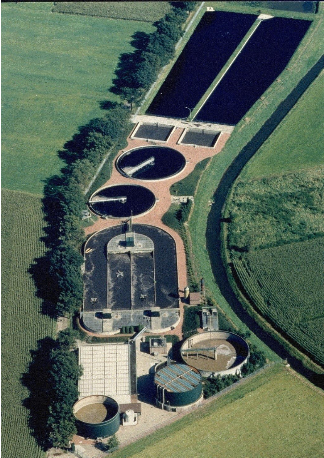
تطبيق مفاعل غطاء حمأة لاهوائي على نطاق كامل : محطة معالجة صرف صناعي من مصنع للبيرة في بافاريا ، ليسوث ، هولندا. ومفاعل غطاء الحمأة اللاهوائي موضوع في مقدمة العرض (photo: J.B. van Lier by courtesy of Bavaria N.V.).
