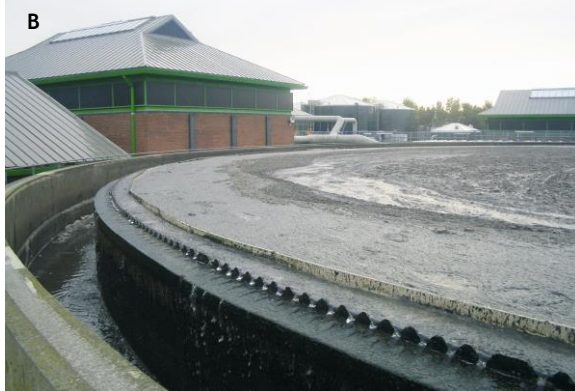
شكل ١١-٣ كابوس مشغلي محطة معالجة مياه الصرف الصحي (أ) الحمأة الخيطية (ب) الحمأة المنتفخة، خارجة من المحطة مع المياه الخارجة (photos: D.H. Eikelboom and D. Brdjanovic)
