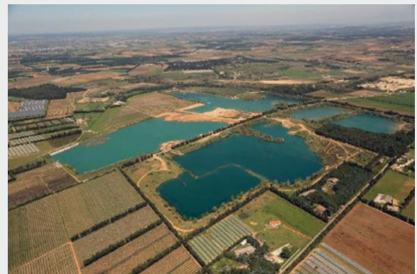
Figure | Les carrières de LafargeHolcim dans la commune de Bellegarde, au sud de la France, converties en retenues d'eaux pluviales
