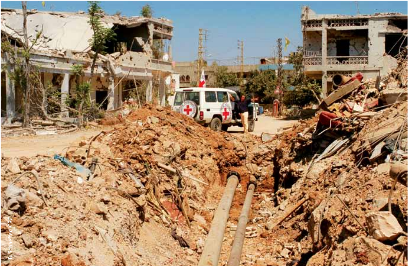
الصورة 3: التأثير المباشر وغير المباشر يبدأ بالتراكم. من الممكن إصلاح هذه الأنابيب ولكن إذا بقي ضغط المياه غير كافٍ فمن المرجح أن يقوم السكان المحليون بتركيب مضخات شفط-آلية مواجهة «سلبية» تضع صحة العديد من الأشخاص في خطر. (جنوب لبنان، 2006)
