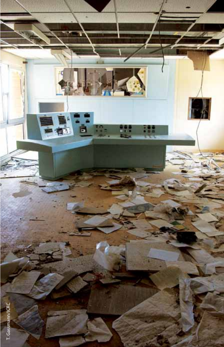
الصورة 2: غرفة عمليات منهوبة ومهجورة في محطة معالجة مياه، تعرض توصيل المياه للخطر لعشرات الآلاف من السكان (بغداد 2003)
