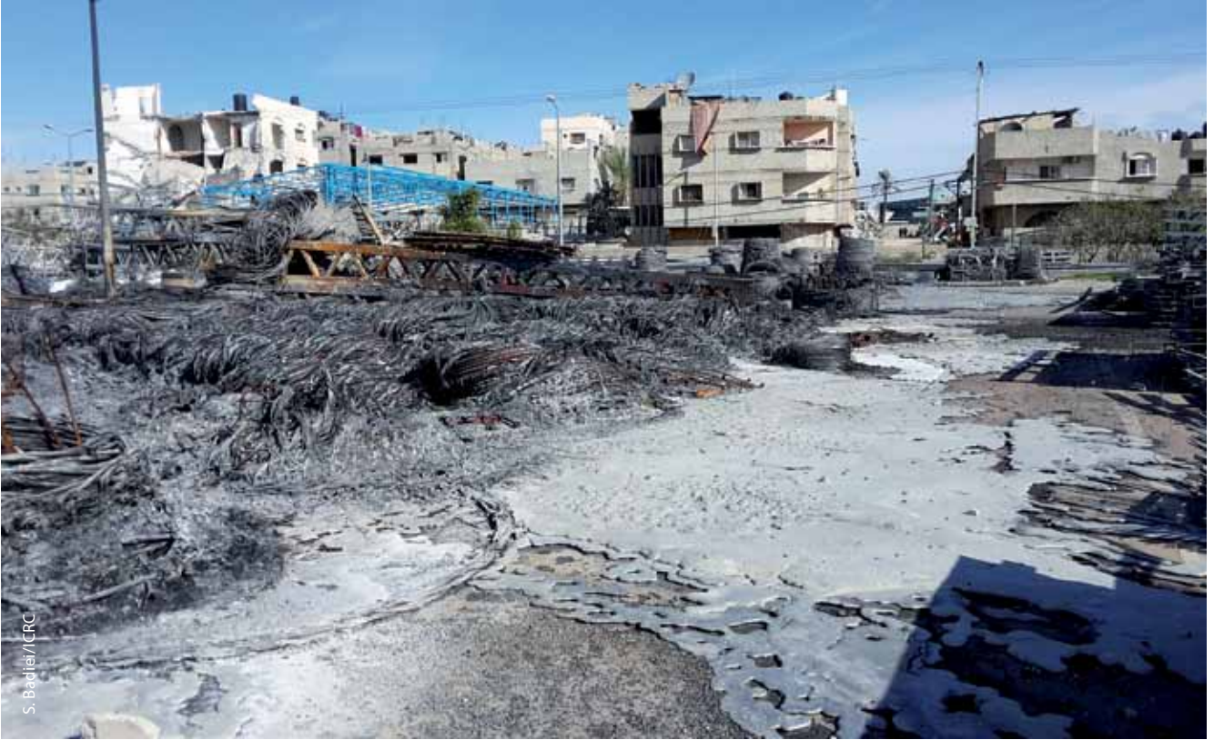
الصورة 5: أسلاك وأعمدة منصهرة نتيجة الدمار في عام 2014 لمستودع لشركة كهربائية في غزة، الذي فقد قدرته على مقاومة الأعطال. وتوجب القيام بالإصلاحات اللازمة لشبكة الكهرباء بتفكيك مواد مثل المحولات والأسلاك والأعمدة في أماكن أقل أهمية ووضعها في أماكن أكثر أهمية (مثلاً: مستشفى). (غزة 2014).
