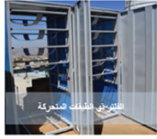
الشكل رقم (٩): مكونات نظام الفلتر الرملي ذو الطبقات المتحركة
