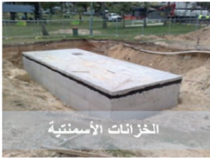
الشكل رقم (٢): أمثلة على أنواع وأشكال الخزانات التجميعية لمياه الأمطار
