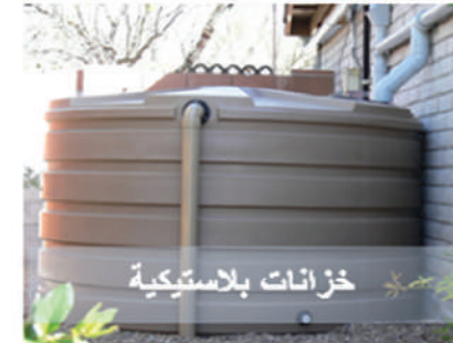
الشكل رقم (٢): أمثلة على أنواع وأشكال الخزانات التجميعية لمياه الأمطار
