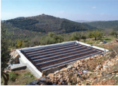
الشكل رقم (V): نظام الأحواض الرطبة الصناعية
