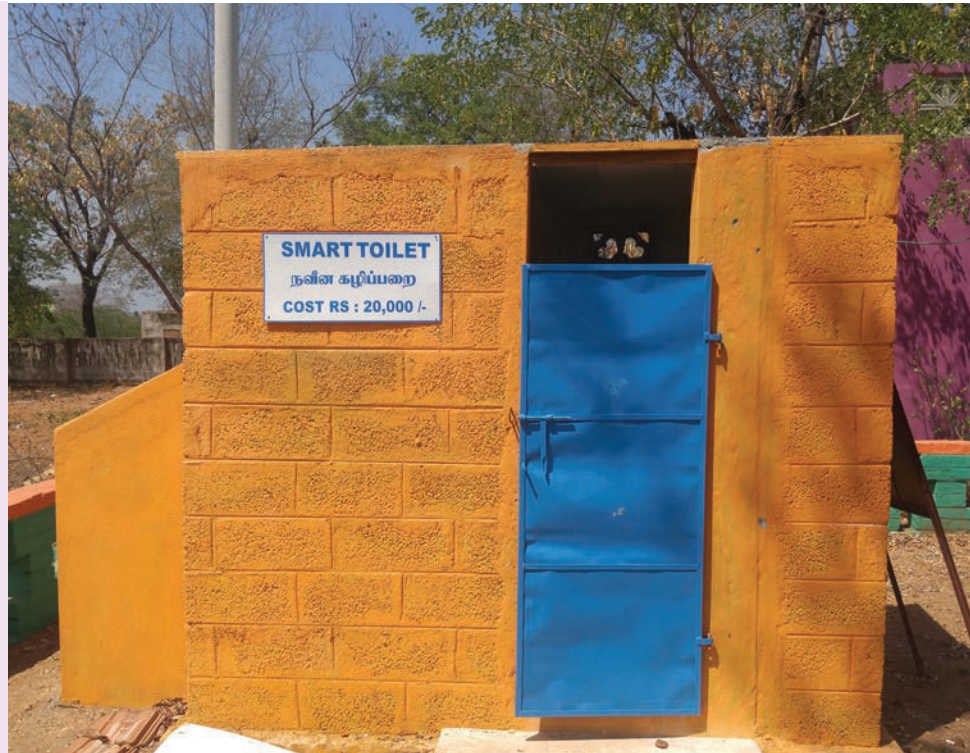
Les toilettes SMART se composent de latrines à double fosse avec une zone salle de bain pour se laver.
