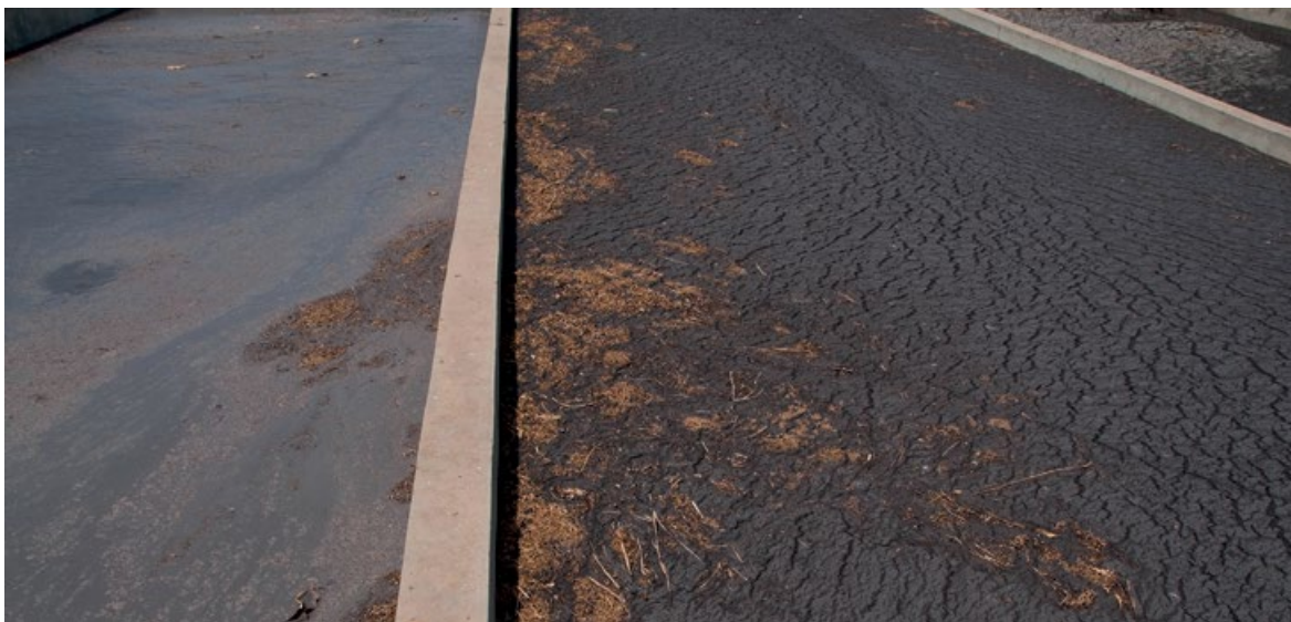
Figura 7.2 Dos lechos de secado sin plantas, uno recién cargado (izq.) y otro parcialmente secado, en la Estación de Tratamiento de Lodos Fecales Niayes, en Dakar, Senegal (foto: Linda Strande).
