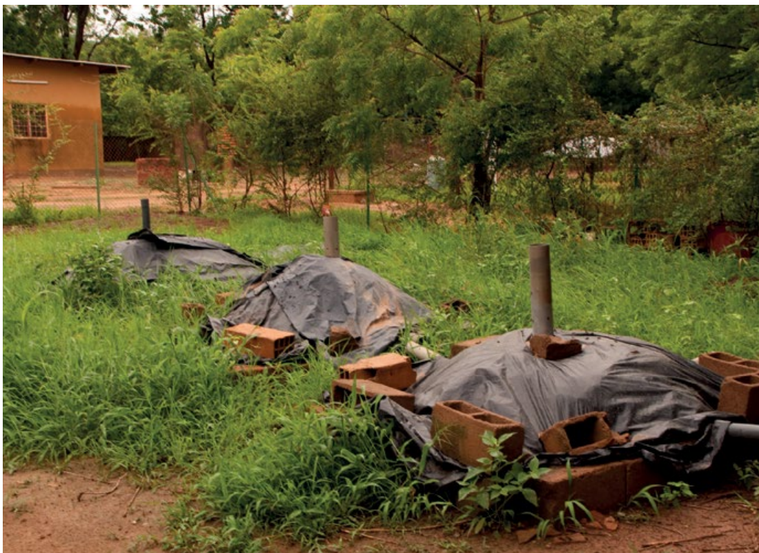
Figura 3.9 Reactores de biogás en 2iE de Uagadugú, Burkina Faso (foto: Linda Strande).
