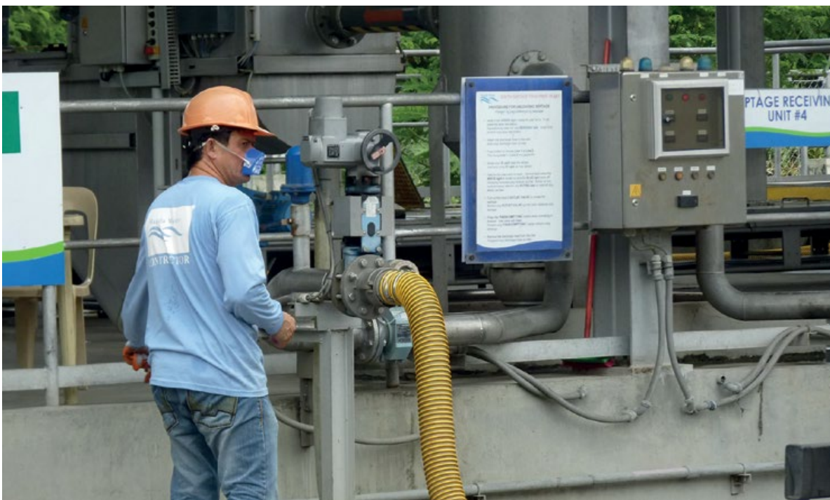
Figura 4.16 Puesto automatizado para la recepción de lodos fecales en la Estación Sur de Tratamiento de Lodos de Tanques Sépticos, operado por el Departamento de Agua de Manila, Filipinas (foto: WSUP, Sam Parker).
