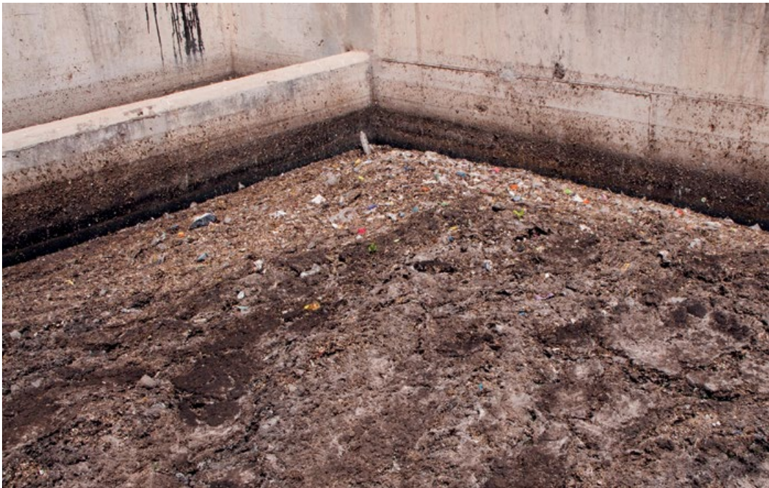
Figura 3.2 Tanque de sedimentación en la Estación de Tratamiento de Lodos Fecales Niayes, en Dakar, Senegal (foto: Linda Strande).
