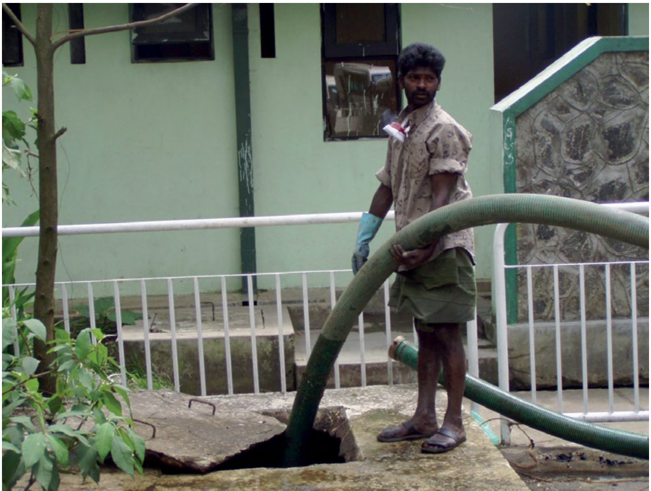
Figura 4.1 Vaciado de los lodos fecales de un tanque séptico con un equipo aspirador. La seguridad ocupacional podría mejorarse con la provisión y uso adecuado de los equipos de protección personal. (foto: David M. Robbins).
