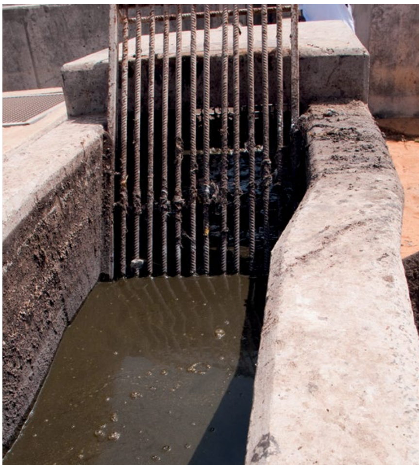
Figura 3.6 Tamiz de barras en la Estación de Tratamiento de Lodos Fecales Niayes, en Dakar, Senegal (foto: Linda Strande).
