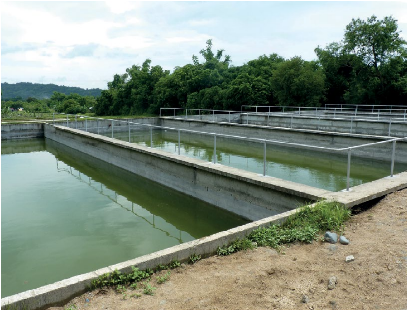
Figura 11.8 Puesta en marcha de un sistema de lagunas para lodos fecales en San Fernando, Filipinas. En este caso, las lagunas fueron inoculadas con lodos activados de una estación de tratamiento cercana. (Foto: David M. Robbins).
