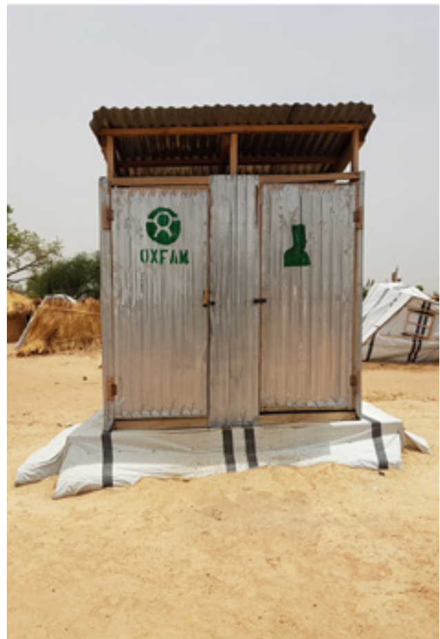
Des latrines dans le camp d'Aburi au Nigeria. Photo : Marion O'Reilly/Oxfam
