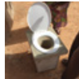
Siège en briques avec chape en ciment 26
