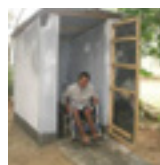
Latrine avec entrée plane en ciment, assez large pour accommoder un fauteuil 10
