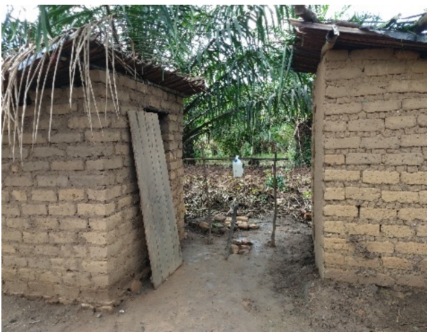
Deux superstructures de latrine Akasuga face à face
