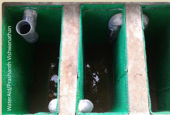
Figura 7: As três câmaras da latrina biológica
