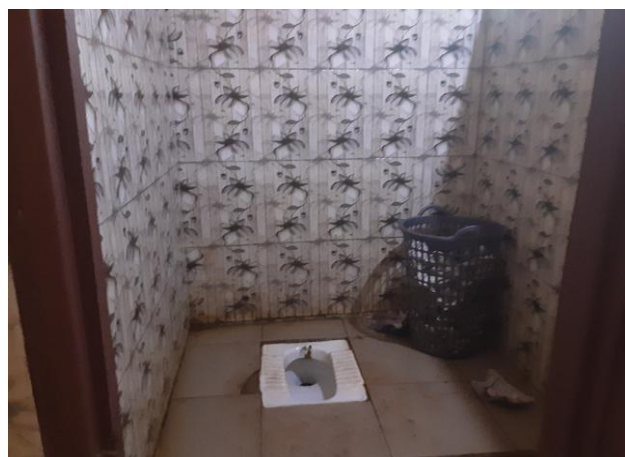
Figure 41: Clean pour flush at a public toilet
