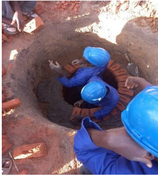
2. Lining the walls (substructure)
