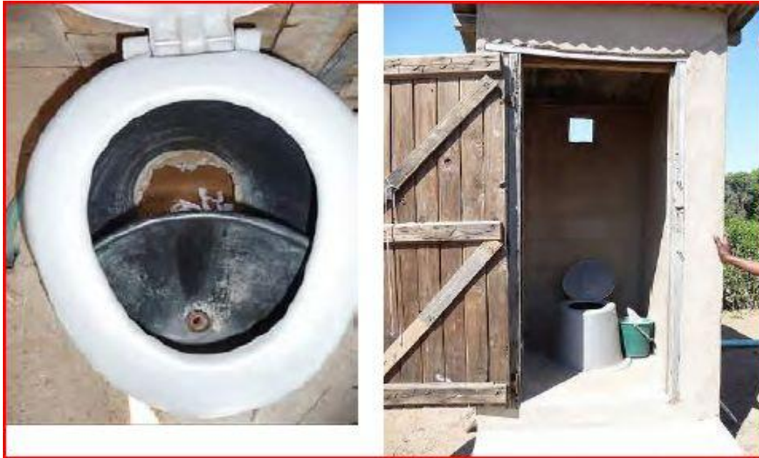
Figure 20 : UDDT dans un ménage à l'Ouest de Hanahai (Botswana)
