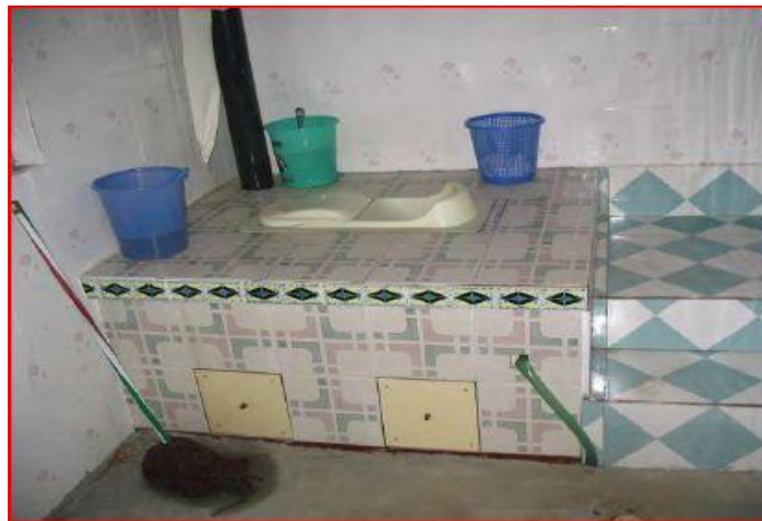
Figure 25 : UDDT dans un ménage à Shaanxi (Chine)
