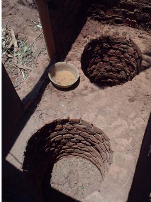
Twin pits in a Fossa alterna . Thyolo.
