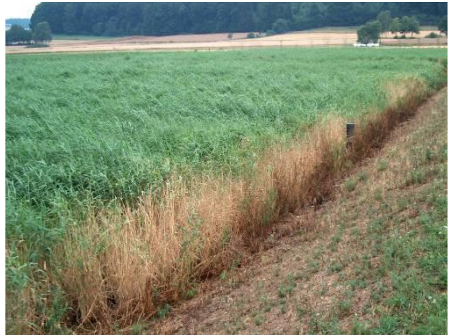
人工湿地处理系统 Constructed wetland
