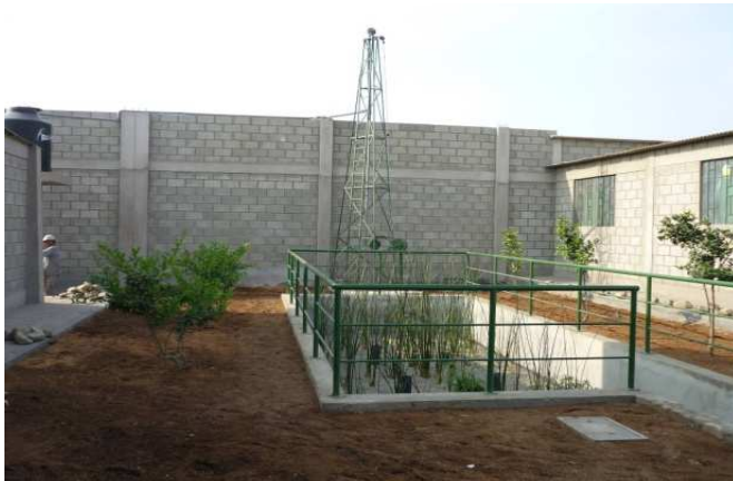
Fig. 7: En primer plano el humedal, en la parte posterior la bomba de mecate y a la izquierda el tanque elevado (R. Miglio, 2009).
