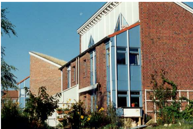
Fig 5: Häuser mit begrüntem Dach im nördlichen Innenhof, erbaut 1990/91 (Quelle: Berger Biotechnik).
