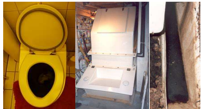
Abb. 6: Berger Terra Nova Komposttoiletten-System mit Toilette (links) und Kompostbehälter (Mitte). Trennkammer für Sickerwasser im Entnahmebereich (rechts). Fotos: A. Schöpe, 2009 (links) und Berger Biotechnik.
