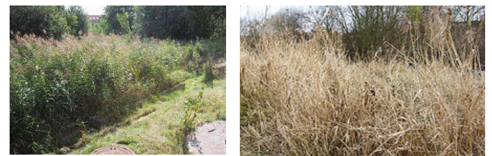
Abb. 7: Pflanzenkläranlage mit Schilf im Sommer (links) und Winter (rechts). Fotos: Ökologisches Leben Allermöhe e.V. (links) und A. Schöpe, 2009 (rechts).
