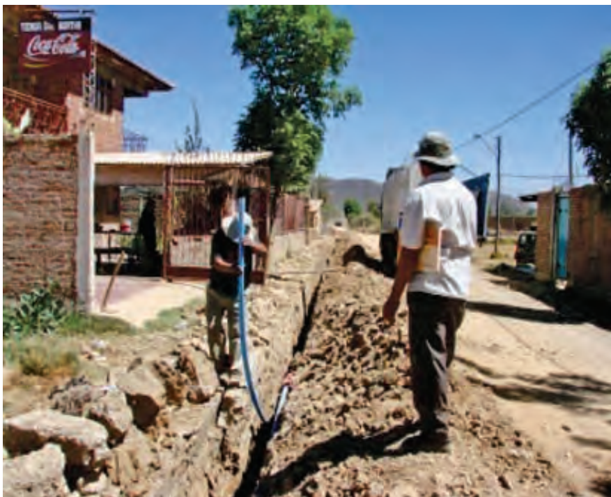
Foto 2.4 Tendido de tubería la Maica - C. Cochabamba
