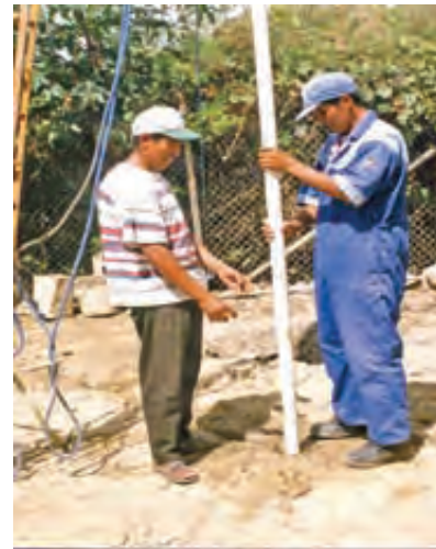
Foto 1.4. Encamizado del pozo
