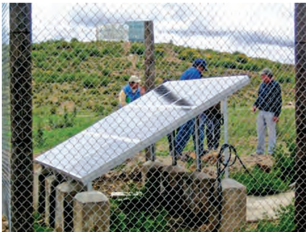
Foto 1.1 Socamani – Oruro incluye tanque de ferrocemento Proyecto JICA
