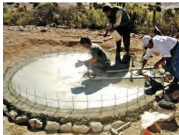
Foto 1.2 Concluida la losa de fondo
