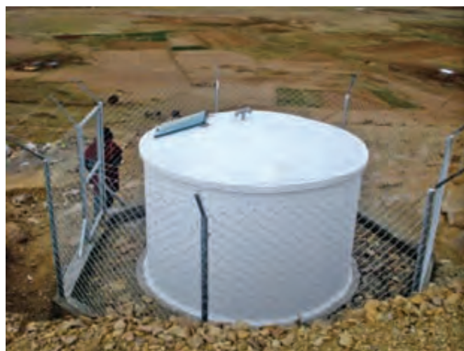
Foto1.8. Acabado con cerco perimetral
