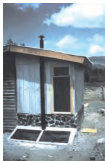
Fig. 2.10 Baño con panel solar domiciliario
