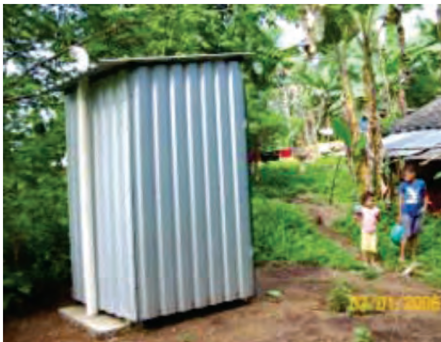
Foto 1.1 Baño de hoyo seco ventilado con desvío de orina Rep. El Salvador
