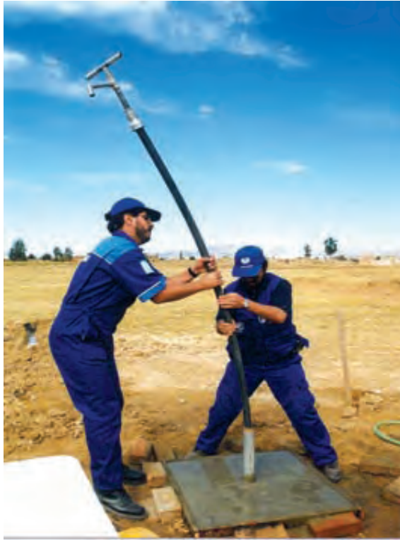
Foto 1.1 Colocación de la bomba
