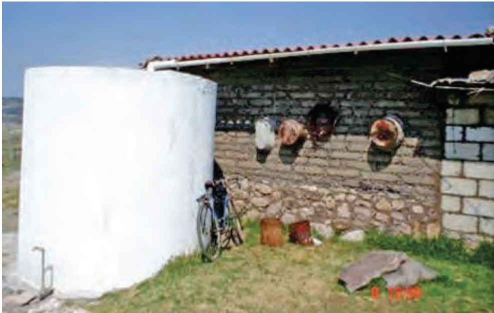
Foto 1.3 Tanque sobre el piso
