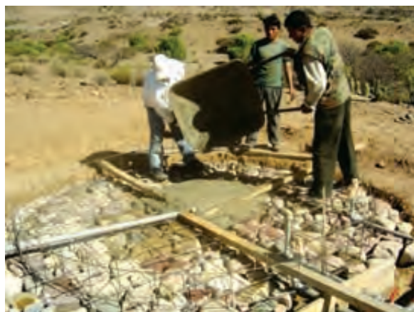
Foto1.1 Vaciado de losa de fondo
