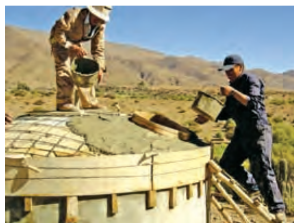
Foto 1.6. Vaciado de tapa
