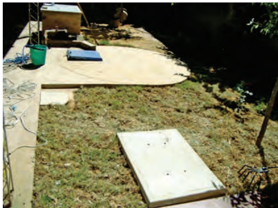
Foto 1.2 Tanque enterrado Localidad: Ciudad de Cochabamba
