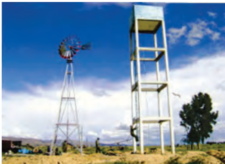
Foto 1.1 Aerobomba impulsada a tanque elevado Localidad: Taraco - La Paz
