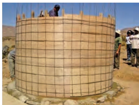
Foto 1.4. Encofrado interior
