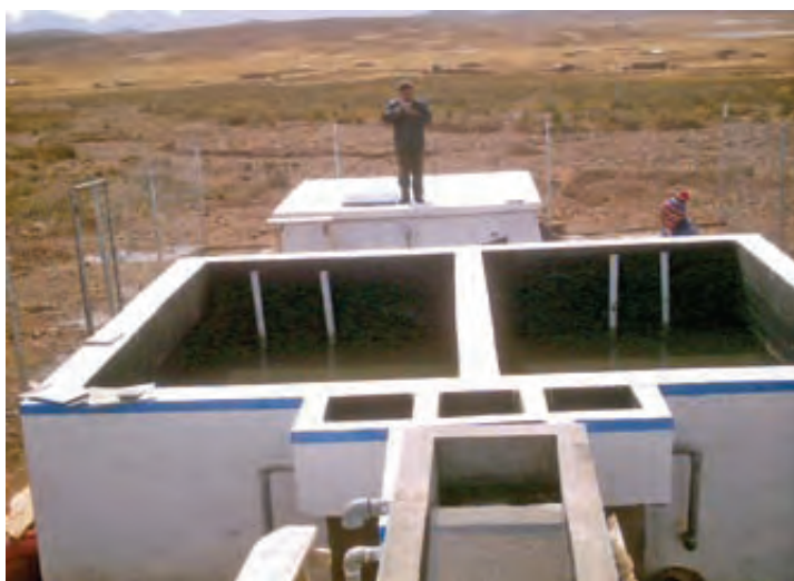
Foto 3. 5. Filtro grueso dinámico y FLA, Loc. Masaya
