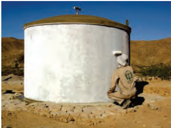
Foto 1.7. Acabado exterior una vez finalizada la prueba de estanqueidad
