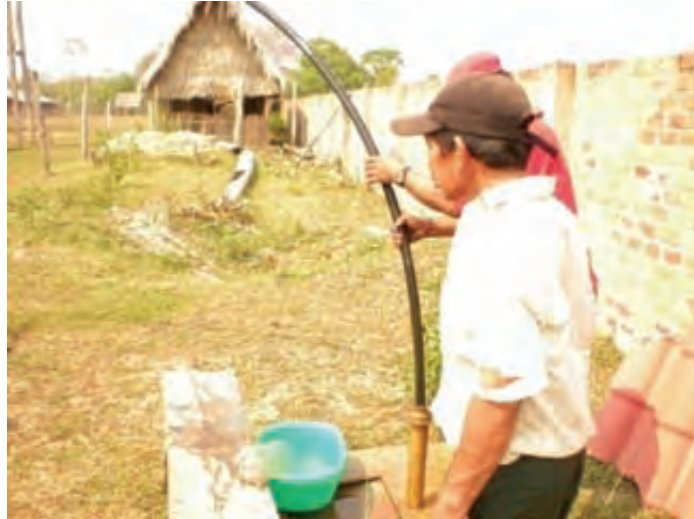
Foto1.6 Pozo perforado manualmente, Localidad Gualaguagua – Municipio Reyes
