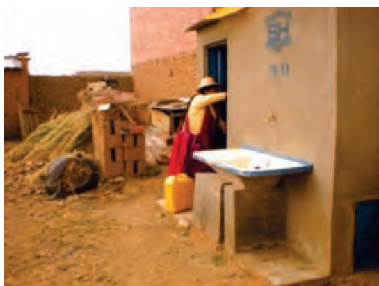
Foto 1.3. Baño e. Distrito 7 El Alto
