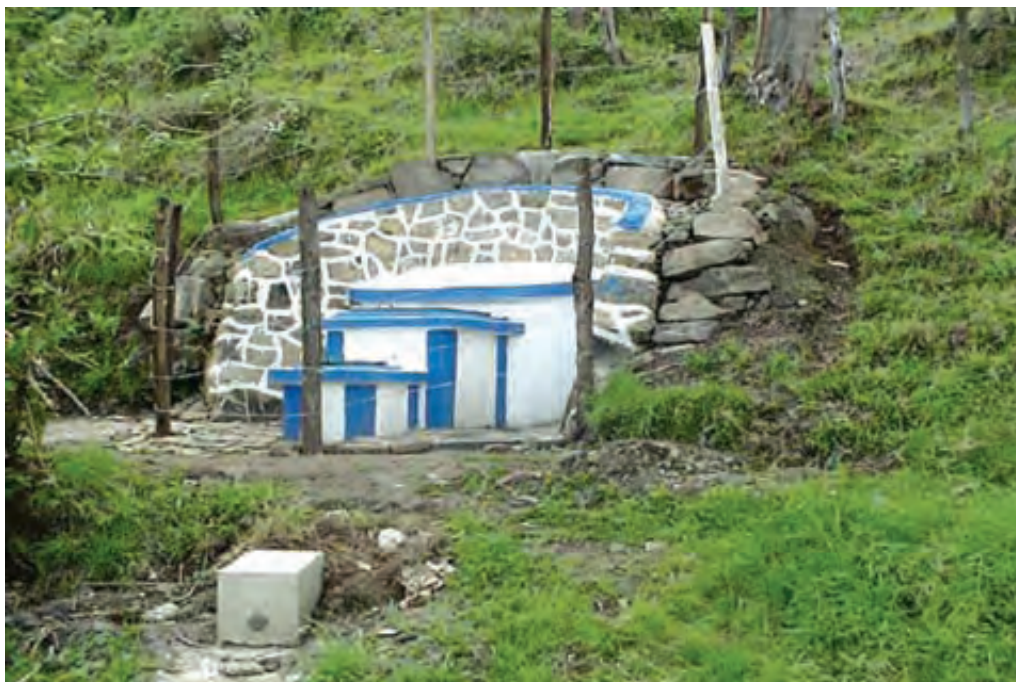
Foto1.1 Captación de ladera y primer cerco
