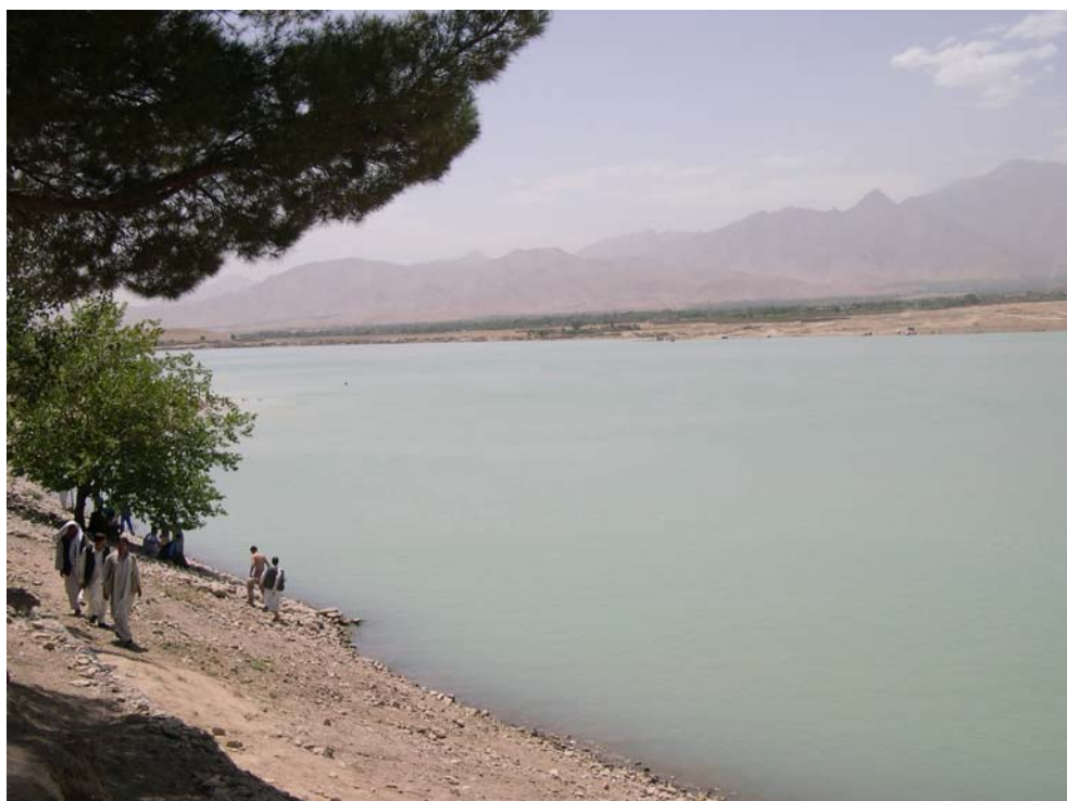
Figure 19 : Retenue d'eau en amont du Kaboul (T.Krekeler)
