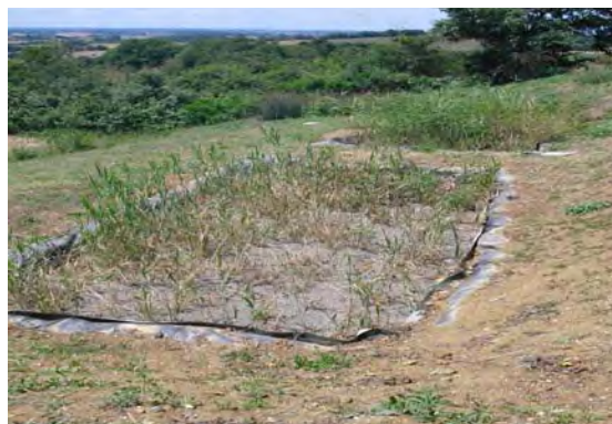
Premier niveau de traitement aérobic planté de roseaux. Étanchéité du bassin réalisée avec une géomembrane EPDM.
