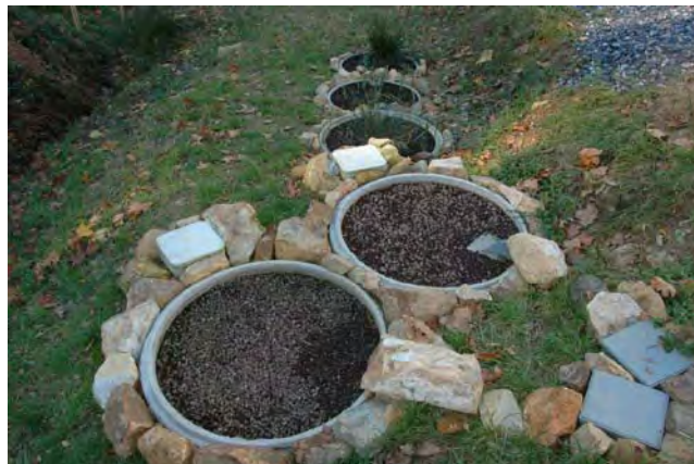
Cinq filtres plantés d'un mètre de diamètre et d'une profondeur de 50 cm. Le premier niveau fonctionne en alternance et par bâchée.
