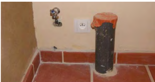
Arrivée d'eau, prise électrique et évacuation des urines à prévoir pour installer un Separett villa 9000.
