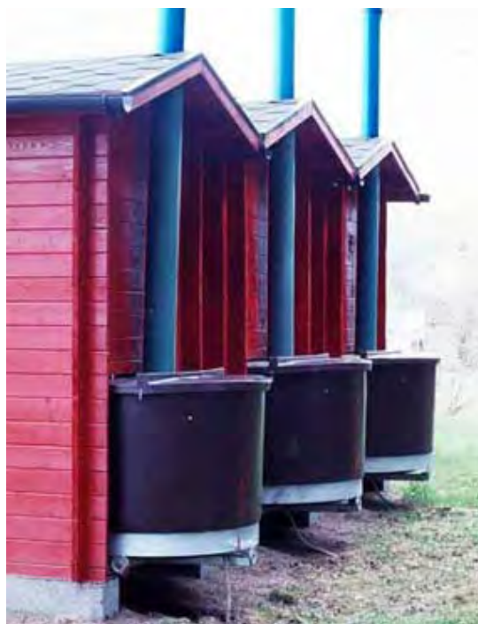
Composteurs extérieurs et ventilation passive
