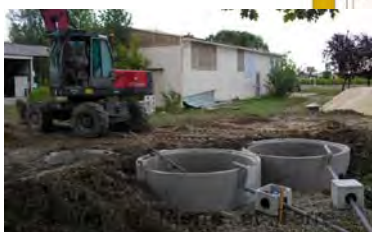
Premier niveau de traitement vertical aérobie posé sur le sol existant
