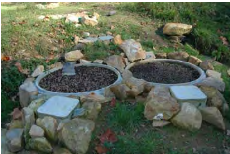
Premier niveau de traitement vertical aérobie fonctionnant en alternance et par bâchée
