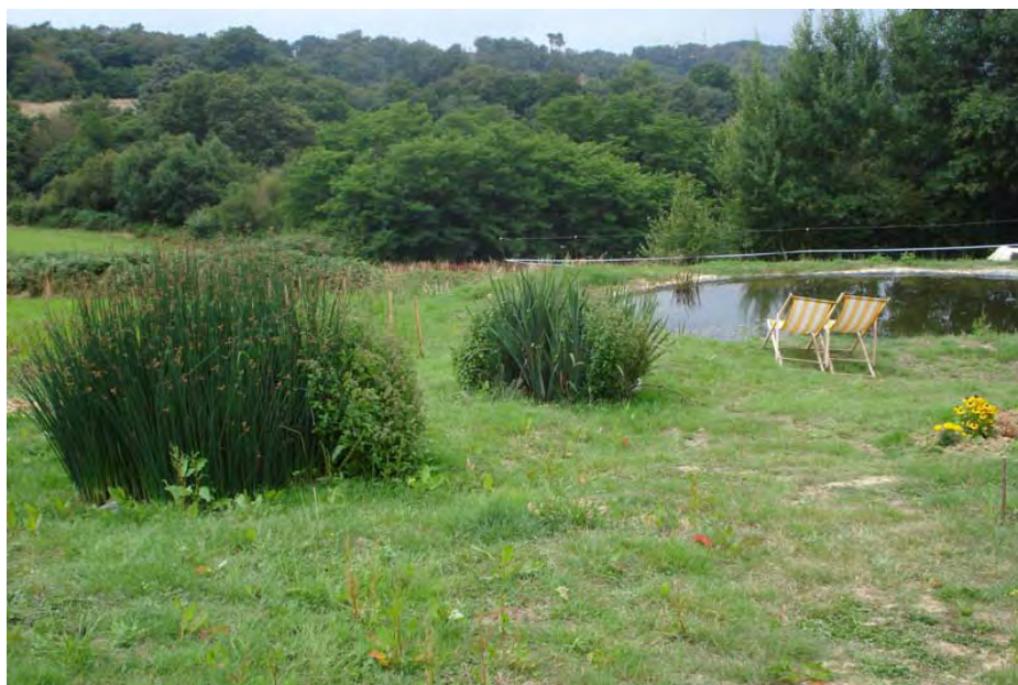
2 bassins à traitement horizontal et mare terminale
