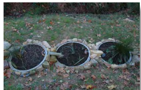
2ème, 3ème, 4ème niveau de traitement horizontal en anaérobie
