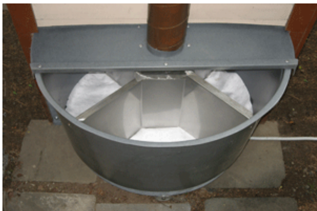
Compartiments du compost et ventilation
