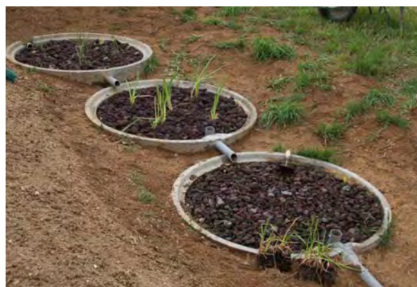
Bassins à traitement horizontal en cours de plantation
