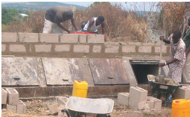
Latrines Tecpan en construction au Congo
