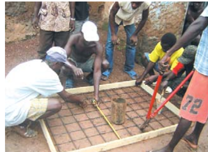
Ferrailage et coffrage de dalles en Guinée Bissau
