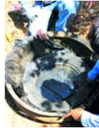
4. Poser le morceau du pneu coupé sur le plastique au fond du pneu.
