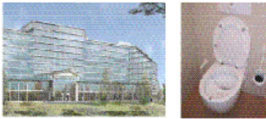
Allemagne : Toilettes à micro-chasse pour les fèces et séparation des urines au siège de la GTZ
