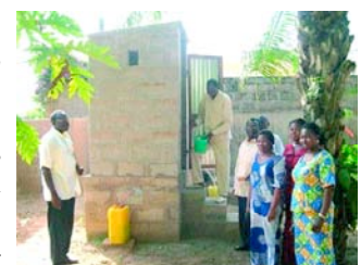
La latrine ECOSAN du CREPA-Togo
