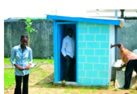
La latrine ECOSAN
