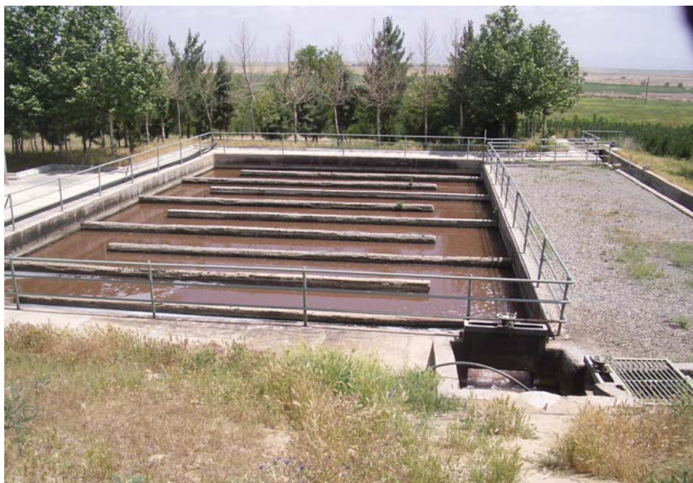
Bild 20: Kläranlage Mashhad West: Chlorierungsbecken
