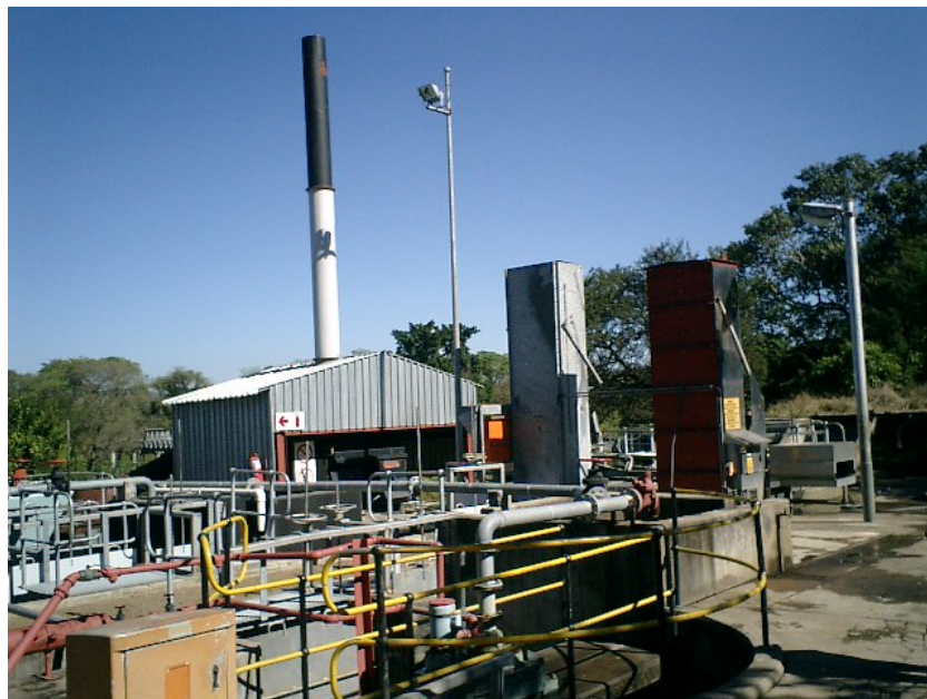
Bild 17: Verbrennungsanlage für Rechengut und feste Abfälle aus dem Klärwerksbetrieb einer mittelgroßen Anlage
