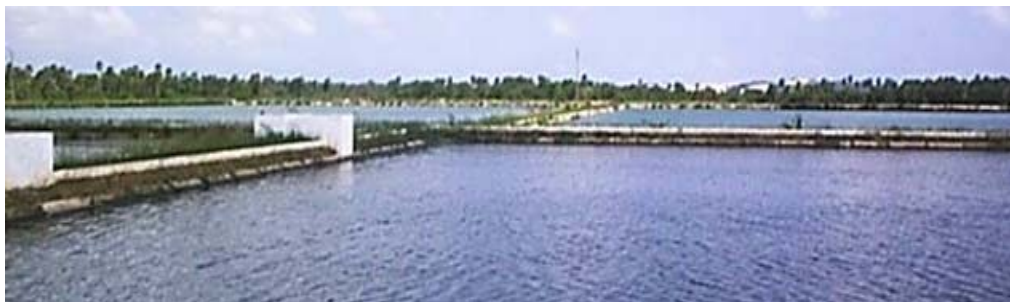
Bild 12: Abwasserteichanlage in Aquiráz, Ceará (CPA)
