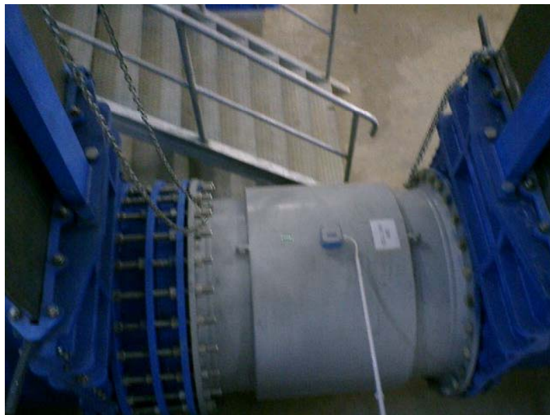
Bild 13: Induktive Ablaufmengenmessung Klärwerk Butowo. Weil es sich um ein Betreibermodell handelt, musste man von Anfang an auf verlässliches Monitoring aller wesentlichen Parameter und vertragssichere Dokumentation aller Messwerte geachtet werden. Davon profitiert die Qualität des technischen Betriebes.
