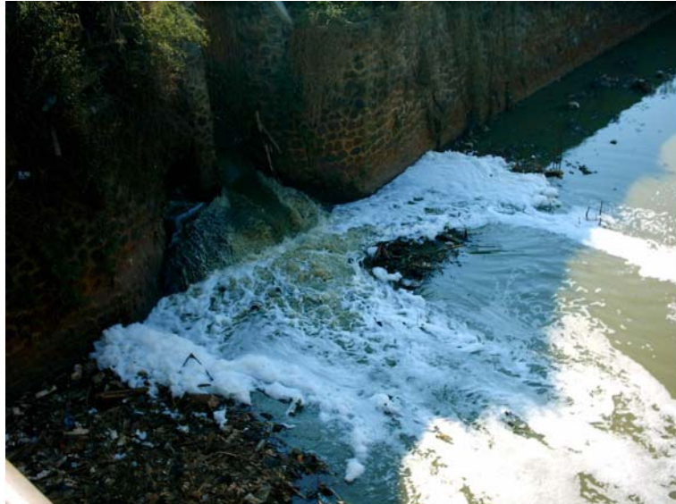
Bild 4: Abwassereinleitungsstelle aus dem Kanalnetz der Stadt Bandung
