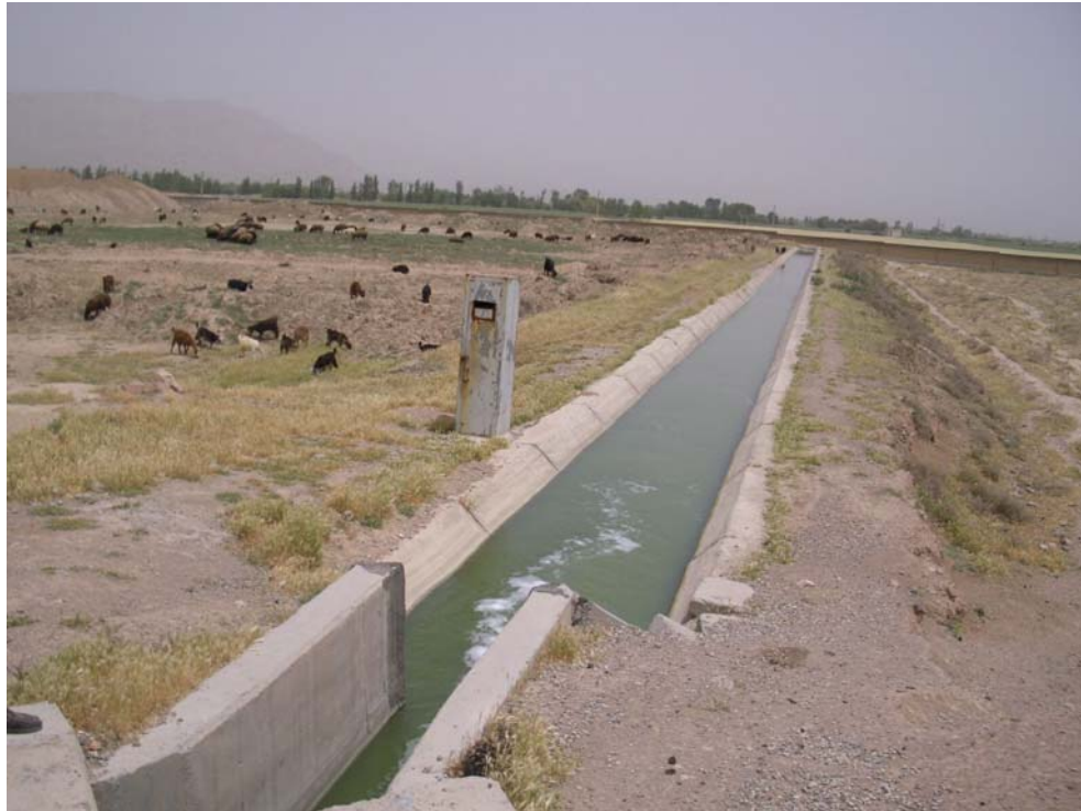
Bild 15: Kläranlage Tehran South: Ablauf
