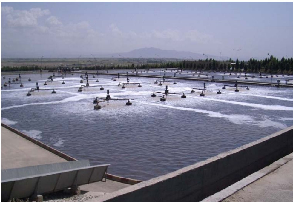
Bild 18: Kläranlage Mashhad West: Belüftete Teiche
