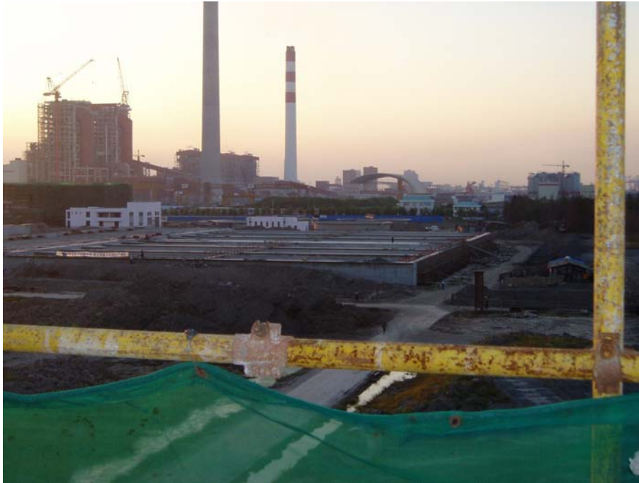
Bild 10: Abwasserbehandlungsanlage Shanghai Zhuyuan (ausschließlich mechanische Reinigung)
