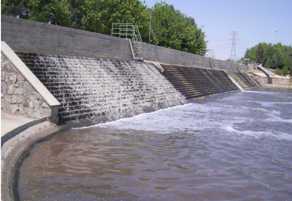
Bild 17: Kläranlage Mashhad West: Belüftungstreppe
