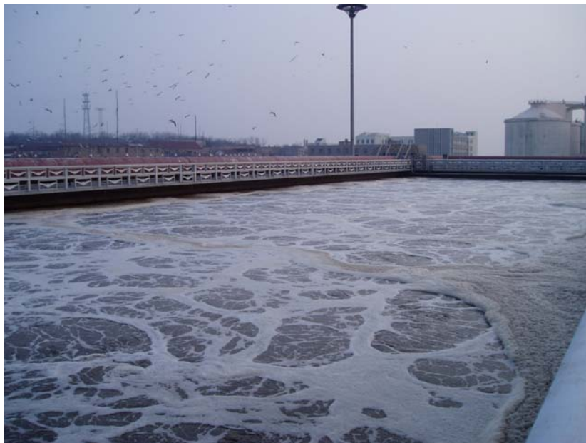
Bild 5: Abwasserbehandlungsanlage Qingdao (konventionelles Belebungsverfahren mit N- und P-Elimination, sogenanntes A 2 O-Verfahren)
