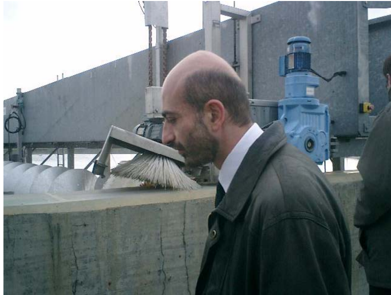
Bild 12: Blick auf die Räumlerlaufbahn eines Nachklärbeckens vom Klärwerk Butowo. Für den Winterbetrieb hatte man mit Heißluftgebläsen gearbeitet, die aber wegen technischer Probleme (Wiedervereisung, Aufbau einer immer dickeren Eisschicht) wieder demontiert wurden. Stattdessen ist eine elektrische Laufbahn-Reinigungsbürste installiert mit Möglichkeiten, Frostschutzmittel vor die Laufräder zu sprühen.
