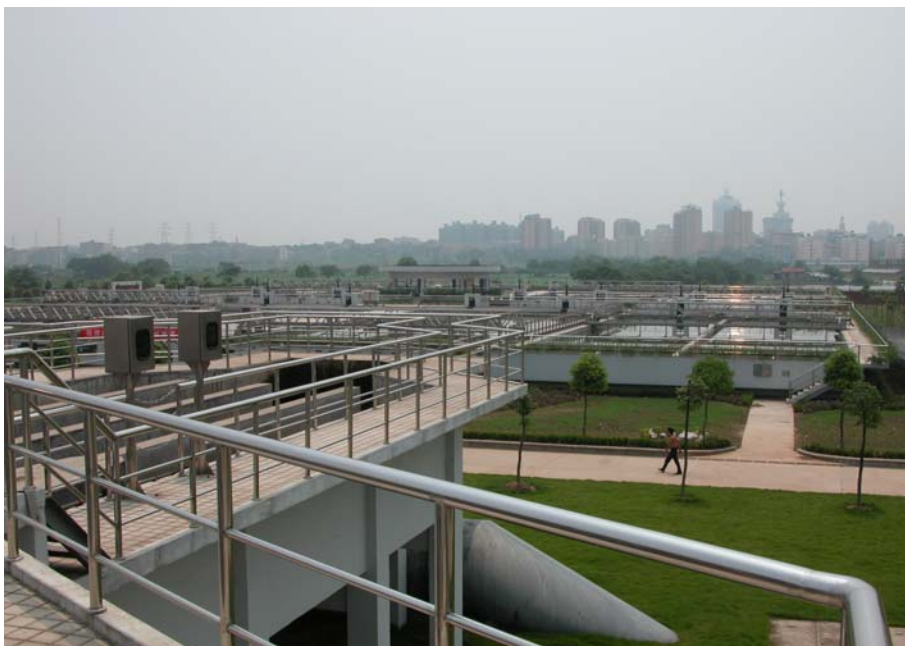
Bild 9: Abwasserbehandlungsanlage Wuhan (ausschließlich mechanische Reinigung)
