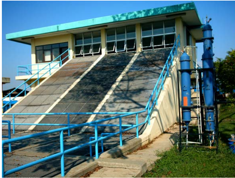
Bild 8: Hebewerk der Großkläranlage BojongSoang in Bandung
