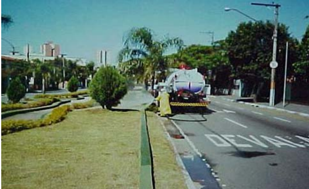
Bild 3: Bewässerung von Grünflächen mit behandeltem Abwasser in RMSP
