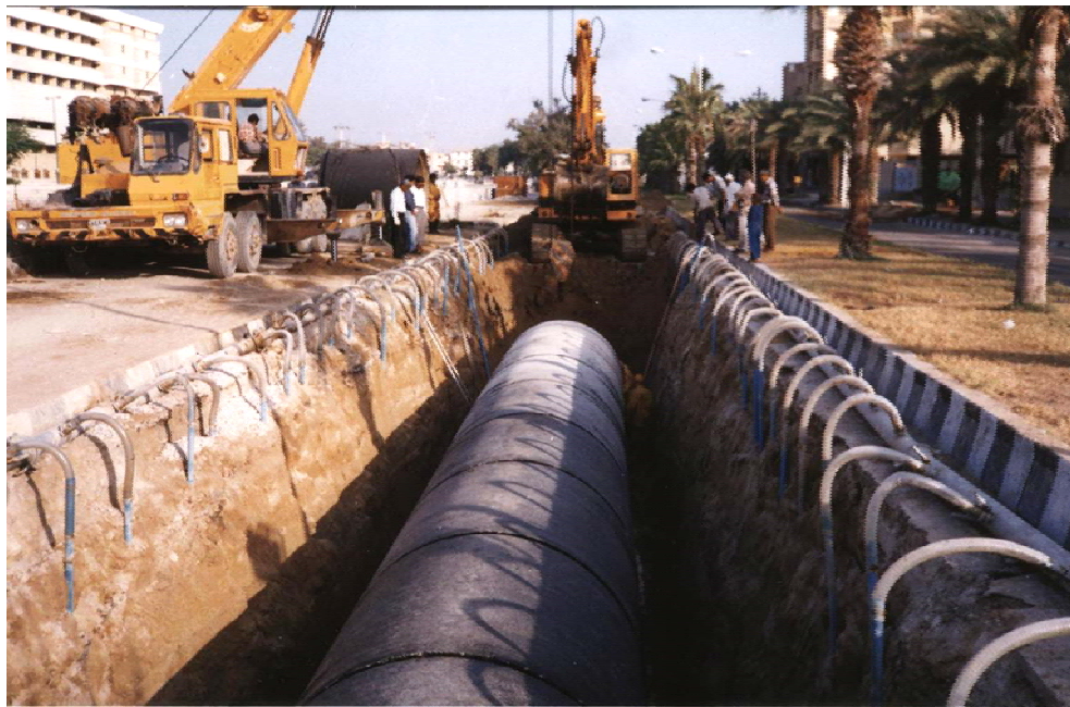
Bild 7: Offene Grabenverlegung (Mahmoudian, 2004)
