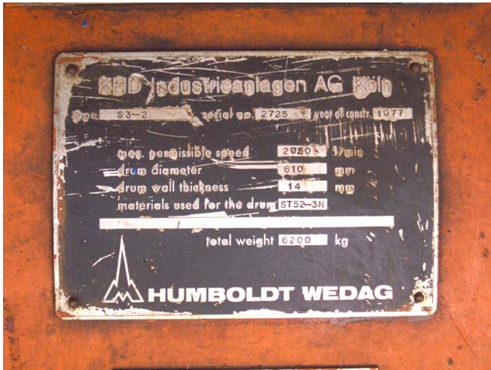
Bild 27: Esfahan, Kläranlage Süd: Schild an einer KHD-Zentrifuge (Baujahr 1977)
