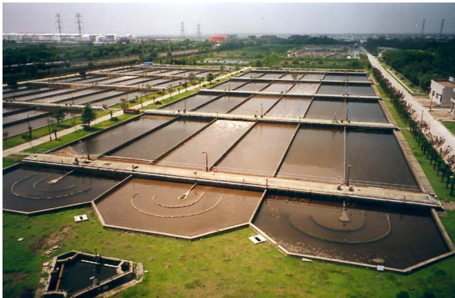
Bild 12: Abwasserbehandlungsanlage der SPC
