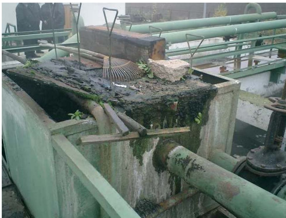
Bild 18: Wartungszustand Rücklaufschlamm-Verteilerschacht
