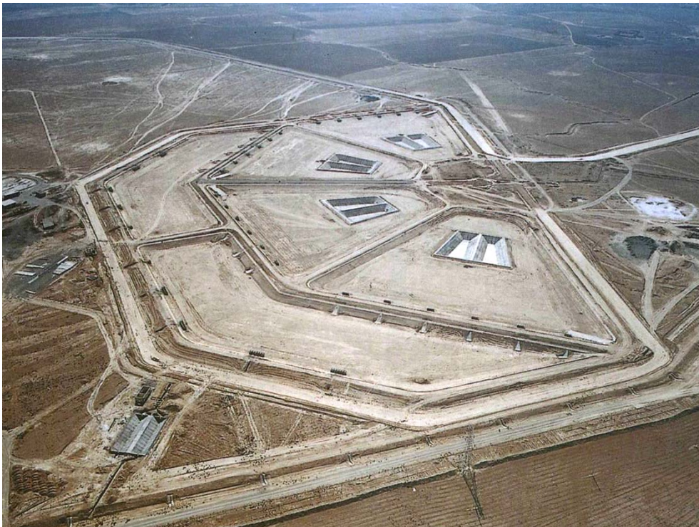
Bild 21: Kläranlage Mashhad East: Luftbild aus der Bauphase einer Straße
