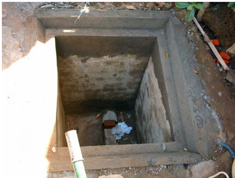
Bild 10: Übergabekontrollschacht, Denpasar-Entwicklungsprojekt
