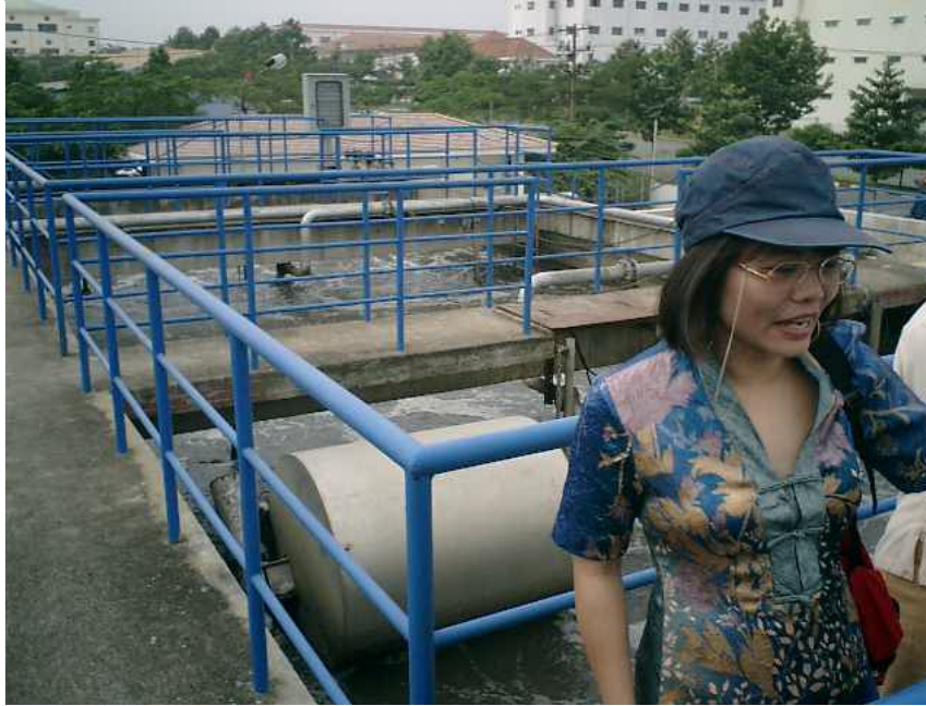
Bild 7.1: Biologische Kläranlage zur Reinigung von haushaltsähnlichen Abwässern aus einem großen Industriegebiet (50 000 Arbeitsplätze) in Saigon. Hier: Blick auf die Belebungsanlage (SBR-Reaktor, Aufstauverfahren).
