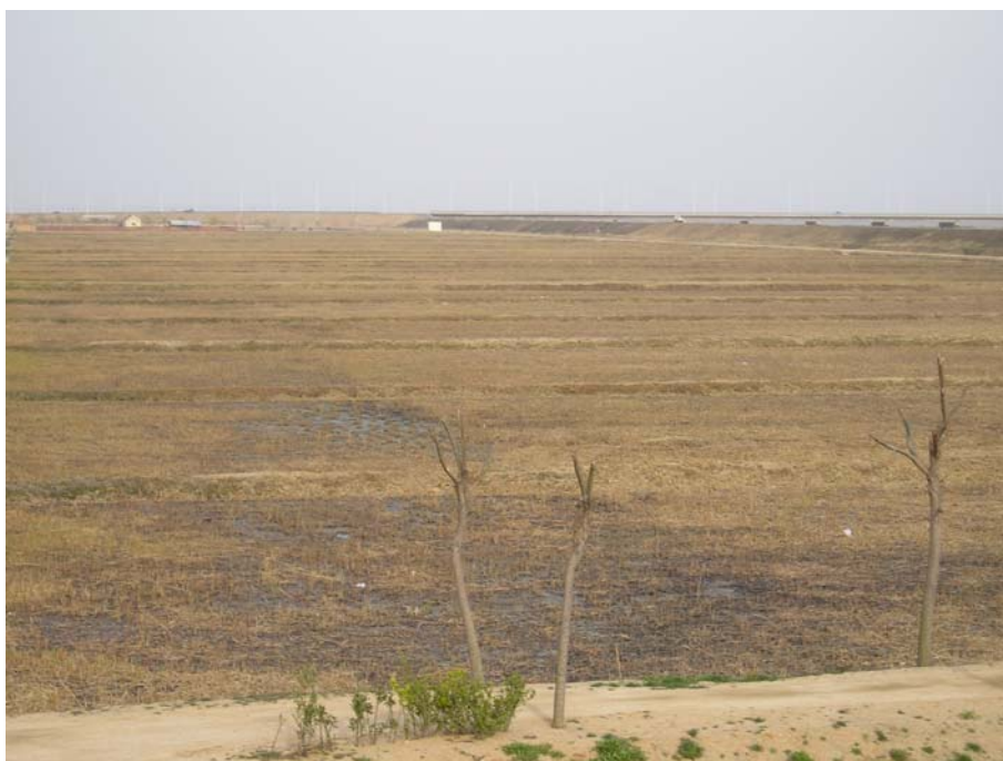
Bild 7: Pflanzenkläranlage Qingdao (Jiaonan)
