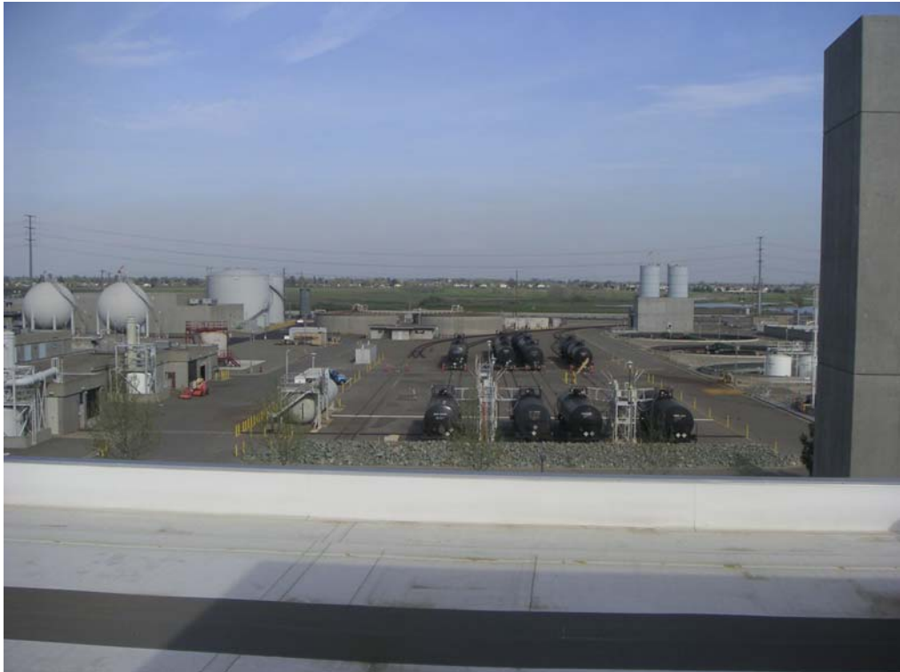
Bild 6: Bahnanlagen im Klärwerk Sacramento
