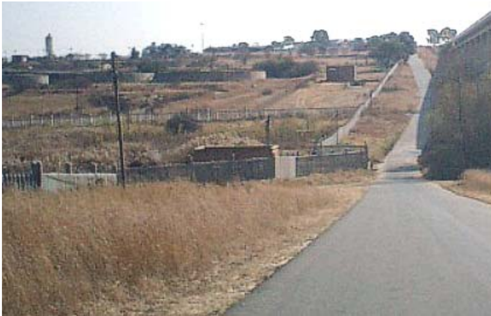
Bild 4: Sicherheitsmauer um das Großklärwerk Johannesburg Nord
