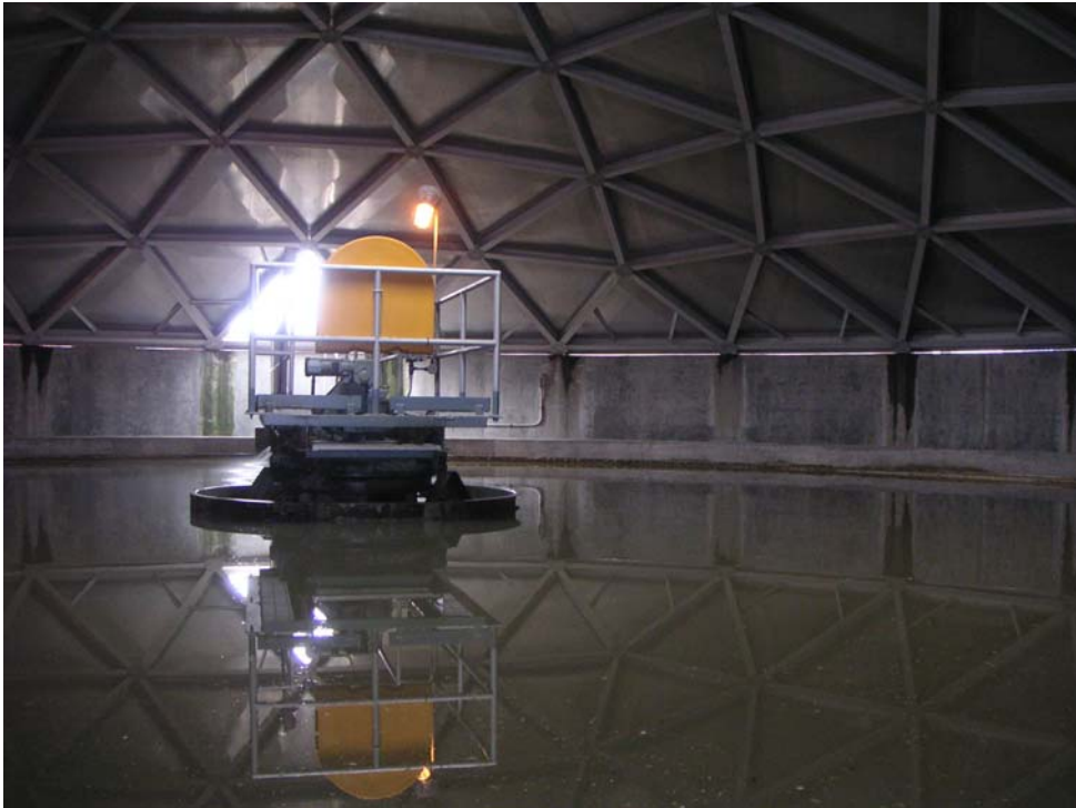
Bild 4: Vorklärbecken des Klärwerks in Truckee
