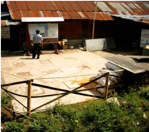
Bild 21: Anaerobfilter (links, Aufsicht), Biogasbehälter (links, überbaut am rechten Bildrand) und Schema der Anlage Mekarsari Sari Jaya, Tahu-Tempe (rechts) (DEWATS, 2004)
