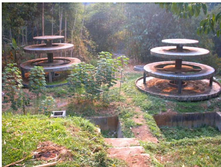
Bild 23: Tropfkörperbelebungsanlage für die Behandlung von 2 500 Hausanschlüssen in Soreang, Westjava
