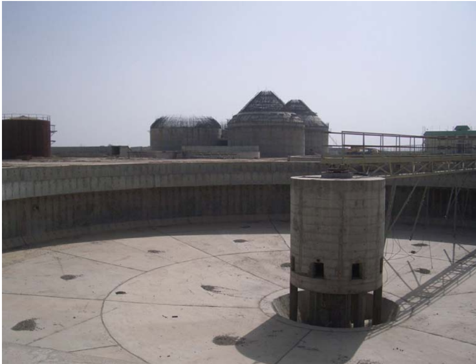
Bild 31: Esfahan, Baustelle für die neue AB-Anlage
