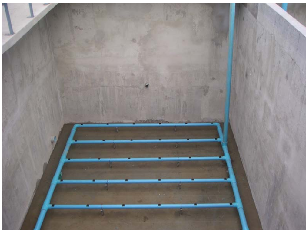
Bild 8: SB-Reaktor in einem lebensmittelverarbeitenden Betrieb (im Bau)
