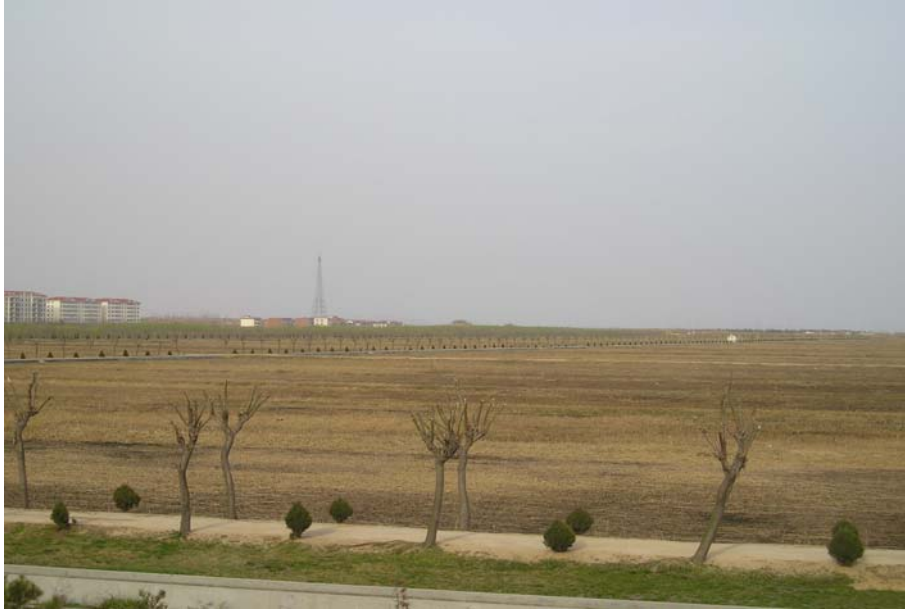
Bild 8: Pflanzenkläranlage Qingdao (Jiaonan)
