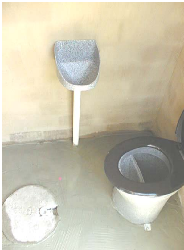
Bild 9: Innenansicht der Toilette; positioniert über der rechten Kammer (mit Montagemöglichkeit links über der linken Kammer, sobald die rechte Kammer voll ist)
