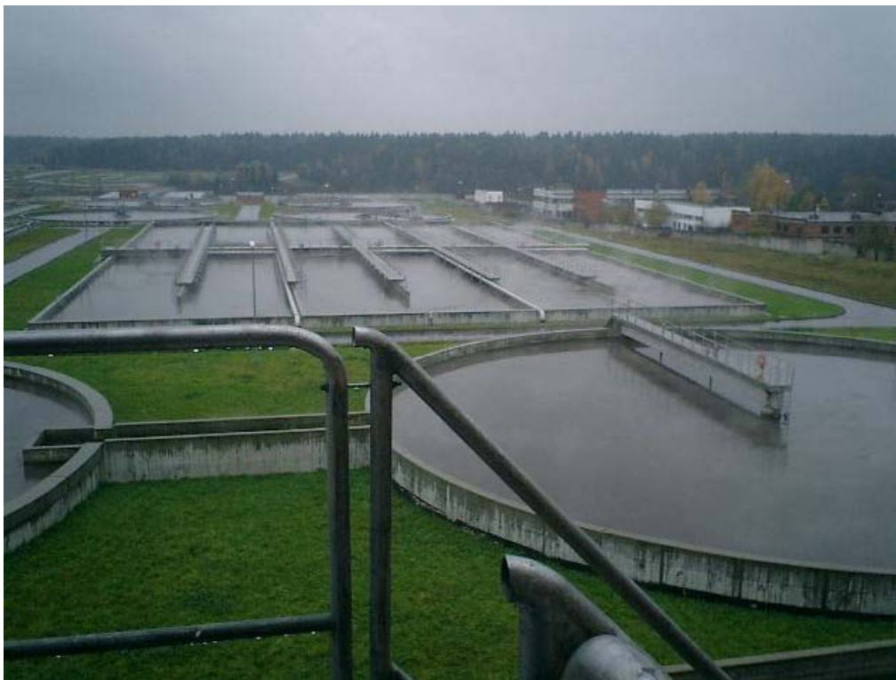
Bild 11: Klärwerk Butowo: Vorgeschaltete runde Bio-P-Becken und nachgeschaltete rechteckige Belebungsbecken
