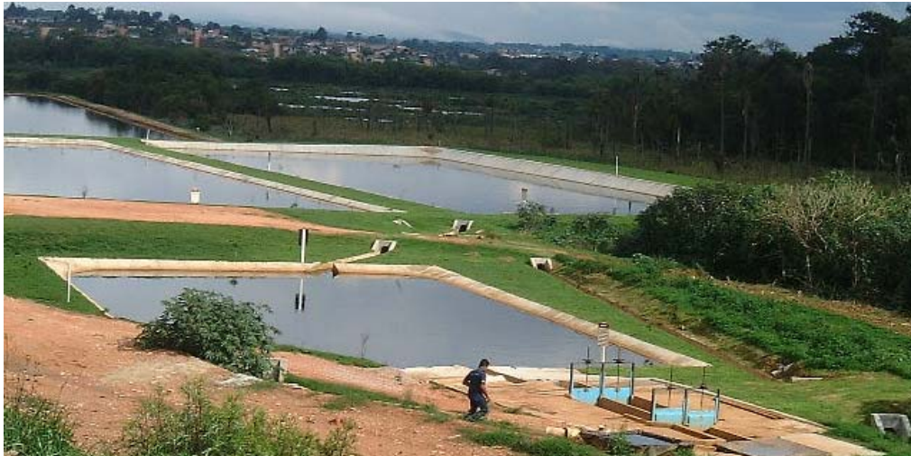
Bild 11: Abwasserteichanlage in Curitiba
