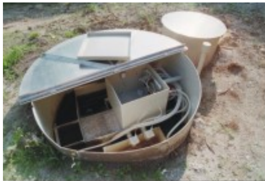
Bild 12: Hausklärwerk nach dem Belebungsprinzip
