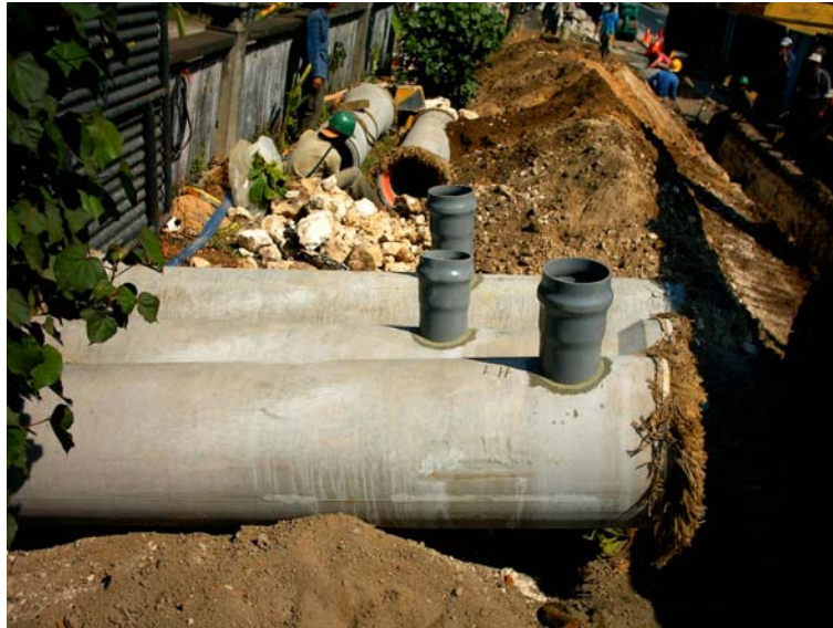
Bild 9: Kanalrohre mit Anschlussstutzen, Denpasar-Entwicklungsprojekt
