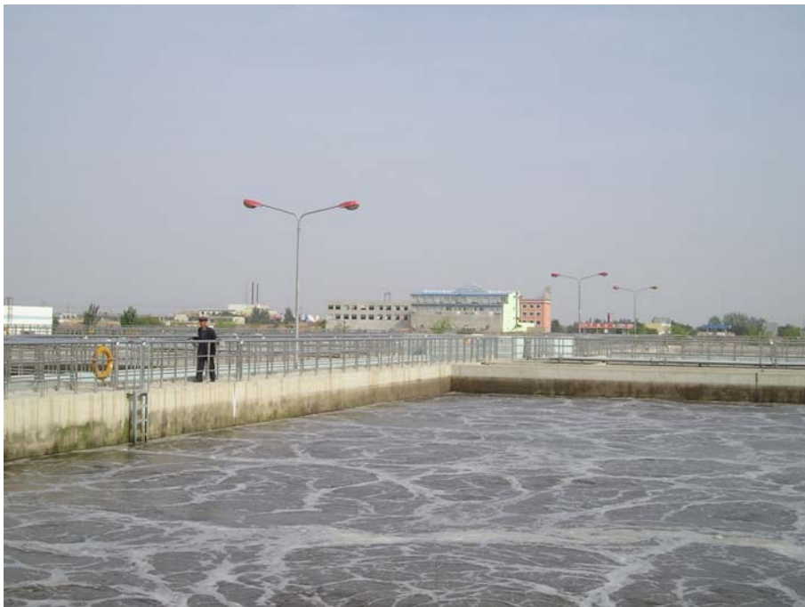
Bild 13: SBR-Reaktor Abwasserbehandlungsanlage Yinchuan
