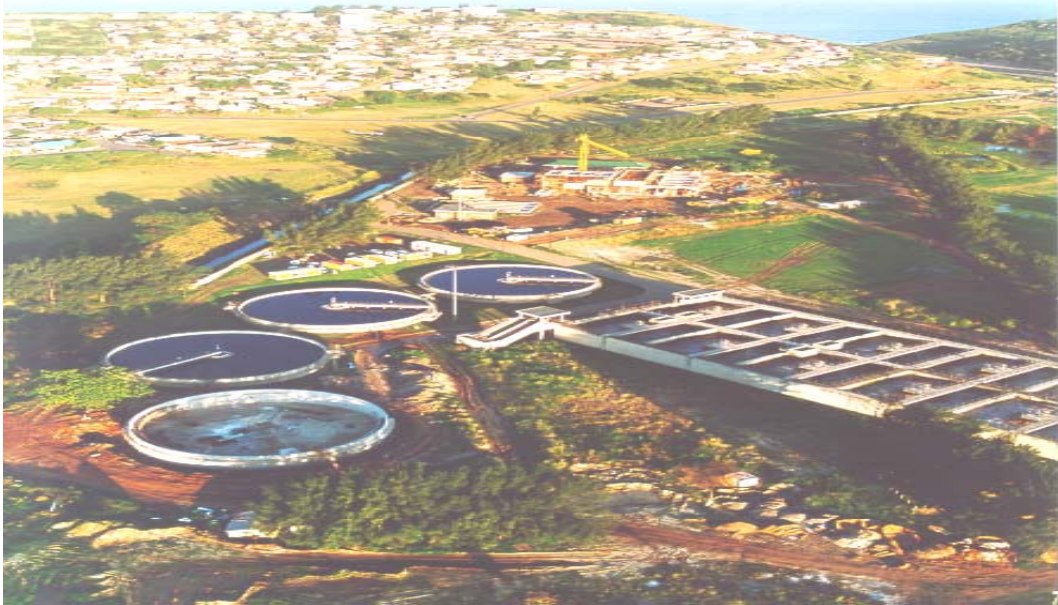
Bild 19: Luftbild Klärwerk Durban
