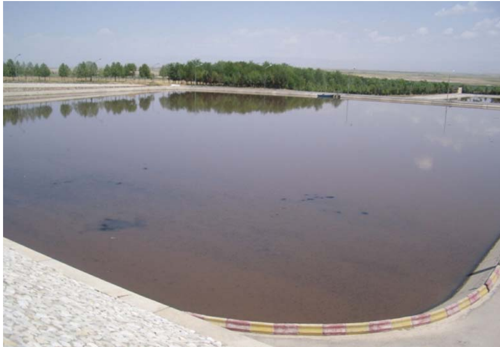
Bild 19: Kläranlage Mashhad West: Sedimentationsbecken
