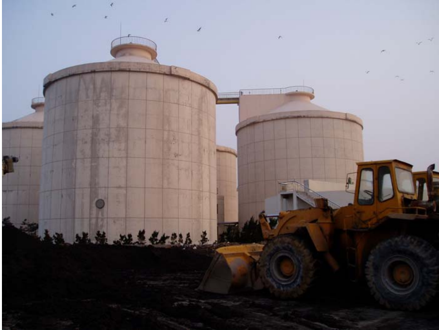
Bild 11: Faulbehälter Abwasserbehandlungsanlage Qingdao
