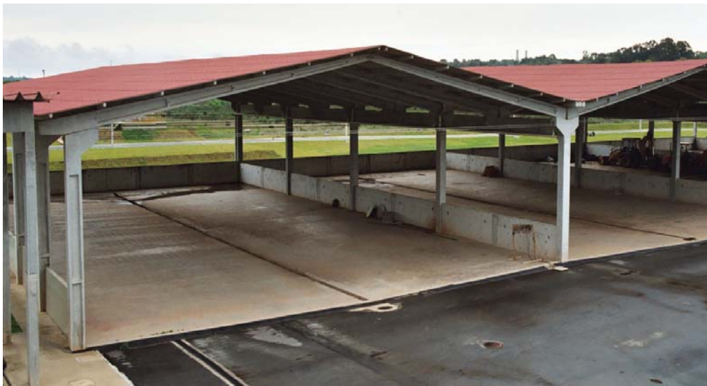
Bild 15: Überdachte Schlamm-trockenbeete in Curitiba
