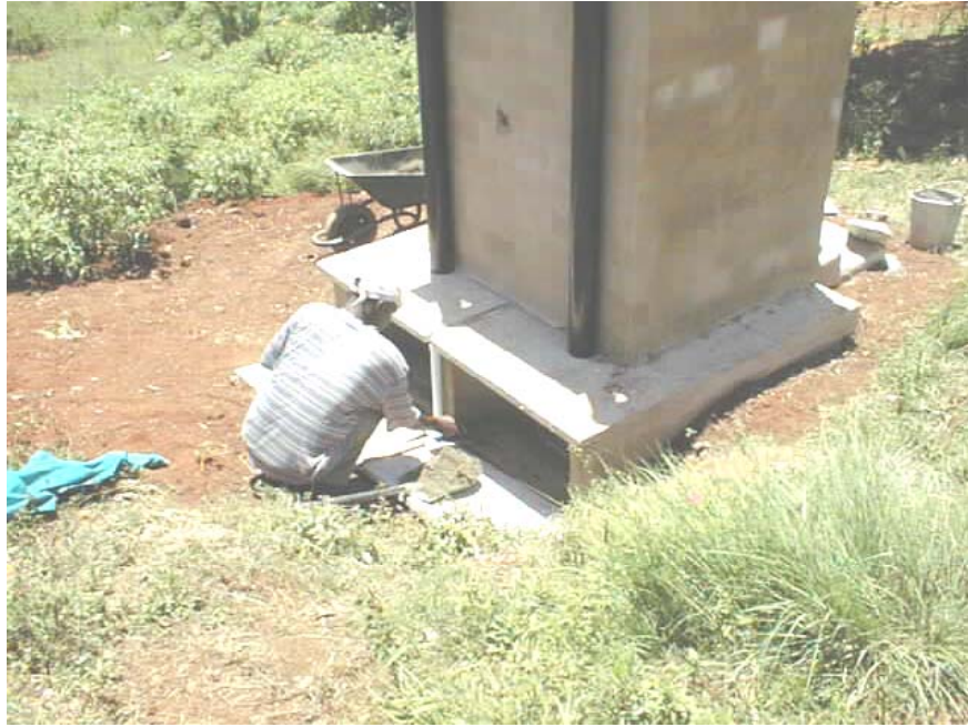
Bild 8: Ländliche Außentoilette ohne Kanalanschluss. Sichtbar sind zwei Fäkalsammelkammern, die wechselweise beschickt und entleert werden.
