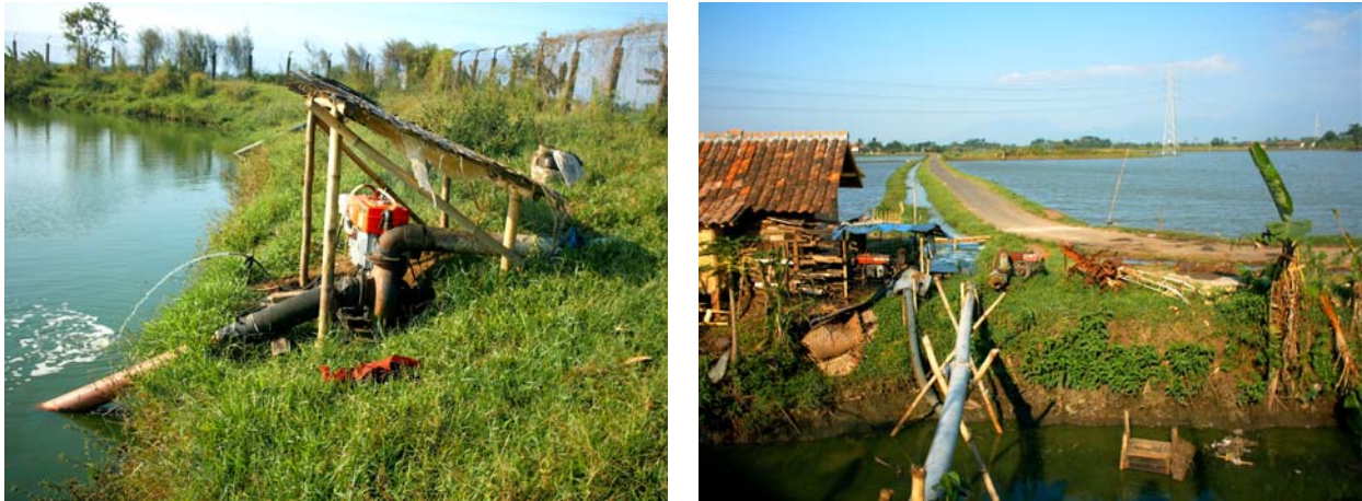
Bild 25: Wasserentnahmepumpen am Schönungsteich der KA Bojong_Soang, Bandung, zur Befüllung der Fischteiche
