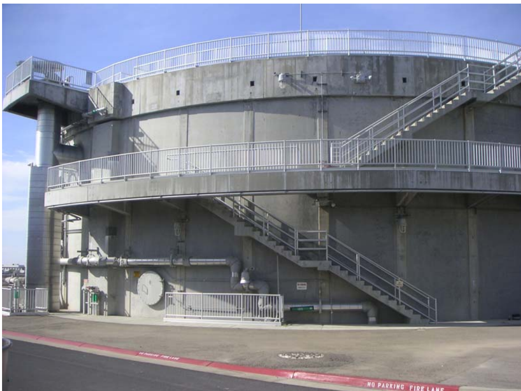
Bild 7: Faulbehälter im Klärwerk Sacramento
