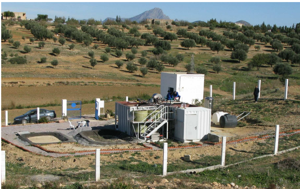
Abbildung 4.6.2 : Gesamtansicht der Anlage zum Projektende 2010
