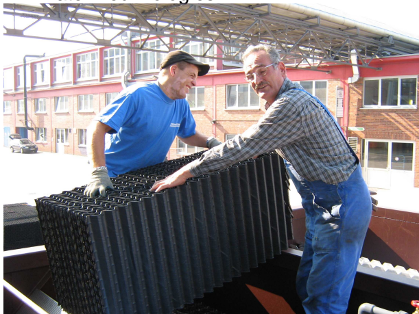
Abbildung 4.2.3: Einbau der Festbett-Füllkörper durch Beschäftigte der GEA 2H-Water Technologies
