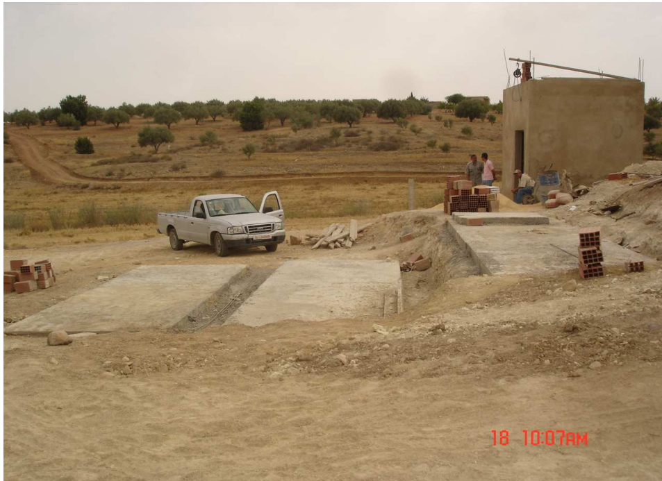
Abbildung 4.6.1: Infrastrukturvorbereitung für den Betrieb der Anlage; vorn: die Fundamente; hinten: Betriebsgebäude
