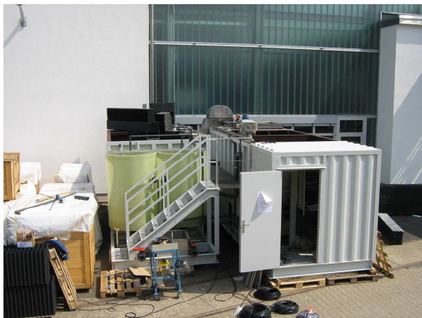
Abbildung 4.2.1: Gesamtansicht der Containerkombination auf dem Betriebsgelände der GEA 2H-Water Technologies
