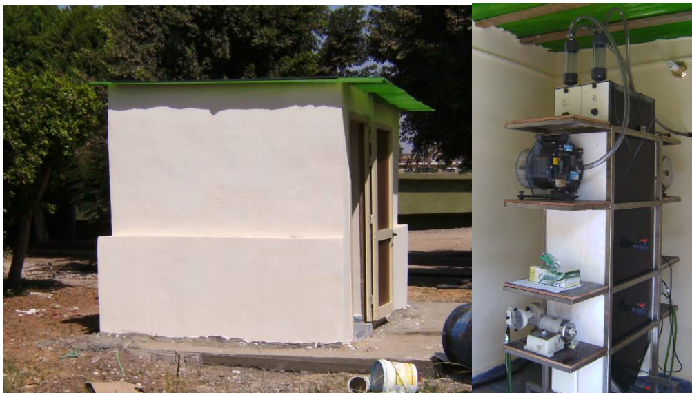
Abbildung 27: Schutzhütte für die Laboranlagen
