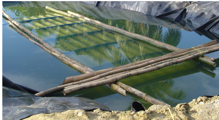
Abbildung 24: Anwendung des Dreiphasenabscheiders in einem Abwasserteich [Verink, 2006]
