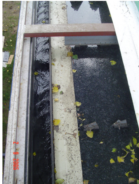
Abbildung 11: Tauchschild vor dem Ablauf des UASB-Reaktors
