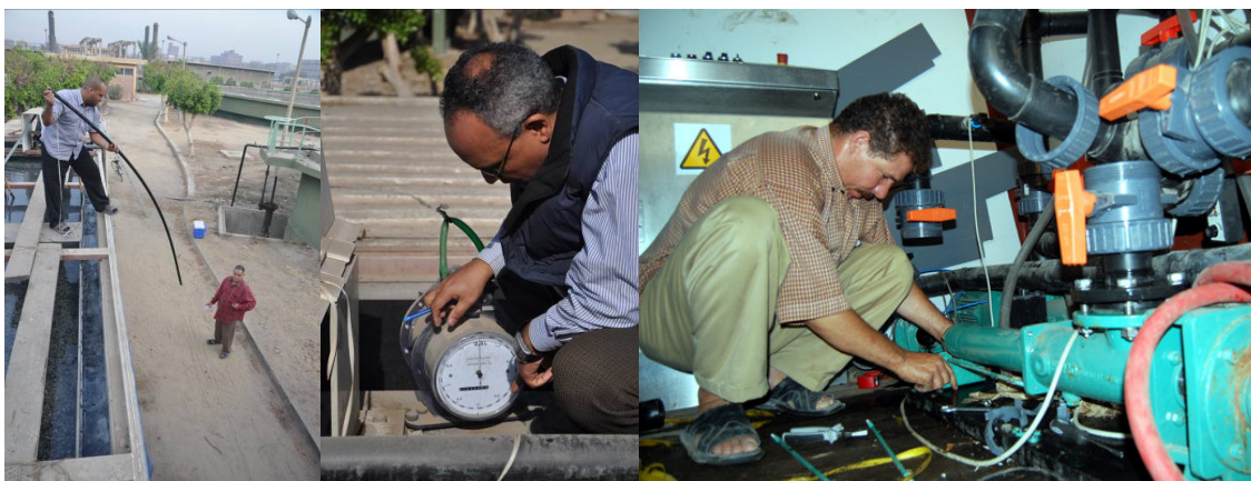
Abbildung 20: Probennahme zur Bestimmung des Feststoffgehaltes (links), Ablesen der Gasuhr (Mitte), Pumpenreparatur
