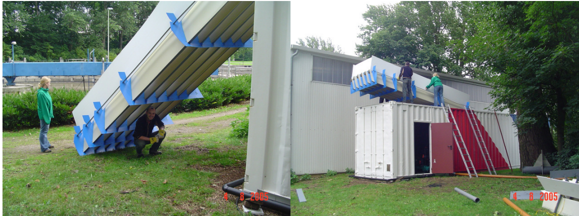
Abbildung 8: Einsetzen des Dreiphasenabscheiders
