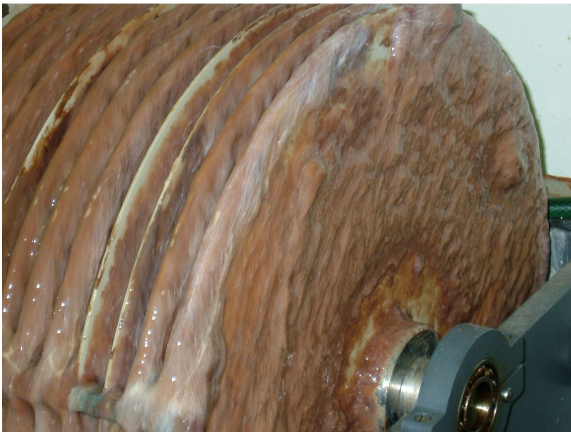
Abbildung 20a: Oben: Gesamtansicht der beiden Versuchskläranlagen (Scheibentauchkörper) der Universität Karlsruhe. Unten: Detailansicht des Biofilms auf den Scheiben der „großen“ Versuchsanlage.
