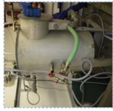
3 - Vorlagebehälter mit Vorreinigung Volumen: ~ 400 l
