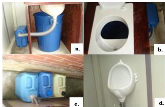
Fig. 8: Módulo 2 (Escuela Guacamayas): a-b) modelo de asiento sanitario con sus tanques de almacenamiento, c-d) modelo de orinal y sus tanques recolectores de orina. (Fuente: Gutiérrez, C. y Rodríguez, N. 2012)
