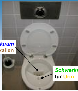
Roediger Vakuum-Trenntoilette im Klärwerk Stahnsdorf
