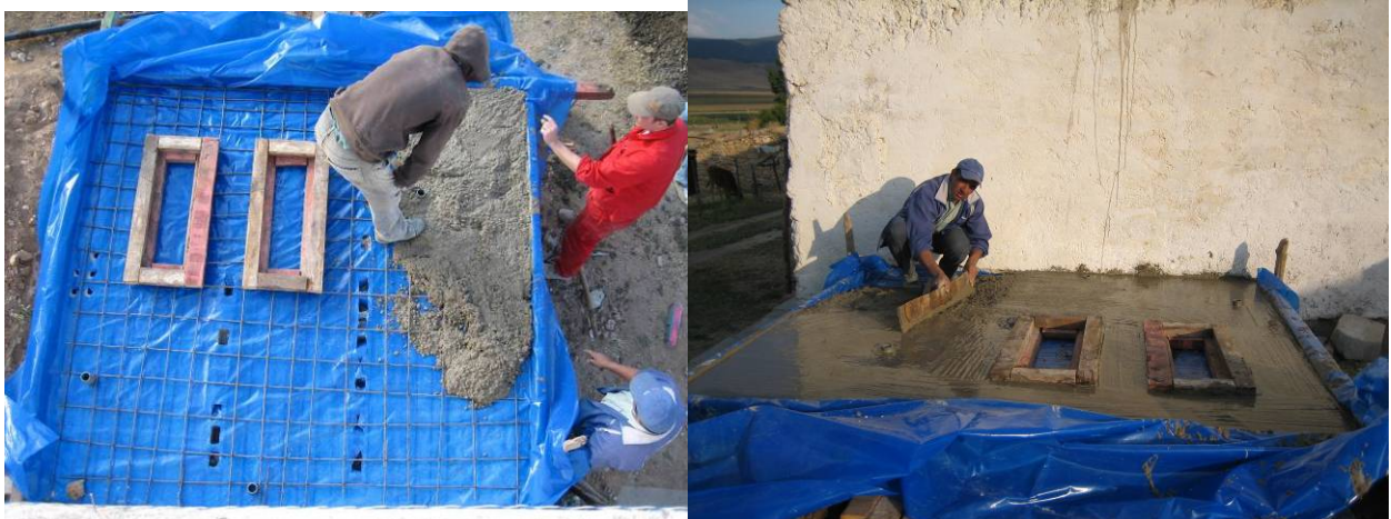
Fig. 46 : Pouring groundplate at Jane
