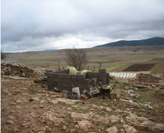
Fig. 24 : Faeces chamber walls
